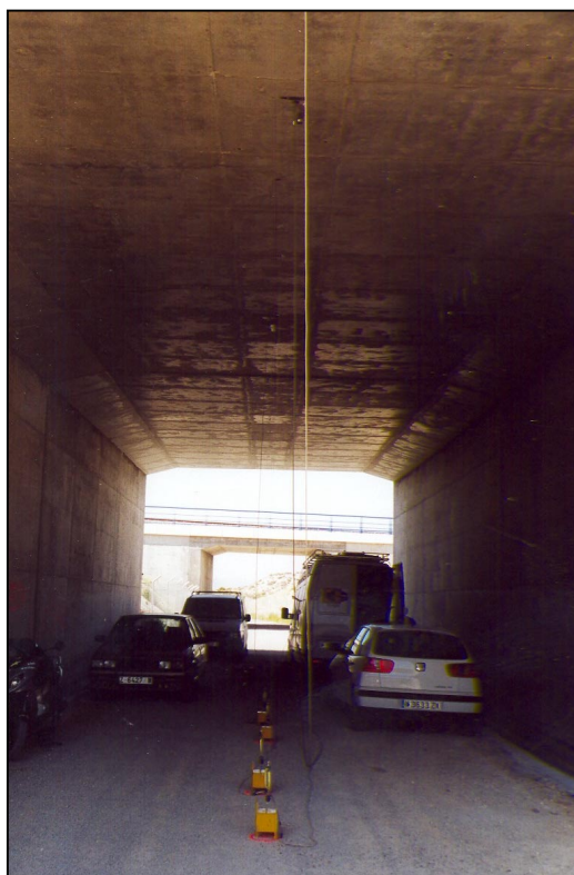
Nº 1.- Colocación de la instrumentación.
