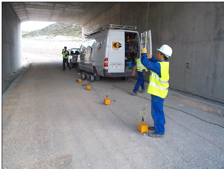
Nº 2.- Colocación de instrumentación
