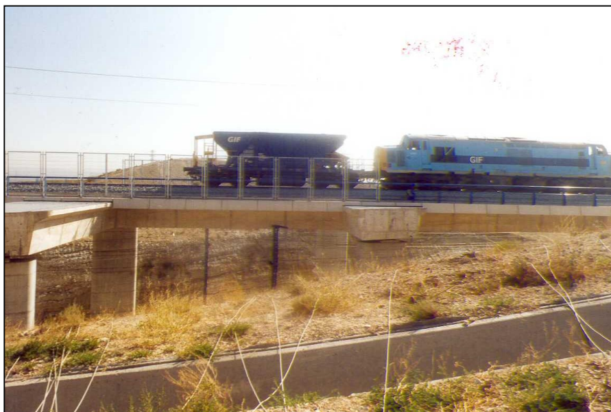
Nº 3.- Prueba de carga estática en vanos nº 2 y nº 3, con una locomotora y una tolva, visto desde el lado de Madrid.
