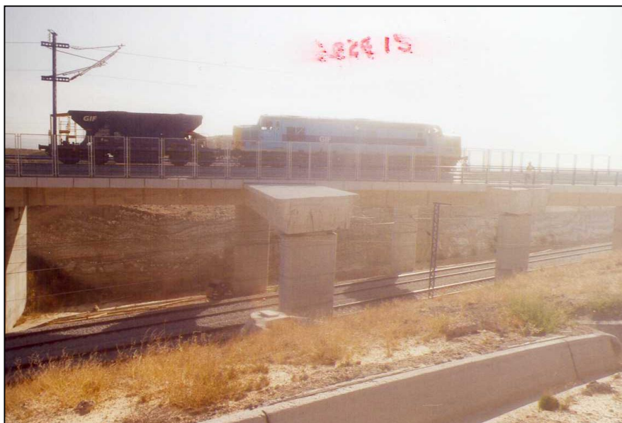
Nº 2.- Prueba de carga estática en vanos nº 1 y nº 2, con una locomotora y una tolva, visto desde el lado de Madrid.
