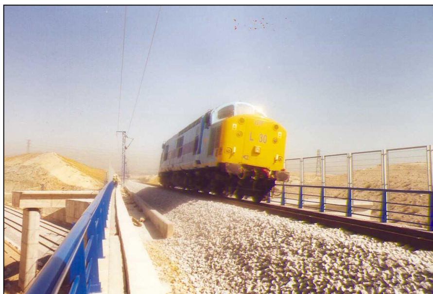
Nº 4.- Prueba de carga dinámica a 30 km/h con locomotora.
