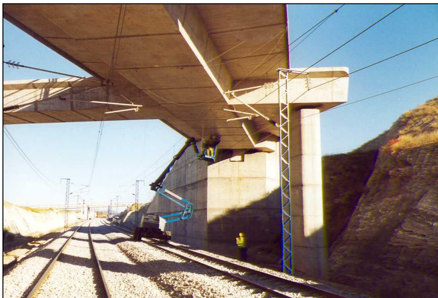
Nº 1.- Instrumentación mediante LVDT's en centro de luz.
