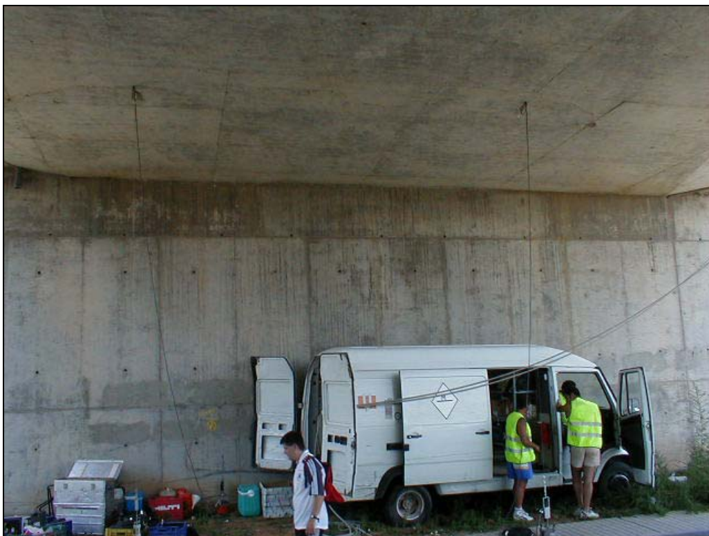
Foto 4: Estribo de salida (Zaragoza)
