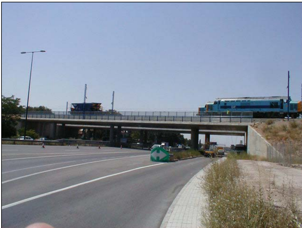
Foto 1: Alzado derecho de la estructura
