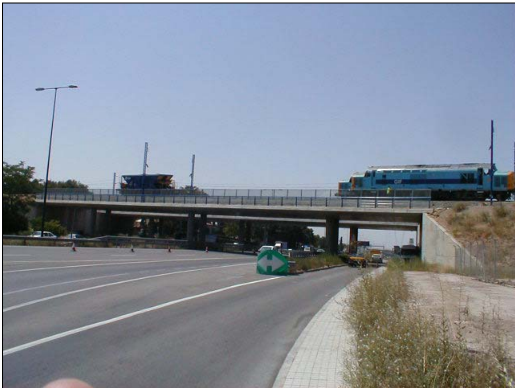
Foto 8: Proceso de Prueba de Carga
