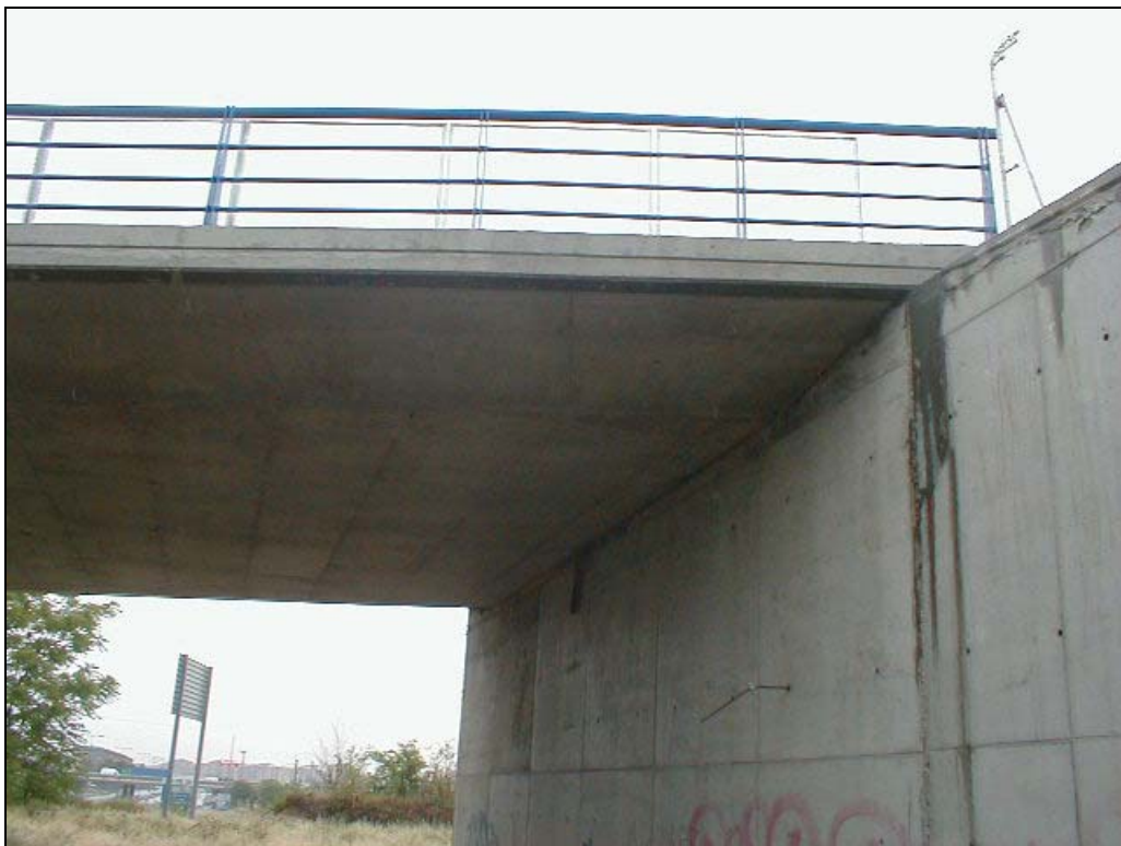
Foto 3: Estribo de entrada (Madrid)
