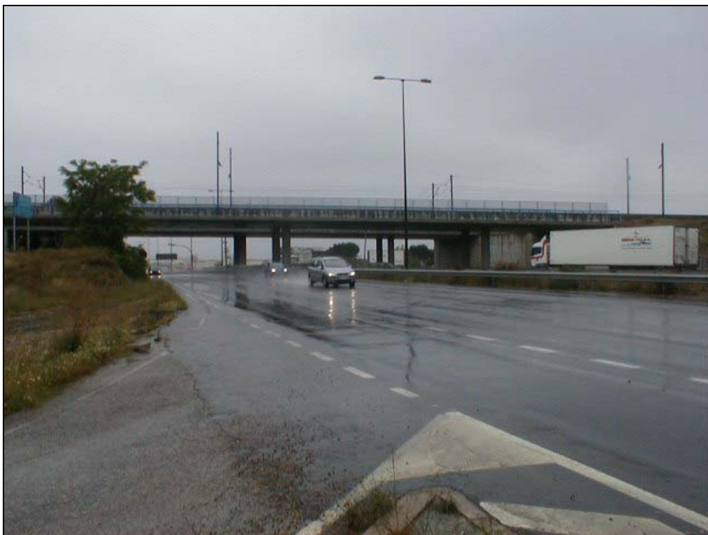
Foto 2: Alzado izquierdo de la estructura
