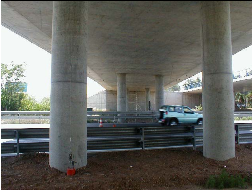
Foto 7: Vista inferior de la estructura
