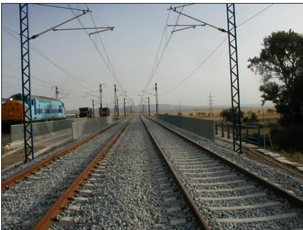
Foto 4: Vista superior desde salida (Zaragoza)
