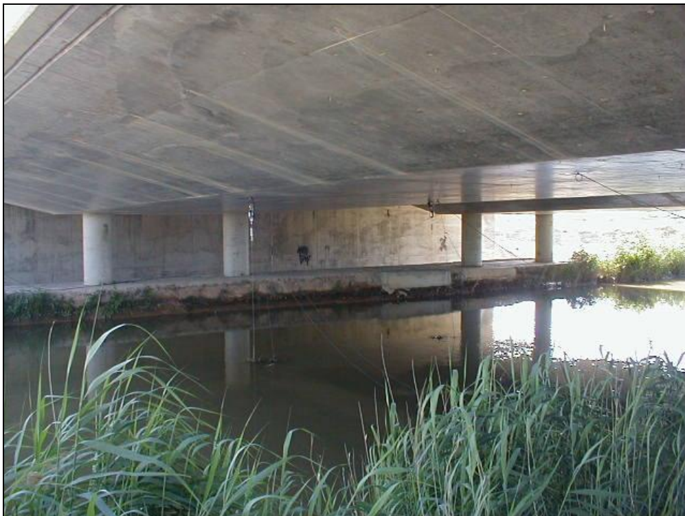
Foto 6: Estribo de salida (Zaragoza)
