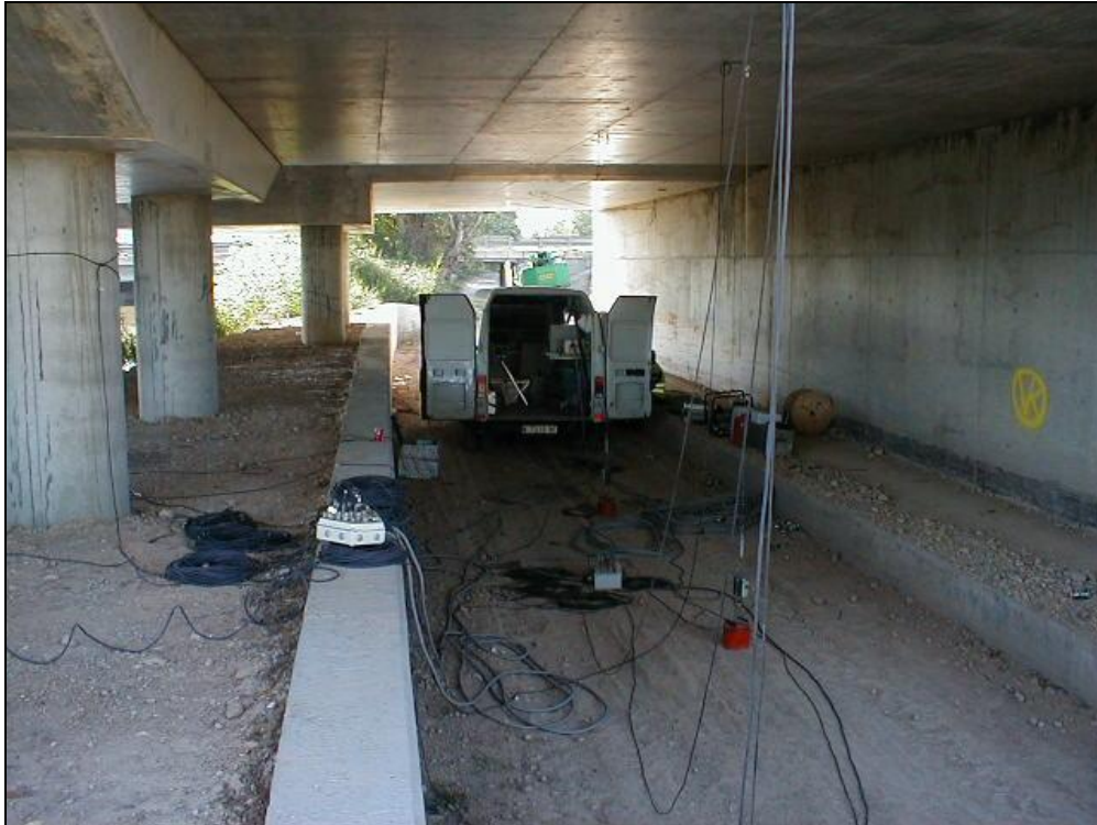
Foto 5: Estribo de entrada (Madrid)
