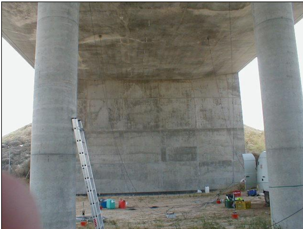
Foto 5: Estribo de entrada (Madrid)
