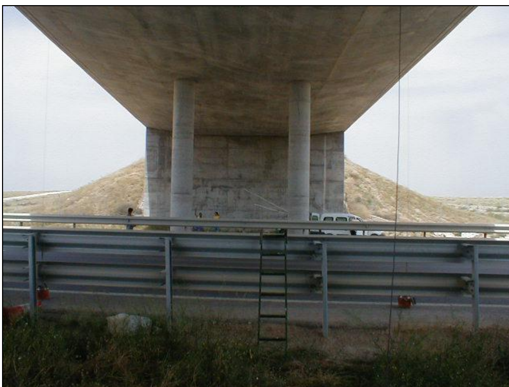
Foto 6: Estribo de salida (Zaragoza)
