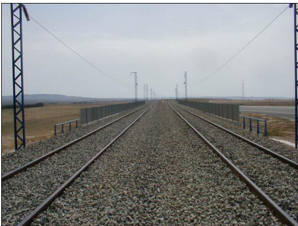
Foto 4: Vista superior desde salida (Zaragoza)
