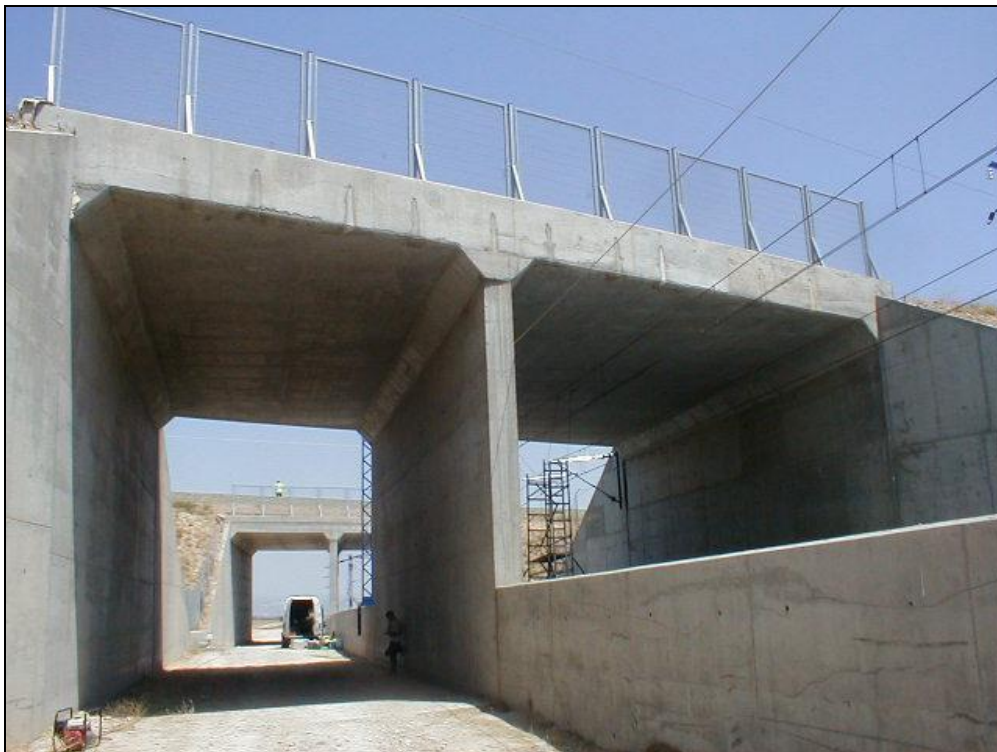
Foto 6: Estribo de salida (Zaragoza)
