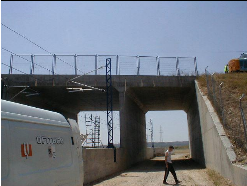
Foto 5: Estribo de entrada (Madrid)
