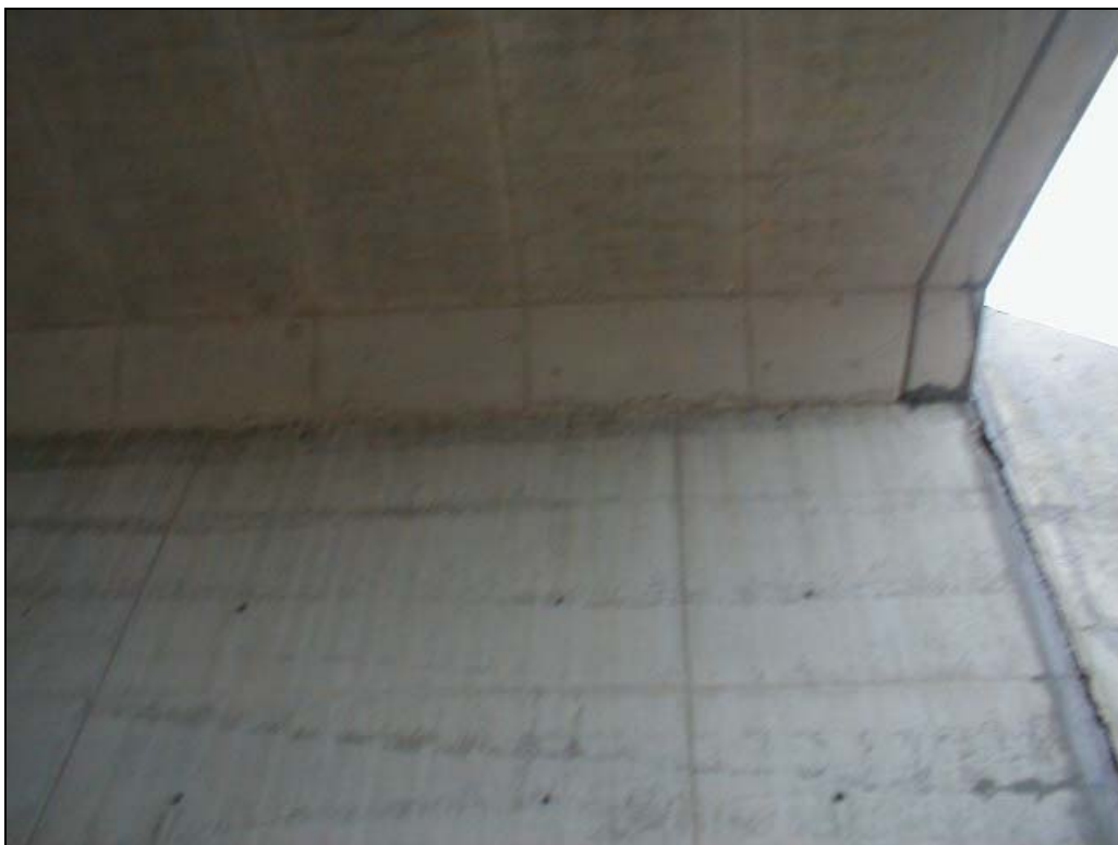
Foto 6: Estribo de salida (Zaragoza)
