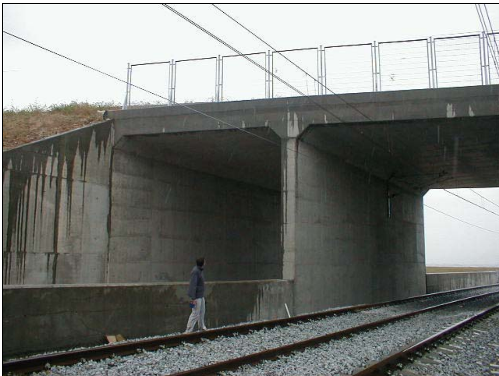
Foto 5: Estribo de entrada (Madrid)
