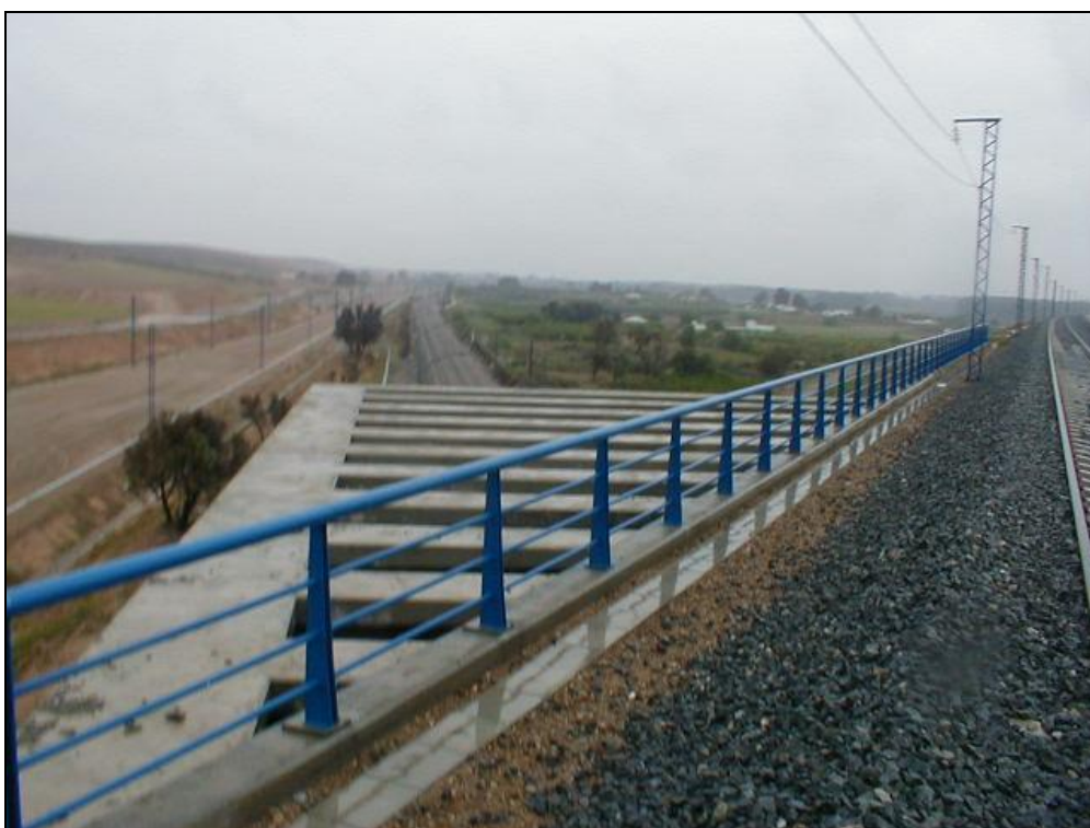
Foto 4: Vista superior desde salida (Zaragoza)
