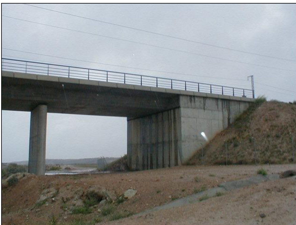
Foto 6: Estribo de salida (Zaragoza)
