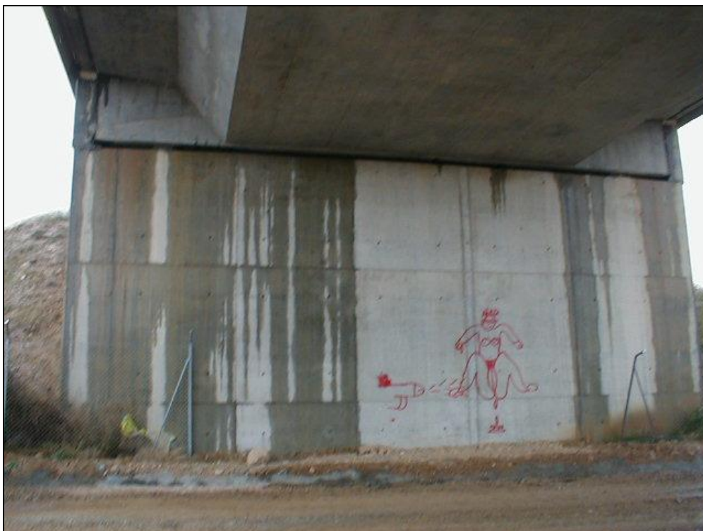
Foto 5: Estribo de entrada (Madrid)
