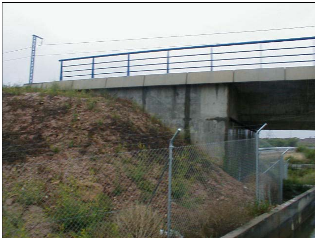
Foto 2: Alzado izquierdo de la estructura
