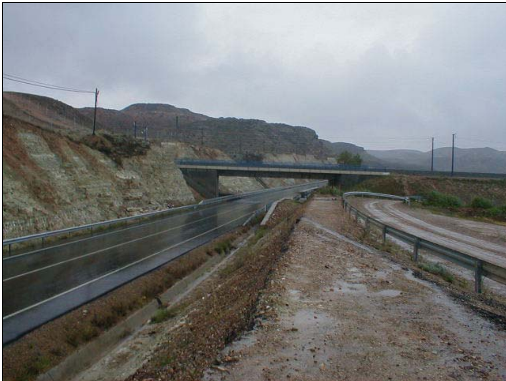
Foto 1: Alzado derecho de la estructura
