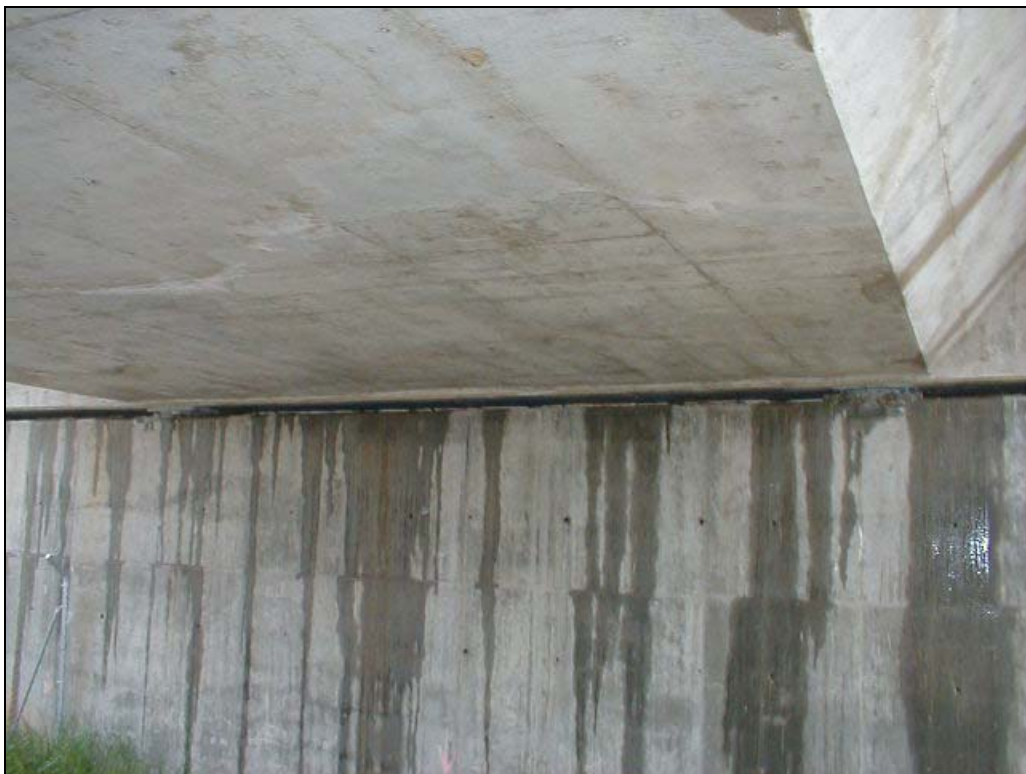
Foto 3: Estribo de entrada (Madrid)
