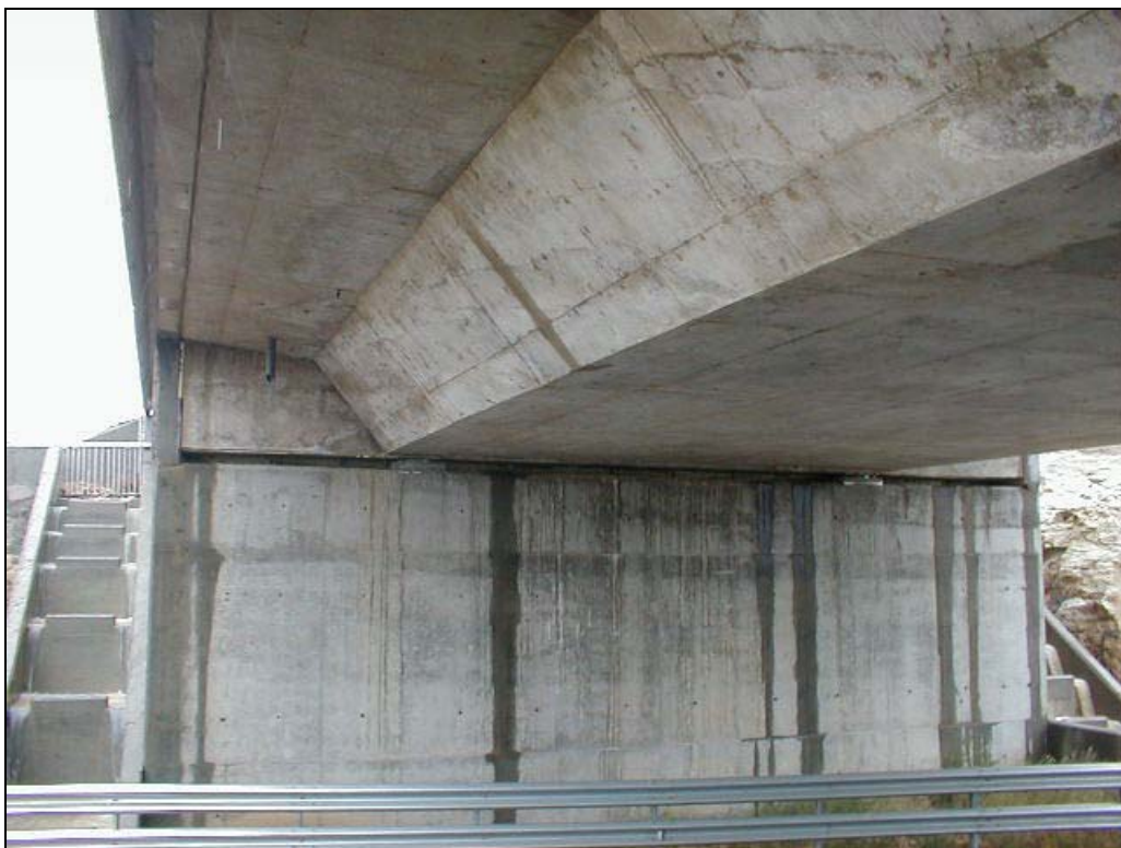
Foto 4: Estribo de salida (Zaragoza)
