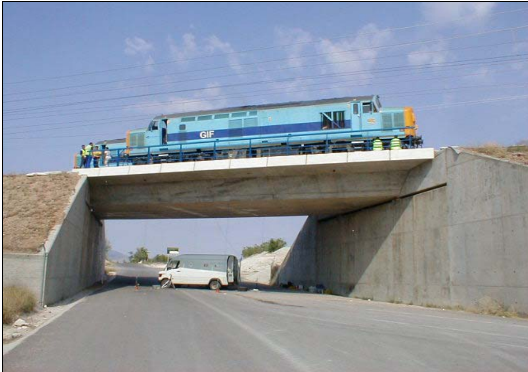
Foto 1: Alzado derecho de la estructura.
