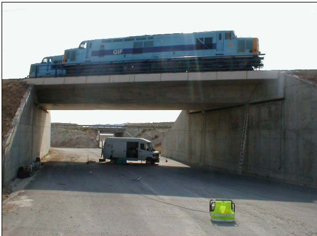
Foto 2: Alzado izquierdo de la estructura.
