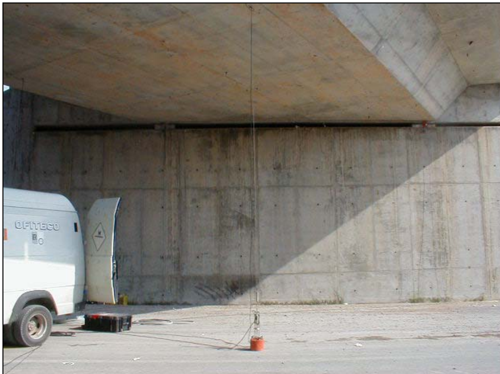
Foto 4: Estribo de salida (Zaragoza)
