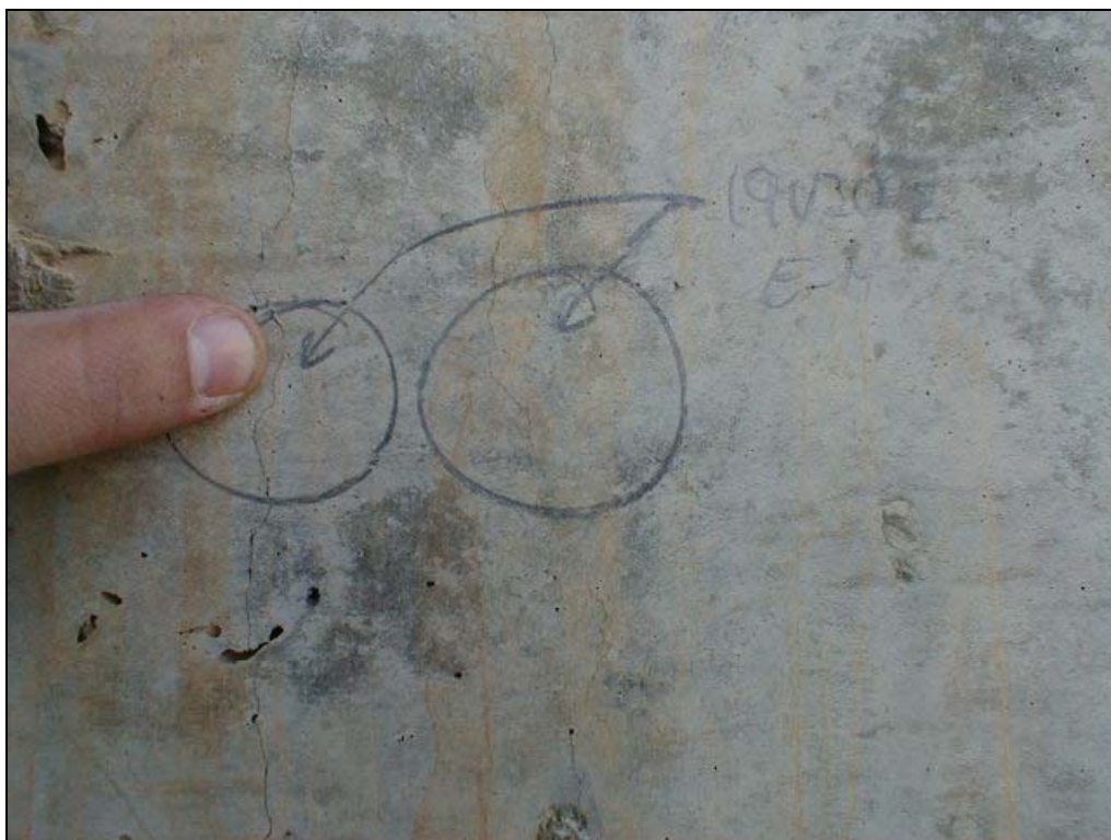
Foto 10: Fisuras en aleta.
