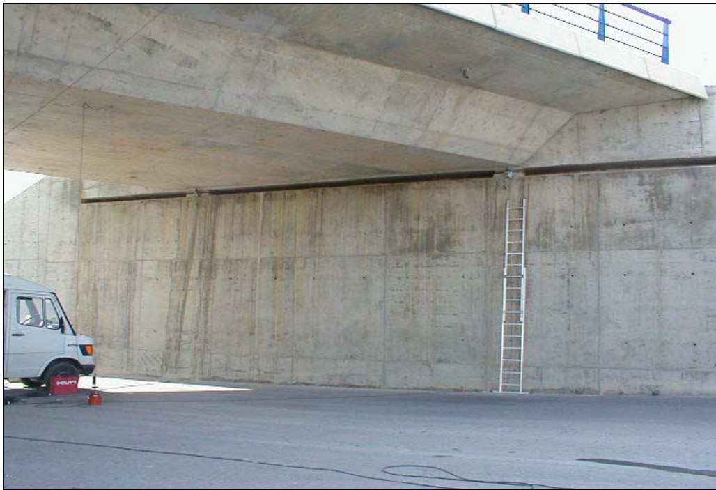
Foto 3: Estribo de entrada (Madrid).
