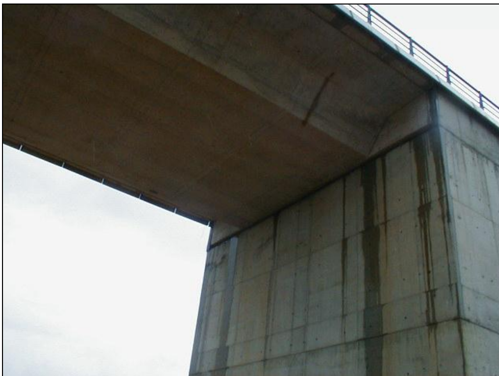
Foto 3: Estribo de entrada (Madrid)
