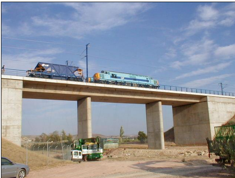
Foto 10: Proceso de prueba de carga
