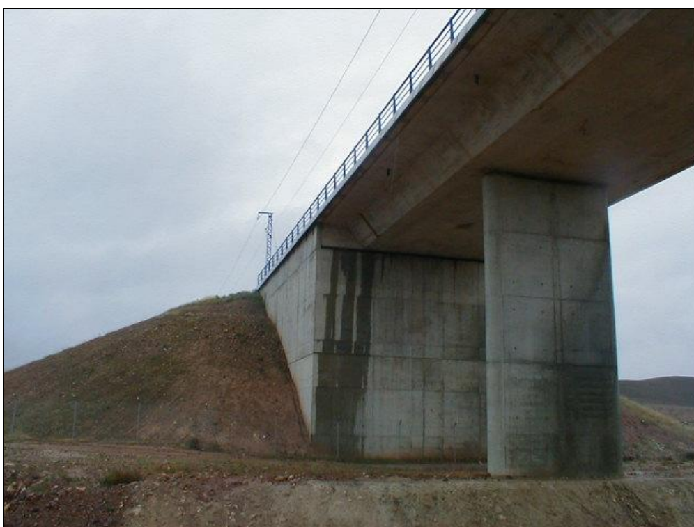
Foto 4: Estribo de salida (Zaragoza)
