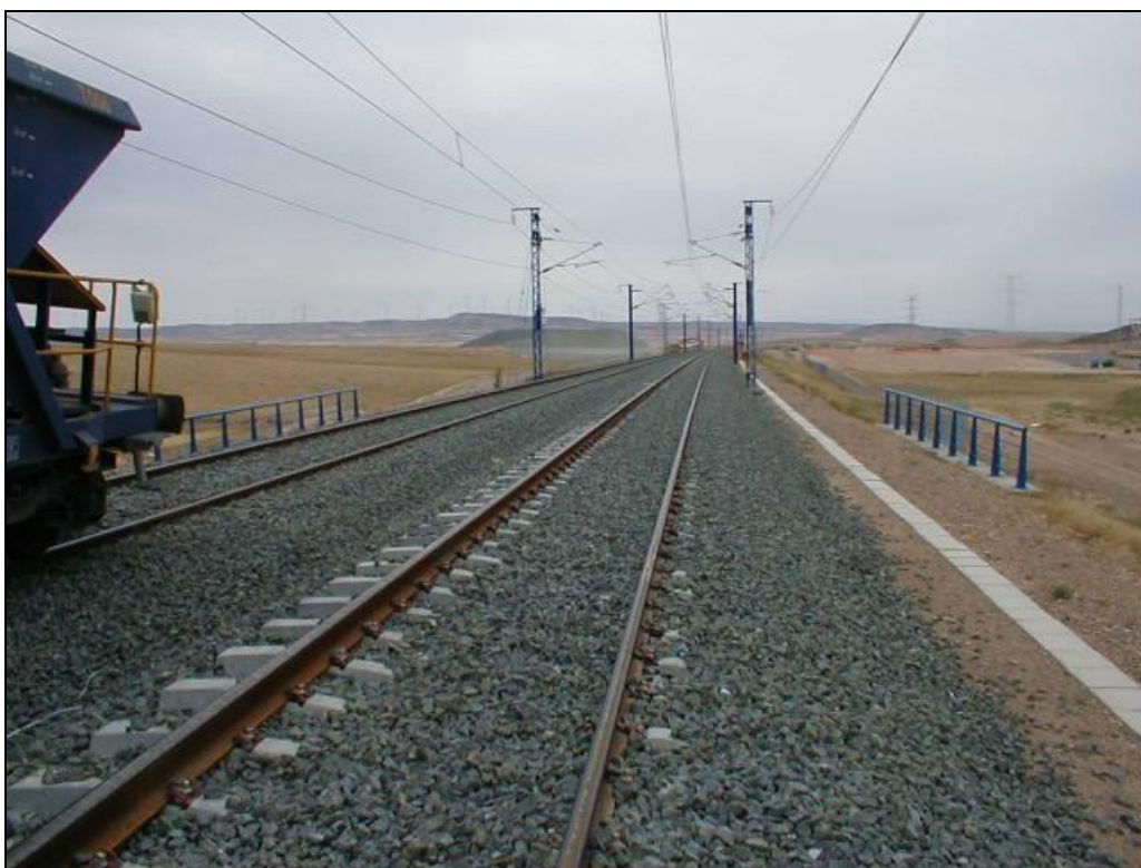
Foto 6: Vista superior estribo de salida sentido Madrid-Zaragoza.
