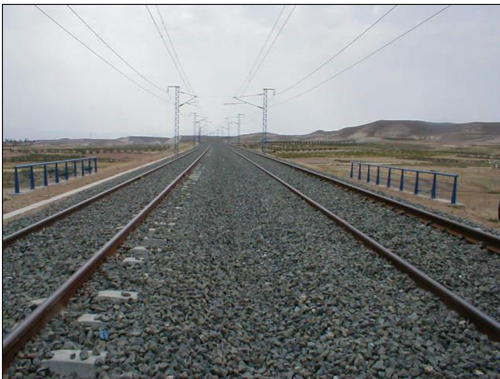
Foto 5: Vista superior estribo de entrada sentido Madrid-Zaragoza.
