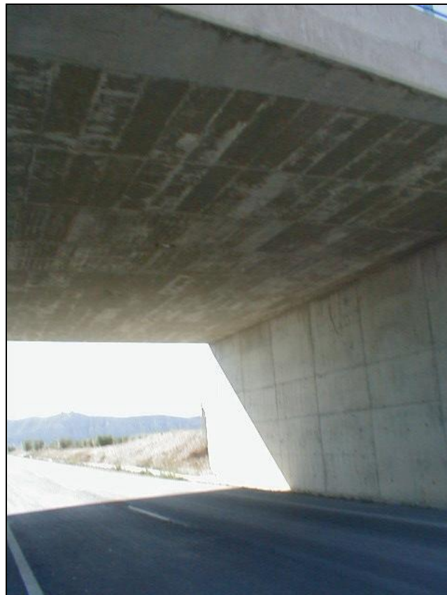
Foto 4: Vista inferior del tablero
