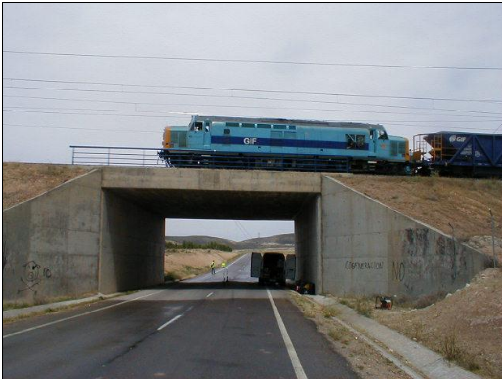
Fotos 3: Vista de los estribos durante la realización de la prueba de carga.
