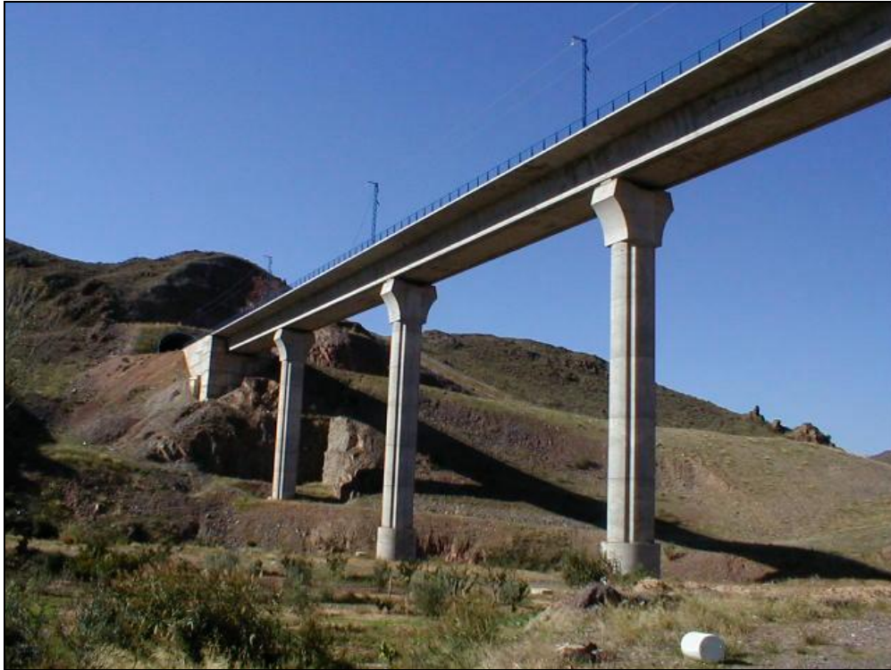
Foto 3: Estribo de entrada (Madrid)
