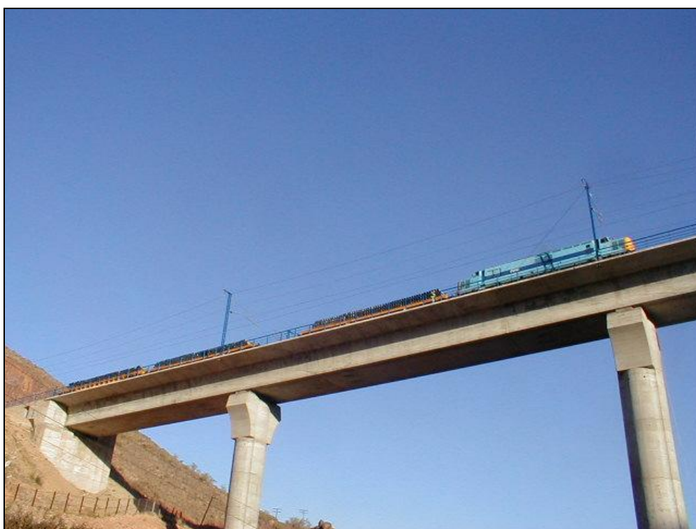
Foto 10: Proceso de prueba de carga
