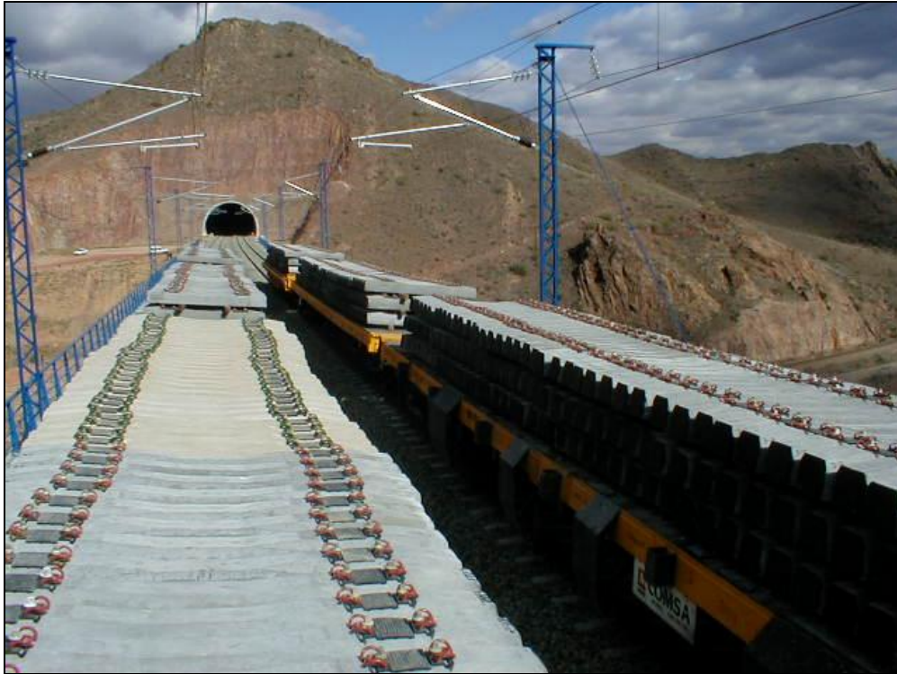
Foto 5: Vista superior desde entrada (Madrid)
