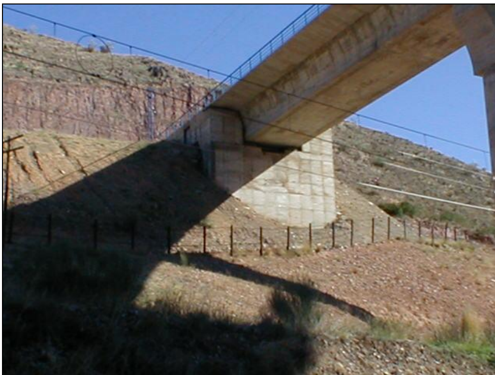
Foto 4: Estribo de salida (Zaragoza)
