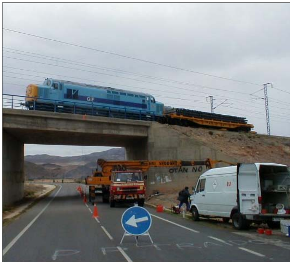
Foto 1: Alzado lateral derecho del marco durante el corte de carretera.
