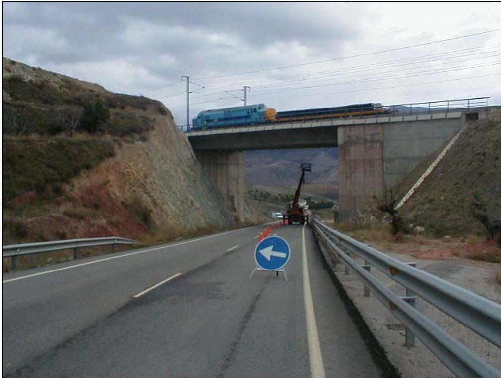
Foto 1: Alzado derecho del viaducto durante el corte de carretera.
