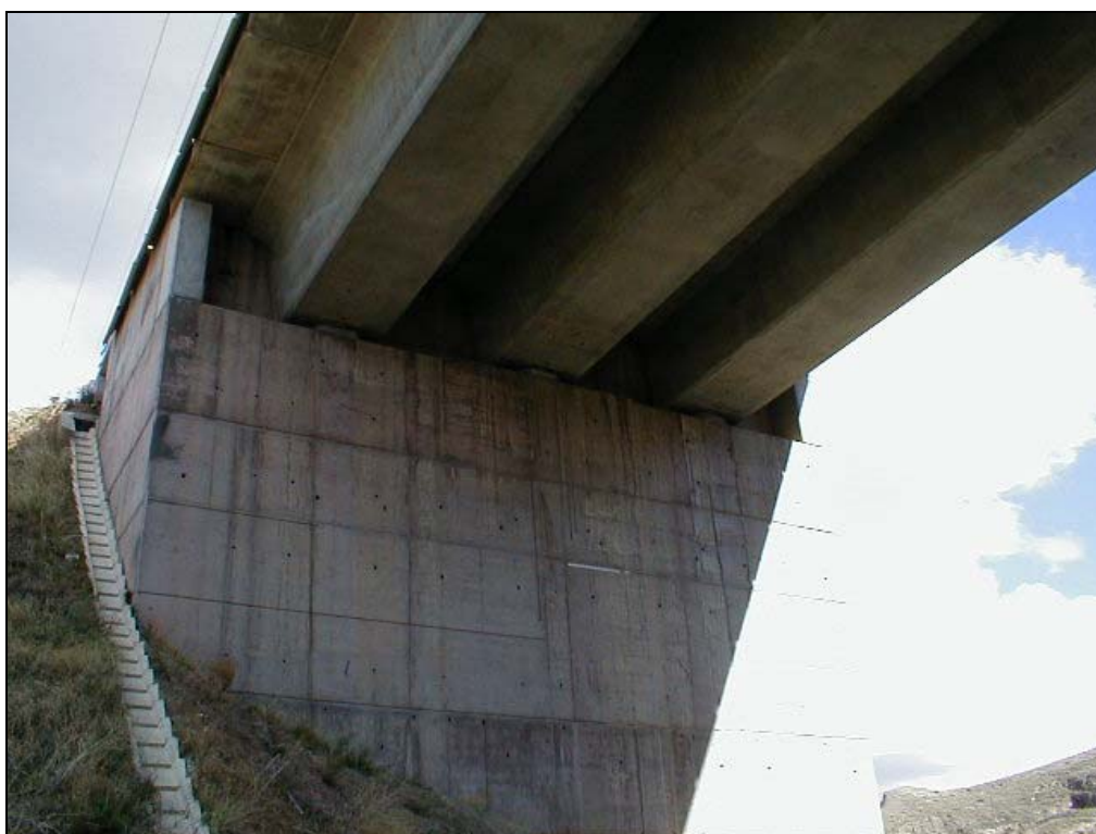
Foto 4: Detalle del estribo de salida (Zaragoza) del viaducto.
