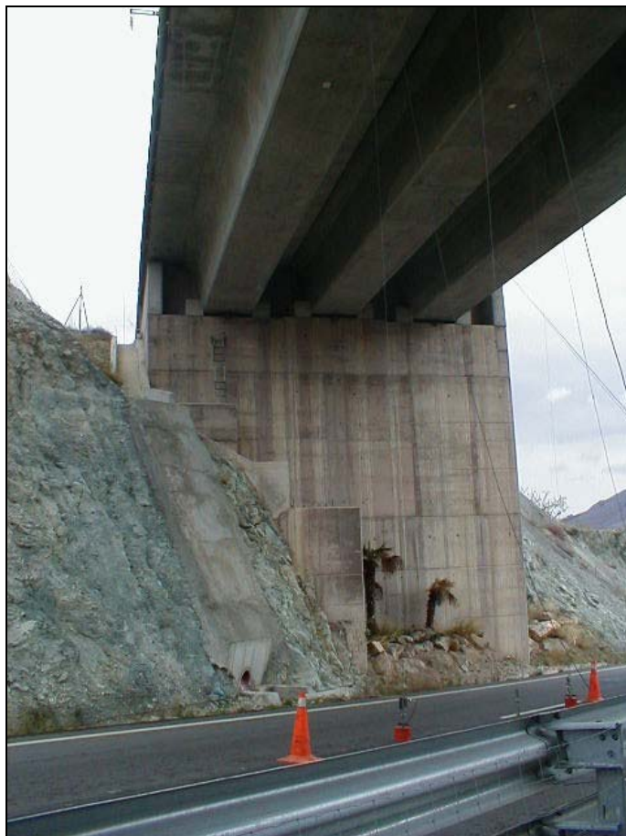
Foto 3: Vista inferior del estribo de entrada (Madrid).
