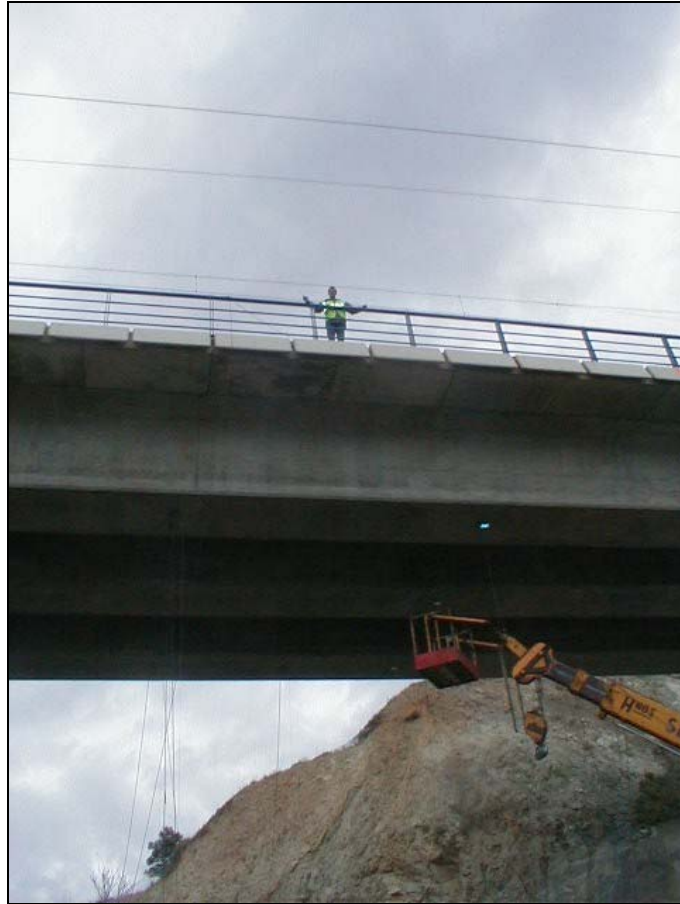
Foto 5: Vista inferior de la estructura durante la instrumentación.
