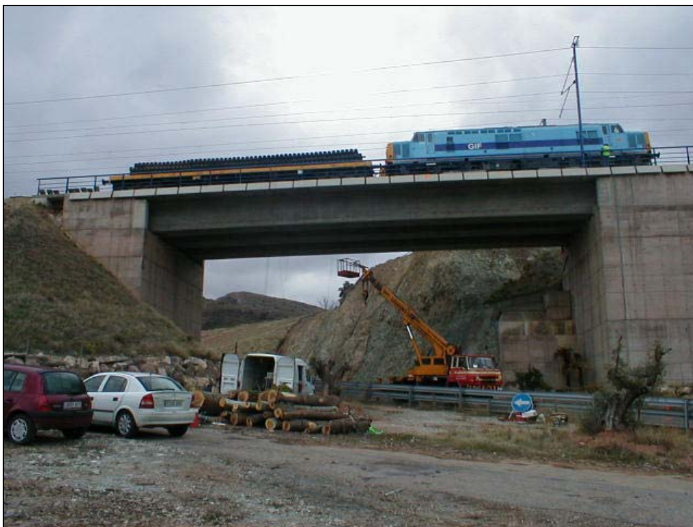
Foto 2: Alzada izquierdo del viaducto.
