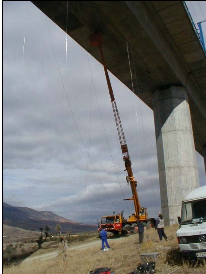
Foto 5: Vista inferior del viaducto durante la instrumentación de uno de los vanos.
