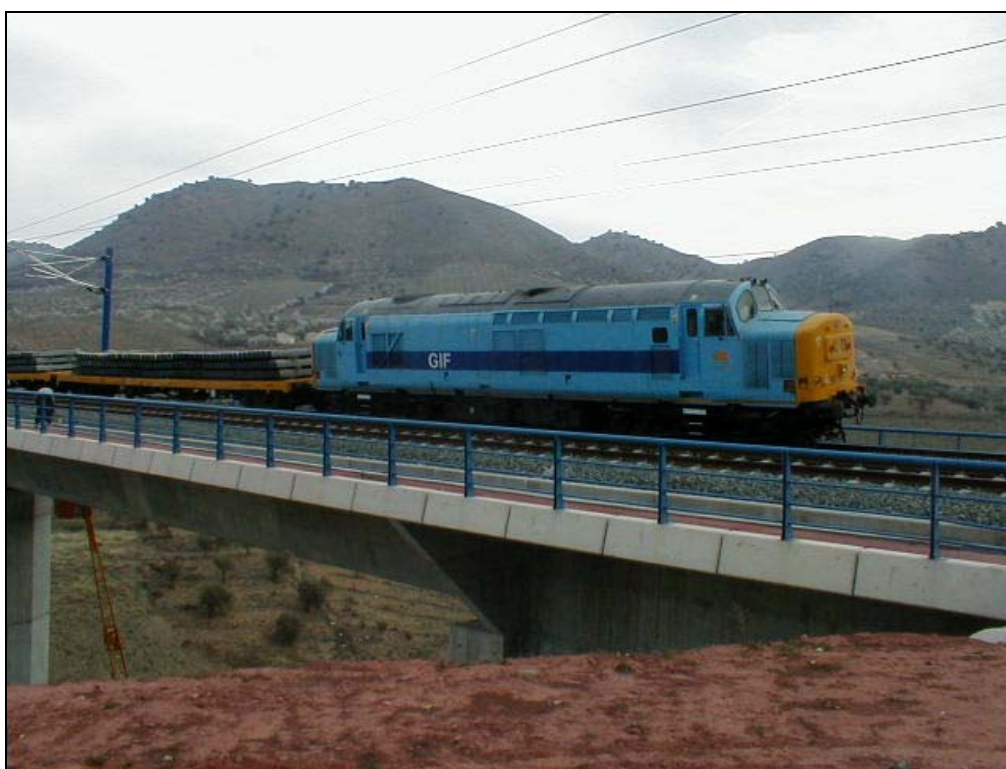
Foto 4: Vista de la entrada del viaducto durante la realización de la prueba estática del vano 1.
