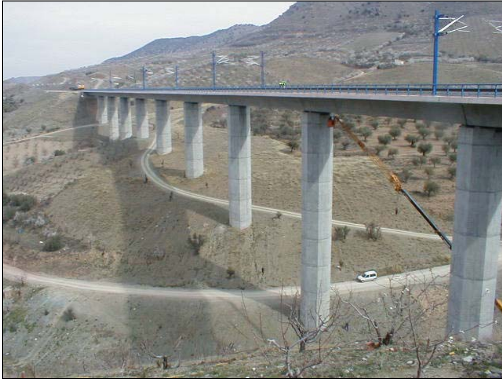
Foto1: Alzado izquierdo del viaducto durante la instrumentación de uno de los vanos.
