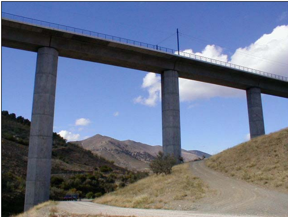
Foto 2: Alzado derecho del viaducto en sus vanos centrales.
