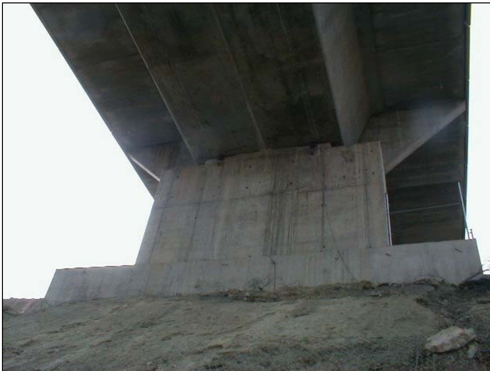
Foto 6: Vista frontal del estribo de salida (Zaragoza).
