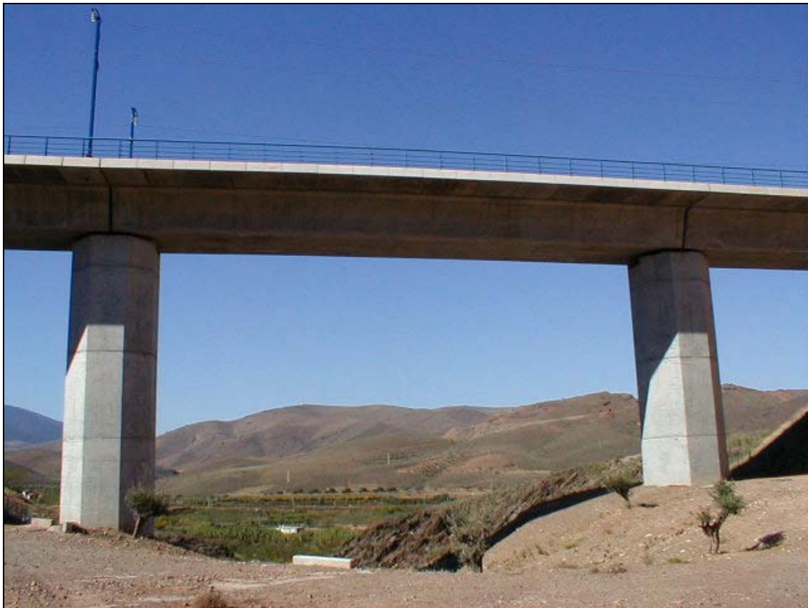
Foto 2: Alzado derecho del vano central del viaducto.
