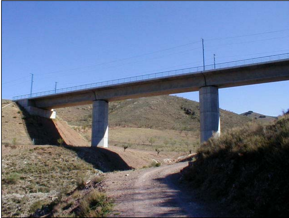
Foto1: Alzado izquierdo del viaducto.
