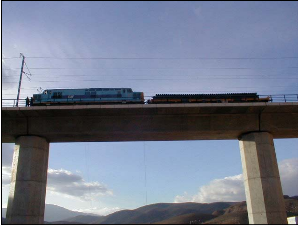
Foto 5: Vista inferior del viaducto durante la realización de la prueba estatica del vano central.
