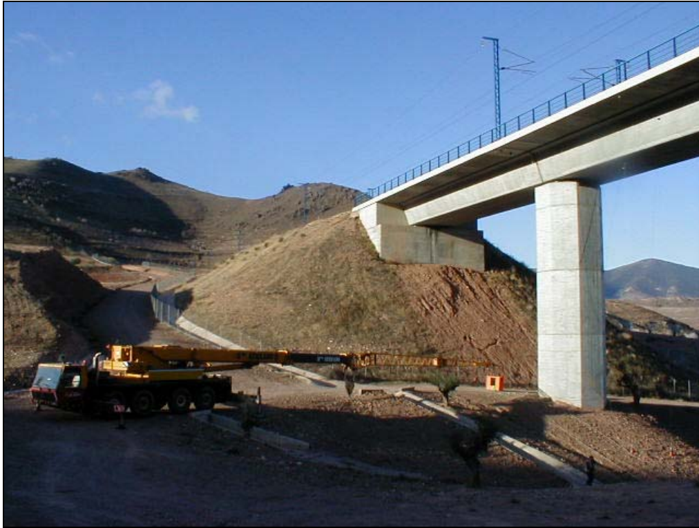
Foto 3: Vista del estribo de entrada (Madrid) momentos antes de la Instrumentación.
