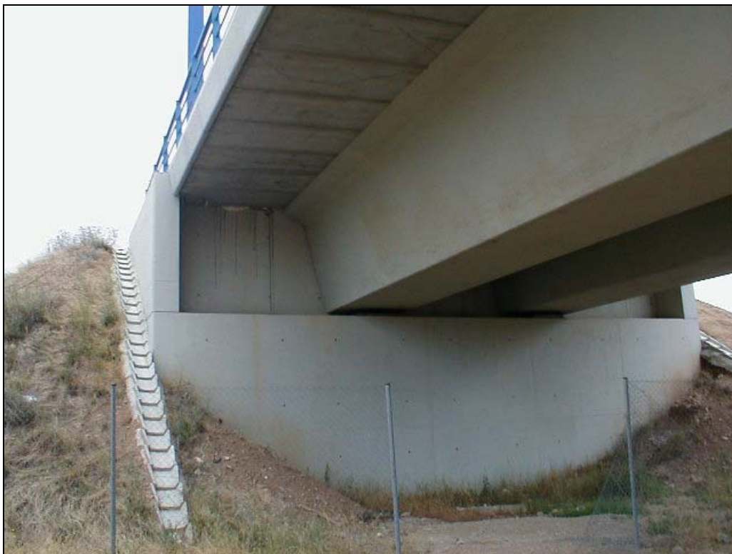
Foto 5: Estribo de entrada (Madrid)
