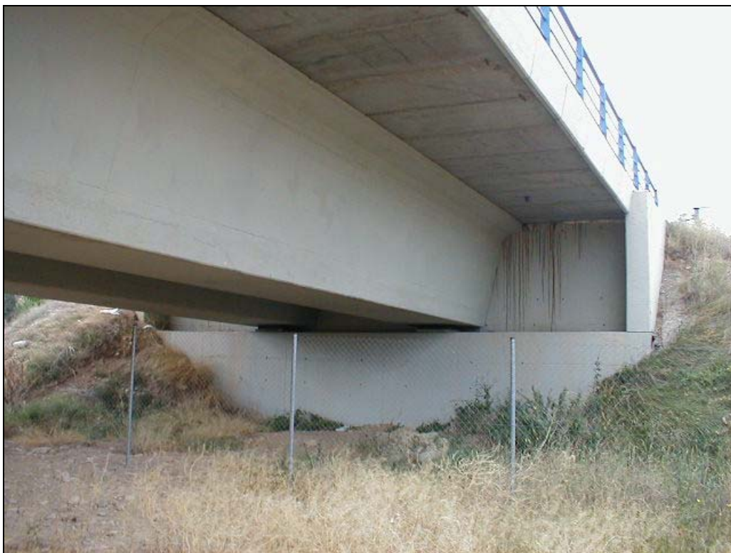
Foto 6: Estribo de salida (Zaragoza)
