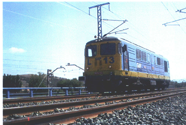
Fotografía N° 9: Prueba dinámica lenta sobre el tablero 2.
