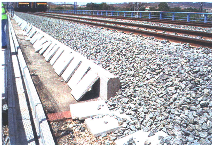
Fotografía N° 15: Vista superior del tablero desde el estribo 2.
