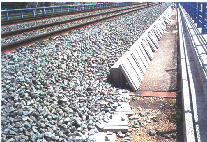
Fotografía N° 14: Vista superior del tablero desde el estribo 1.
