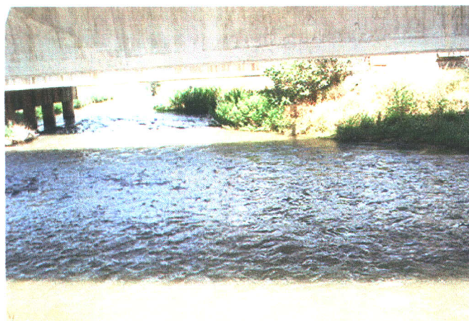
Fotografía N° 16: Vista lateral del viaducto.
