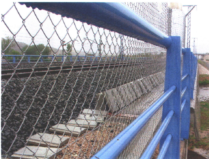
Fotografía N° 6: Vista superior desde entrada.
