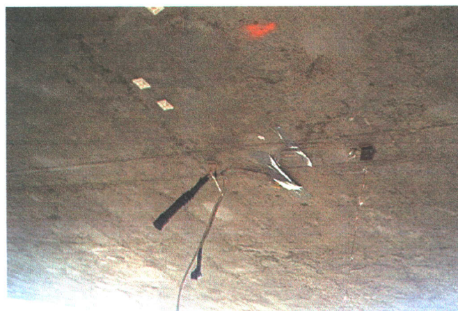
Fotografía N° 17: Vista de una banda extensométrica utilizada durante la prueba.
