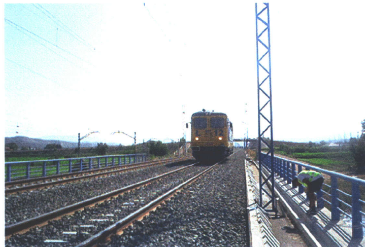
Fotografía N° 8: Prueba dinámica lenta sobre el tablero 1.
