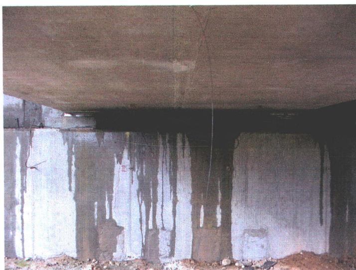
Fotografía N° 9: Vista de apoyos en el estribo 2.
