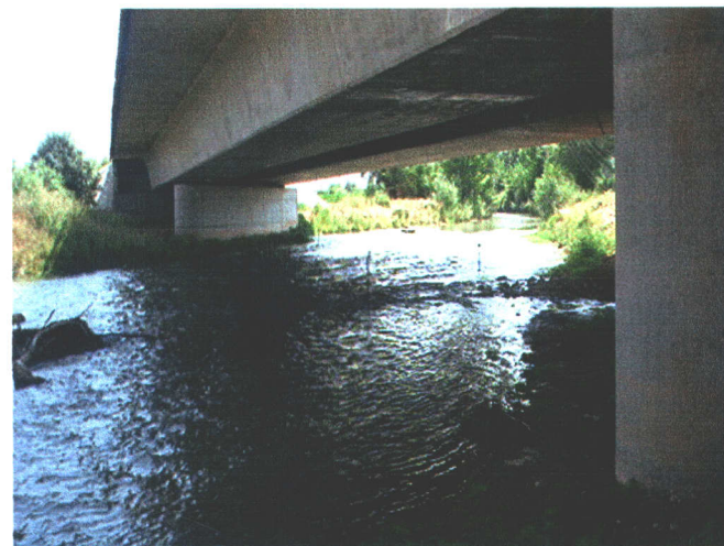
Fotografía N° 18: Vista instrumentación del vano 2.
