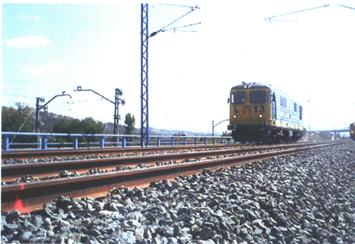
Fotografía N° 11: Prueba dinámica a máxima velocidad sobre el tablero 2.
