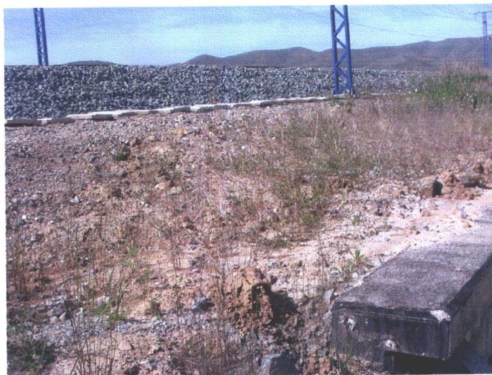
Fotografía N° 3: Vista superior desde entrada.
