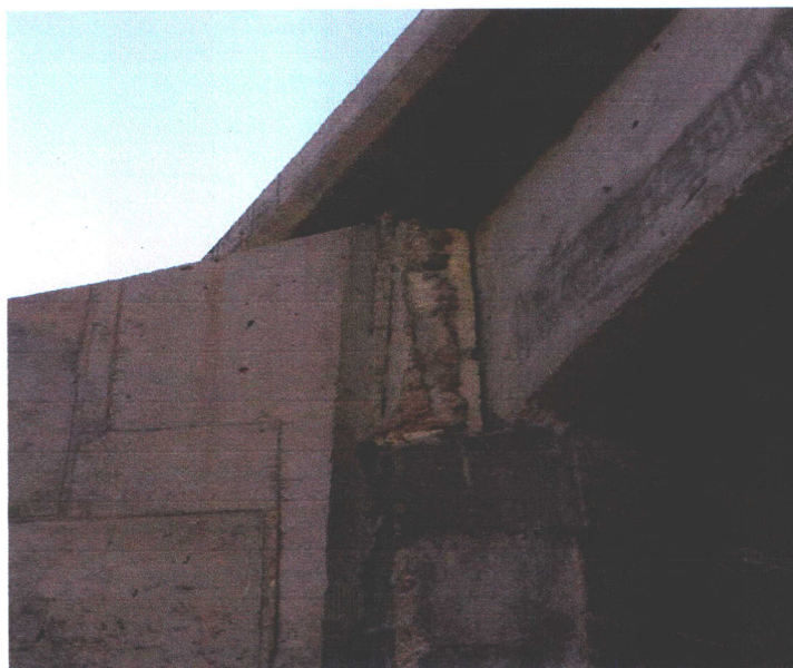
Fotografía N° 12 Detalle de la unión del estribo 2 con la aleta izquierda.
