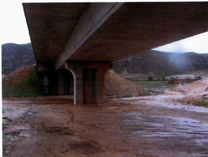
Fotografía N° 5: Vista inferior del tablero
