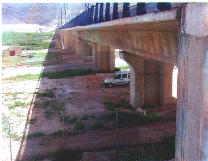
Fotografía N° 2: Vista general de la estructura, alzado izquierdo.
