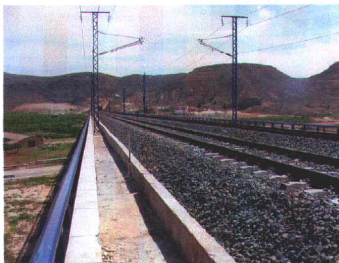
Fotografía N° 3: Vista superior del tablero, en- trada.
