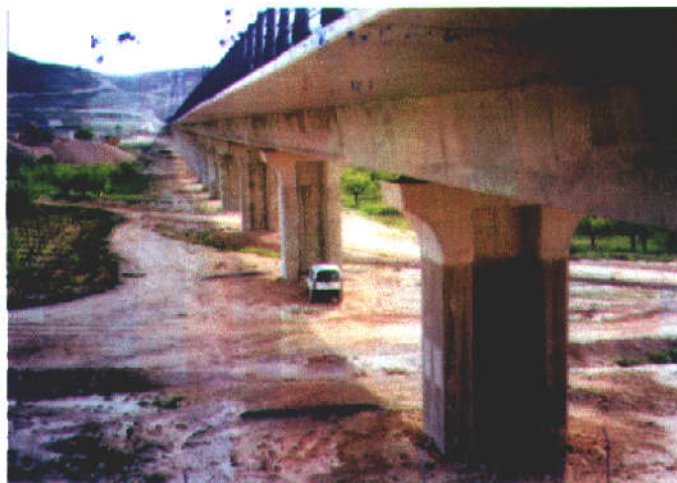
Fotografía N° 1: Vista general de la estructura, alzado derecho.
