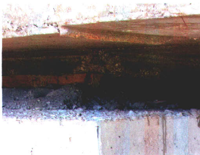
Fotografía N° 10: Fragmento de madera adosado al apoyo del estribo 1.
