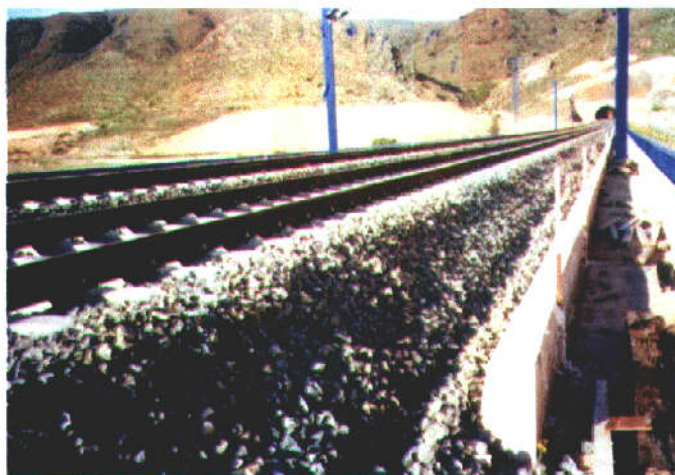
Fotografía N° 4: Vista superior del tablero, salida.
