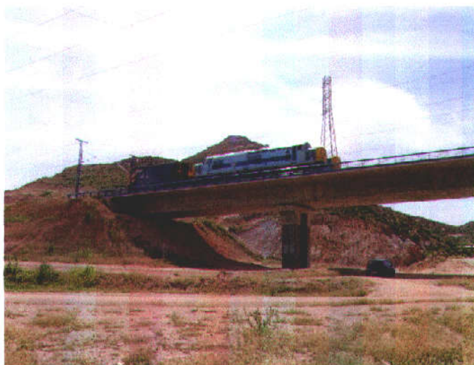
Fotografía N° 10: Ensayo estático en vano 31.
