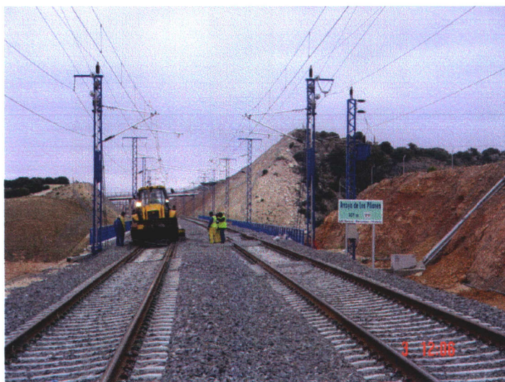
Fotografía N° 3: Vista superior desde entrada.
