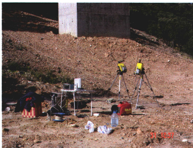
Fotografía N° 16: Detalle del equipo laser utilizado para la realización de las pruebas en vanos 1, 2 y 3.
