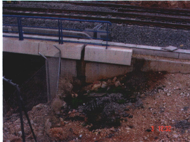
Fotografía N° 5: Detalle estribo entrada.
