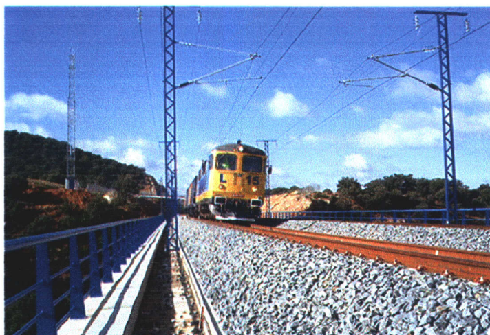
Fotografía N° 8: Ensayo dinámico a 30 Km/h sobre los vanos 1, 2 y 3.
