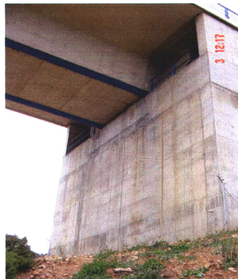
Fotografía N° 6: Detalle estribo salida.
