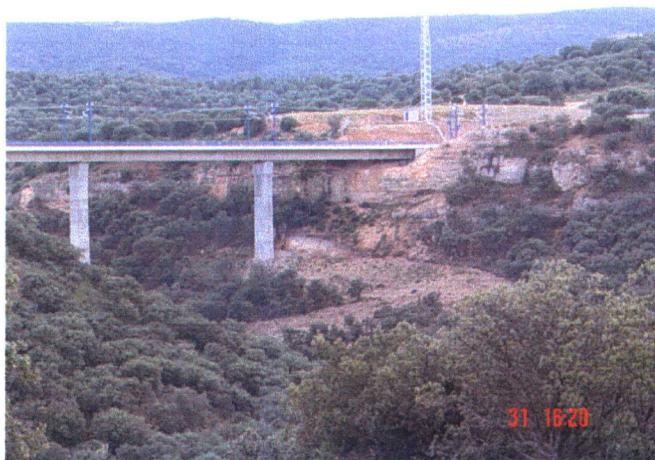
Fotografía N° 18: Vista general de la dificultad de acceso y de instrumentación del viaducto.
