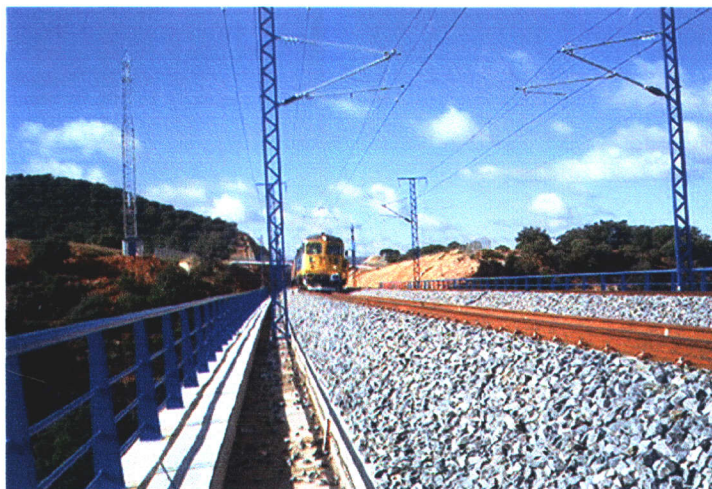
Fotografía N° 7: Ensayo cuasiestático sobre los vanos 1, 2 y 3.
