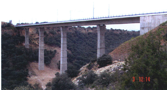
Fotografía N° 1: Vista general de la estructura. Lado Derecho.
