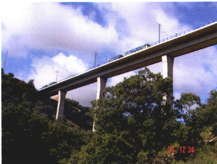
Fotografía N° 1: Ensayo estático 1. Vehículos en Vano 1 y Vano 3.
