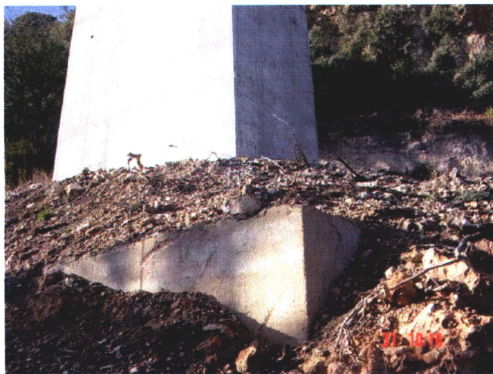
Fotografía N° 10: Zapata pila 1 descubierta.
