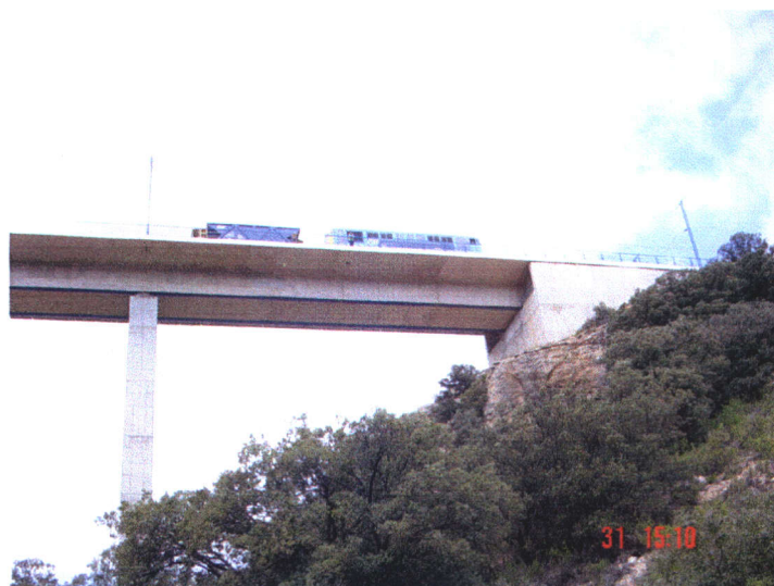
Fotografía N° 6: Ensayo estático 6. Vehículos en Vano 5.
