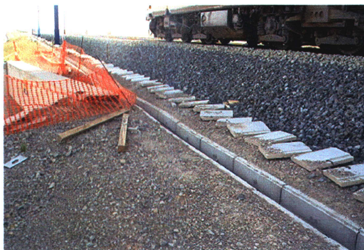
Fotografía N° 10: Detalle de la vía durante la prueba estática.
