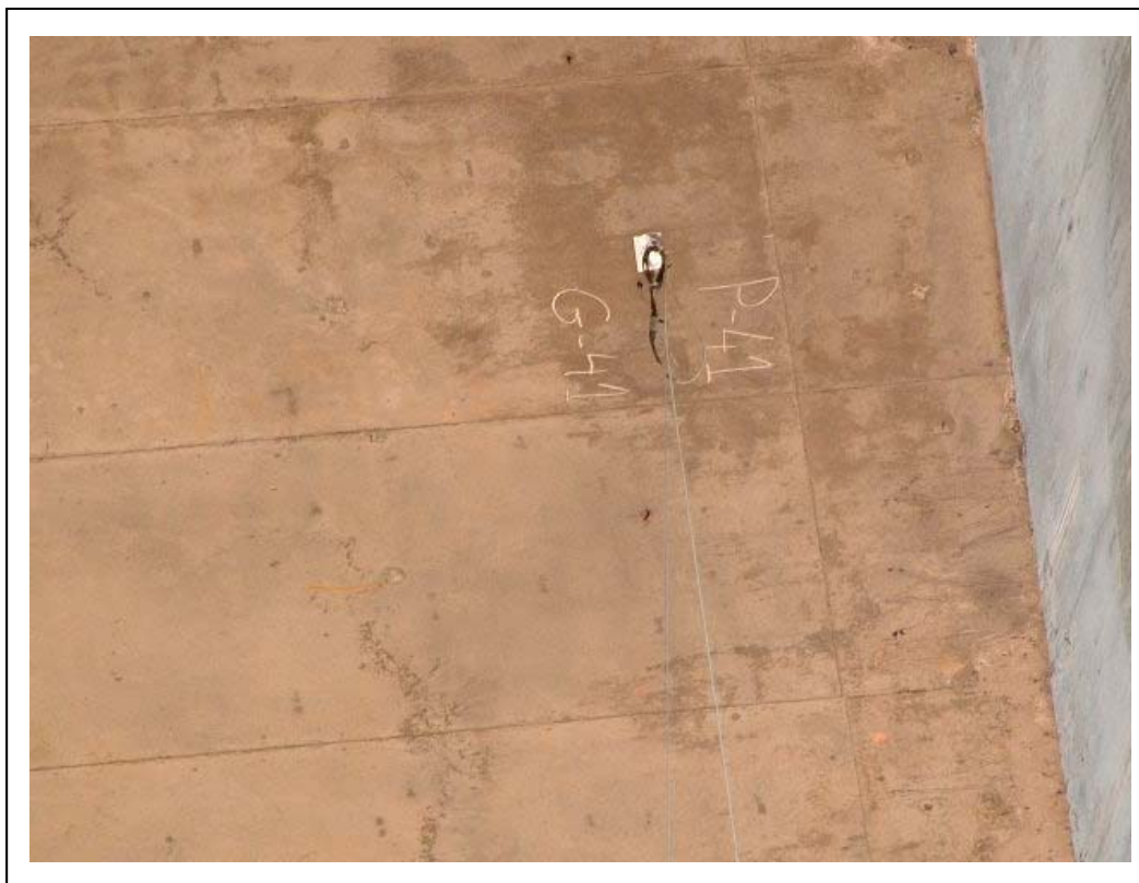
FOTOGRAFÍA 7: Galga extensométrica y transductor de desplazamiento en el centro del vano 4 bajo la vía derecha
