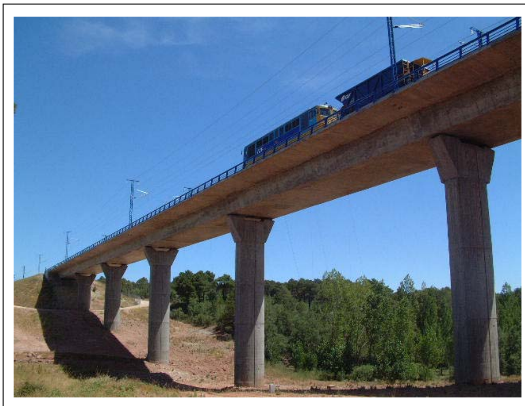
FOTOGRAFÍA 11: Locomotora serie 060 y tolva posicionadas en vano 4 para prueba estática 2
