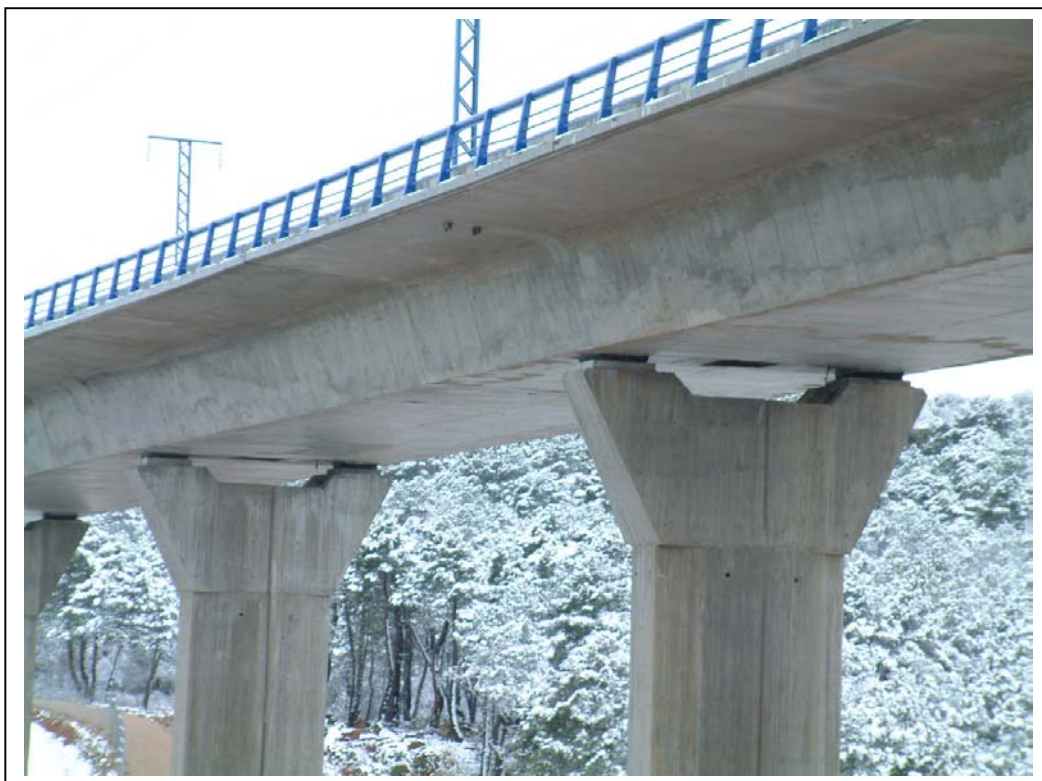
FOTOGRAFÍA Nº 4: CORONACIÓN DE PILAS EN TRAMO 5
