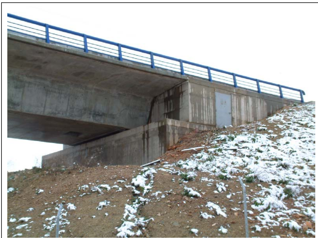
FOTOGRAFÍA Nº 5: VISTA LATERAL DERECHA DEL ESTRIBO ZARAGOZA
