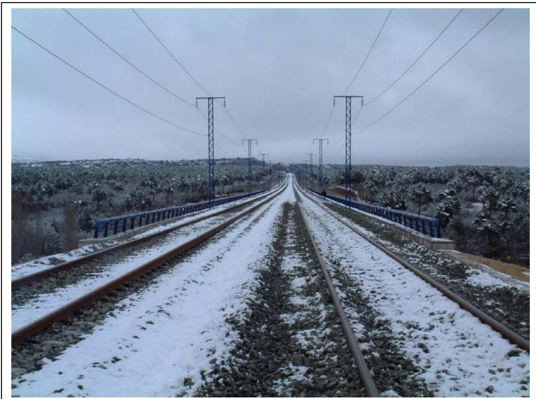
FOTOGRAFÍA Nº 8: VISTA SUPERIOR DESDE EL ESTRIBO MADRID
