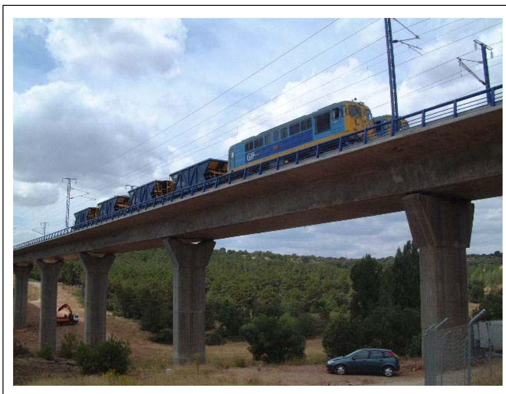
FOTOGRAFÍA 14: Trenes de carga posicionados para la prueba estática 6 cargando los vanos 6 y 7
