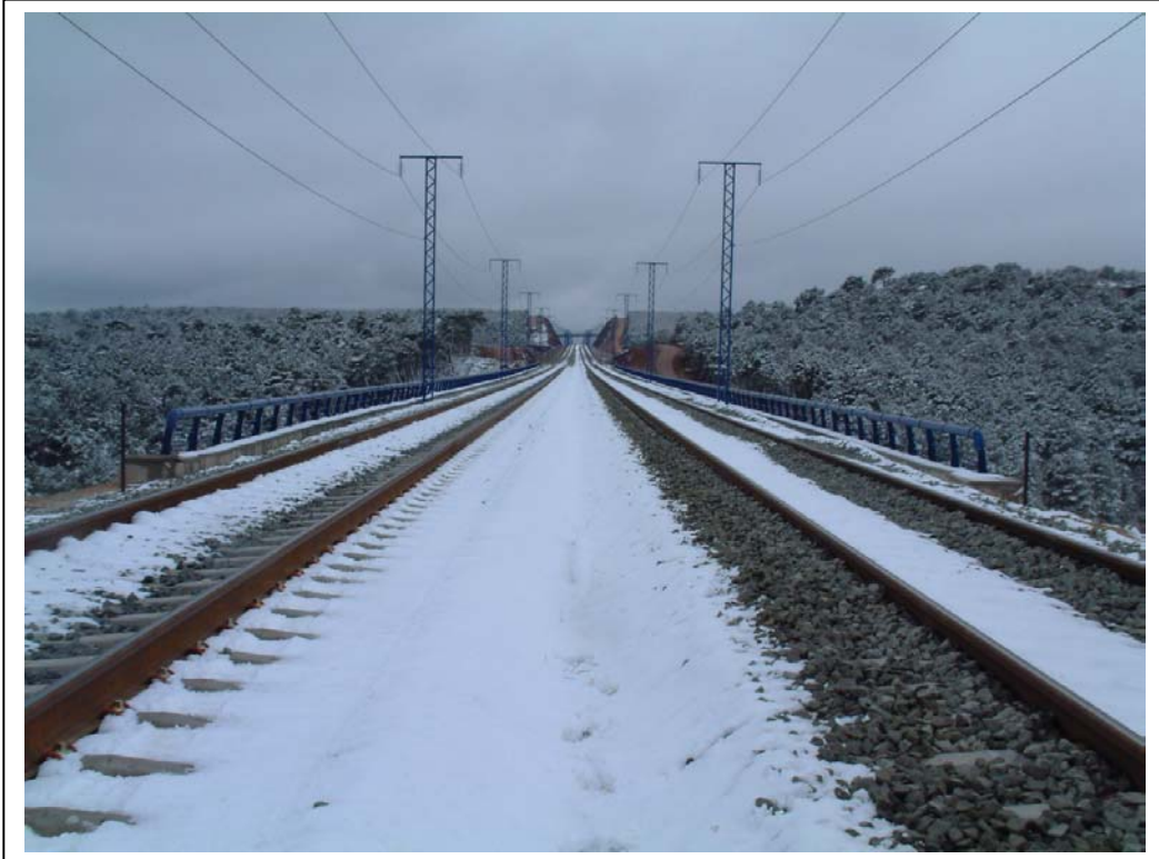
FOTOGRAFÍA Nº 8: VISTA SUPERIOR DESDE EL ESTRIBO ZARAGOZA
