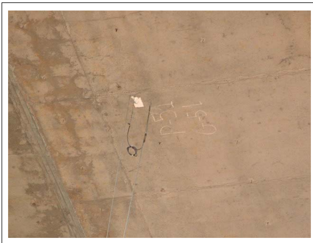
FOTOGRAFÍA 8: Galga extensométrica y transductor de desplazamiento en el centro del vano 5 bajo la vía derecha
