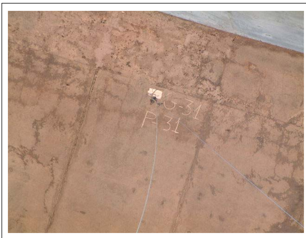
FOTOGRAFÍA 6: Galga extensométrica y transductor de desplazamiento en el centro del vano 3 bajo la vía derecha
