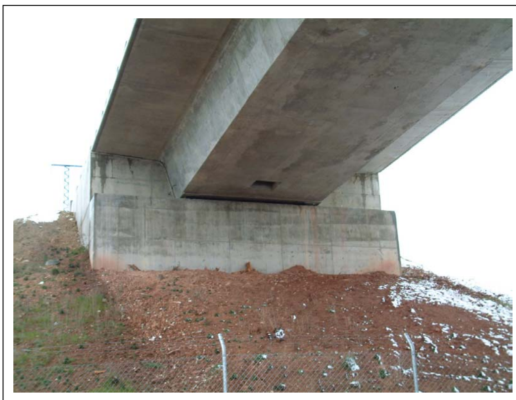
FOTOGRAFÍA 2: Vista inferior hacia estribo Madrid
