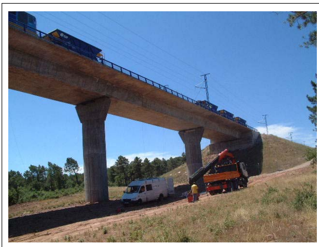
FOTOGRAFÍA 10: Trenes de carga posicionados para la prueba estática 1 cargando los vanos 1 y 3
