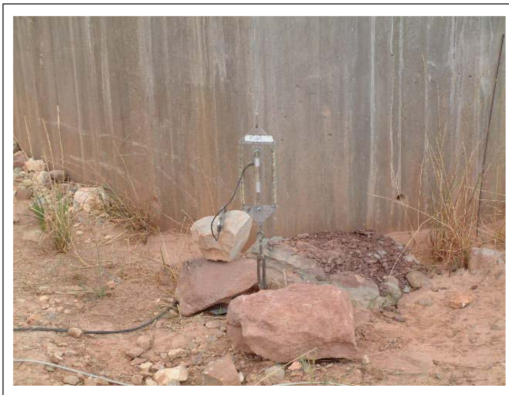
FOTOGRAFÍA 9: Transductor de desplazamiento fijado al suelo
