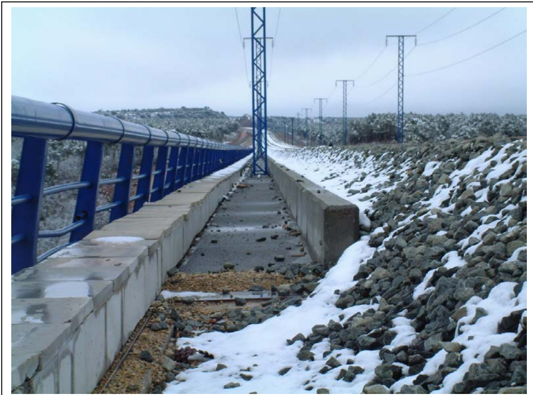
FOTOGRAFÍA Nº 9: PASILLO LATERAL IZQUIERDO CON MURO GUARDABALASTO
