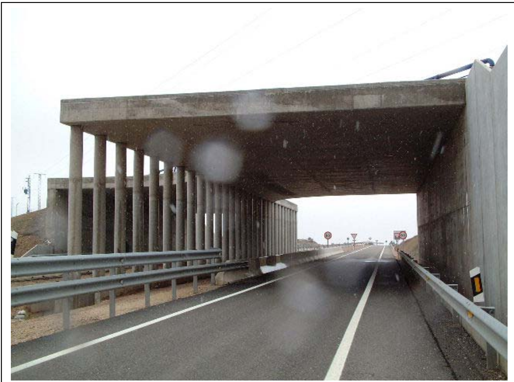
FOTOGRAFÍA Nº 2: VISTA LATERAL DERECHA DEL TRAMO 2
