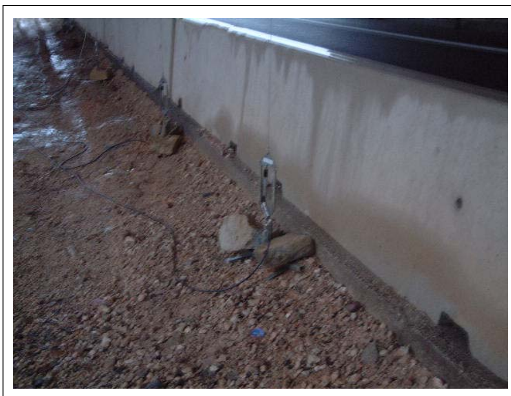
FOTOGRAFÍA 6: Detalle de transductor de desplazamiento anclado al suelo
