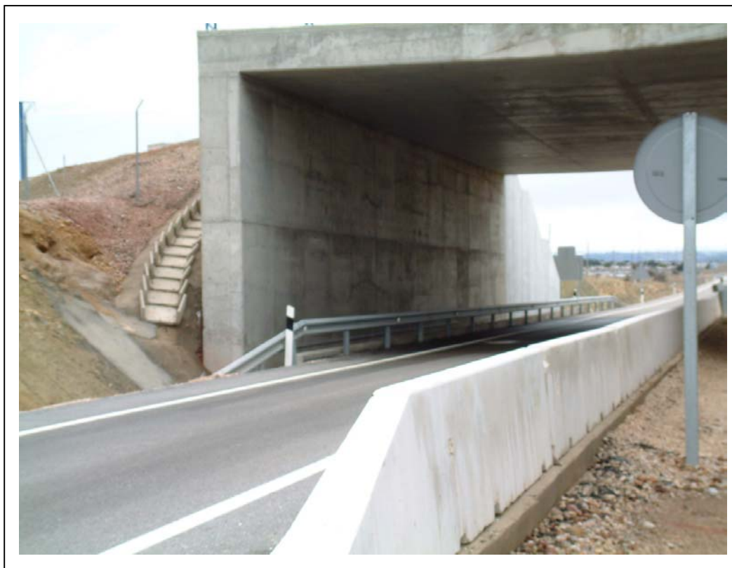
FOTOGRAFÍA 3: Vista lateral izquierda del estribo Zaragoza
