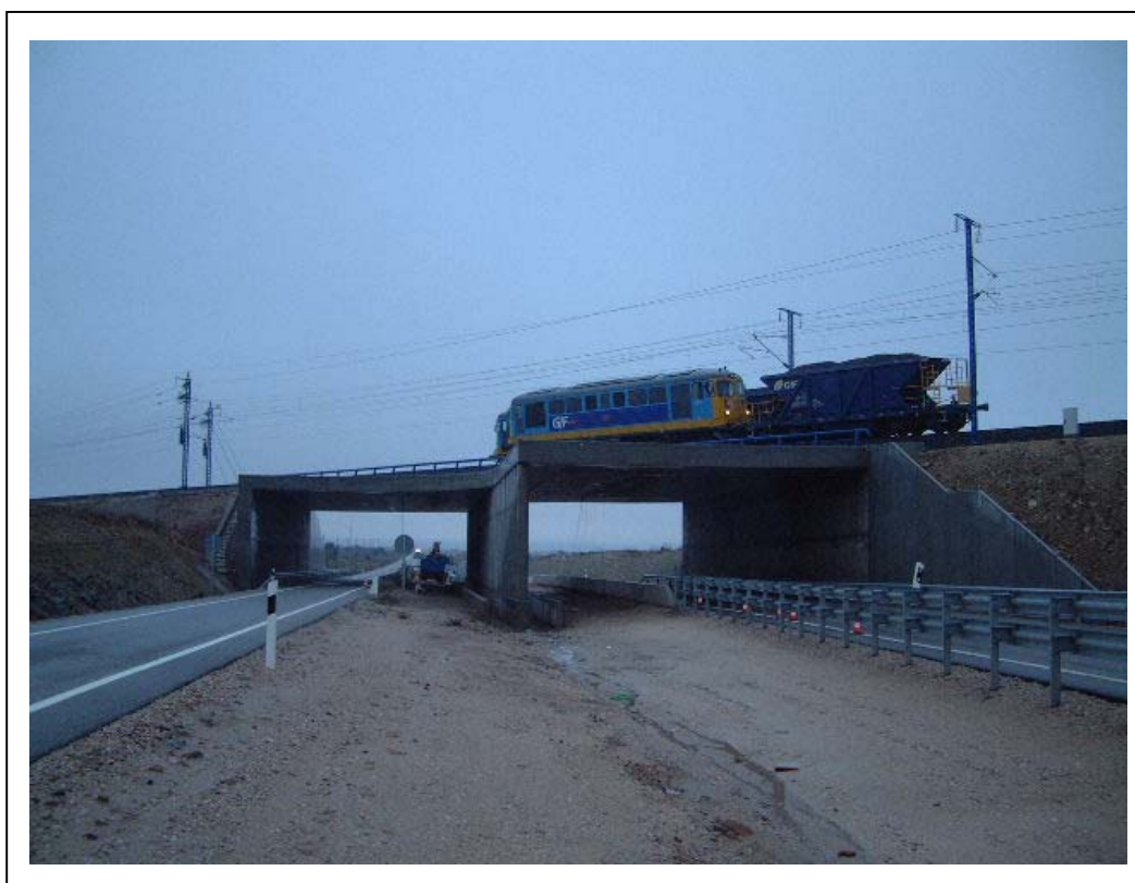
FOTOGRAFÍA 8: Trenes de carga posicionados para prueba de carga estática 01
