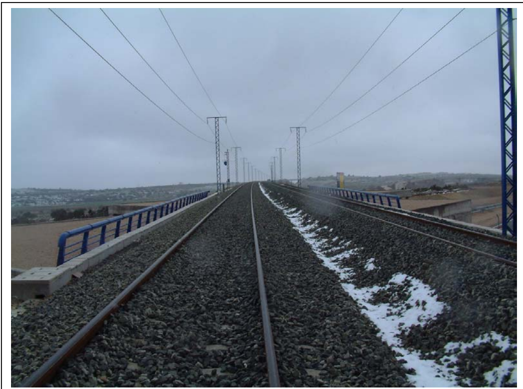
FOTOGRAFÍA Nº 6: VISTA SUPERIOR DESDE ESTRIBO ZARAGOZA
