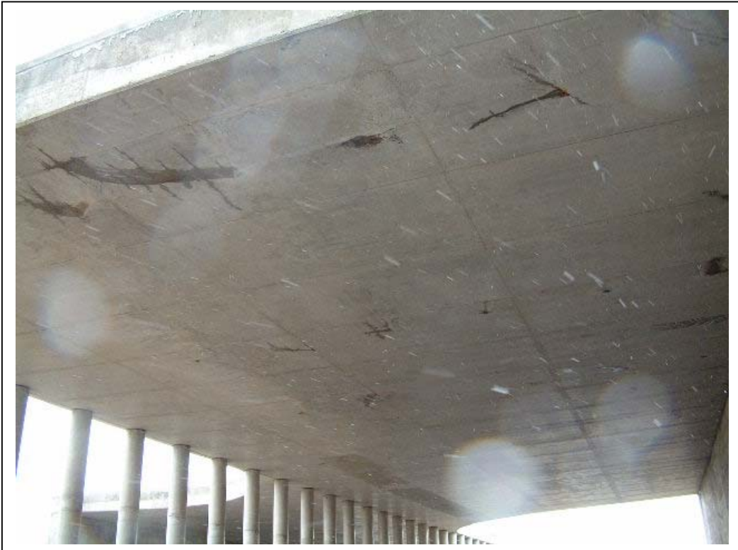
FOTOGRAFÍA Nº 5: VISTA INFERIOR DEL TRAMO 2
