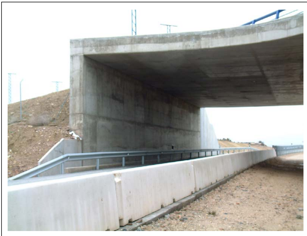
FOTOGRAFÍA 2: Vista lateral derecha del estribo Madrid
