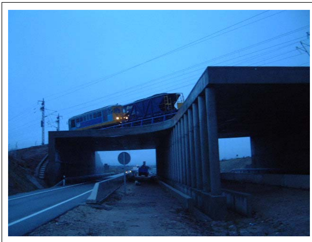
FOTOGRAFÍA 9: Tren de cargas posicionado para prueba de carga estática 02
