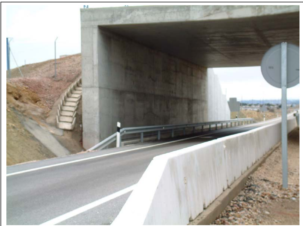
FOTOGRAFÍA N° 4: VISTA LATERAL IZQUIERDA DEL ESTRIBO ZARAGOZA
