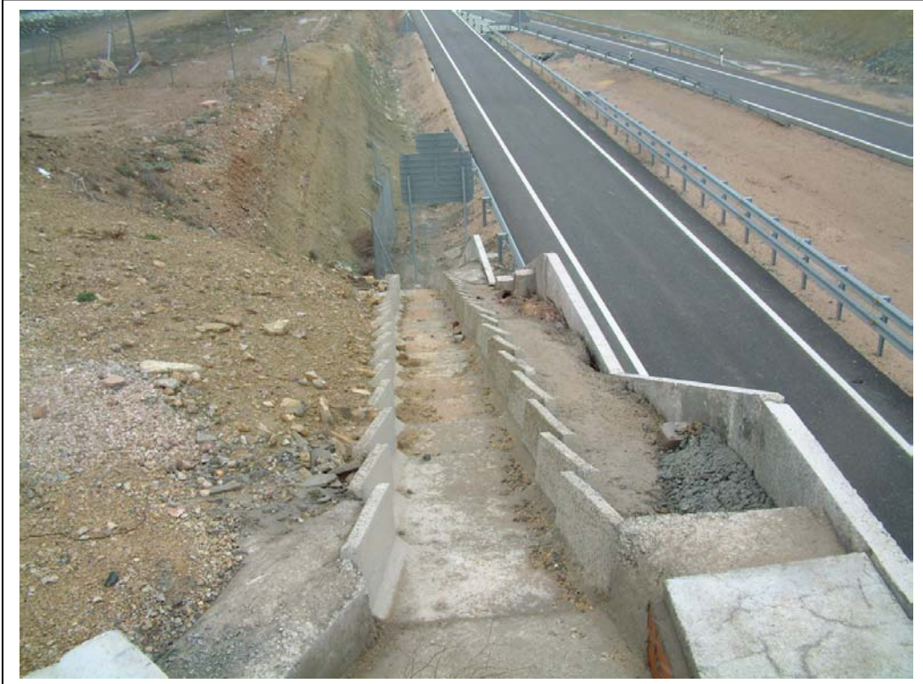
FOTOGRAFÍA Nº 9: OBRAS DE DRENAJE TRANSVERSAL EN ESTRIBO ZARAGOZA
