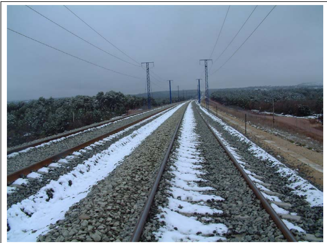
FOTOGRAFÍA Nº 8: VISTA SUPERIOR DESDE EL ESTRIBO ZARAGOZA
