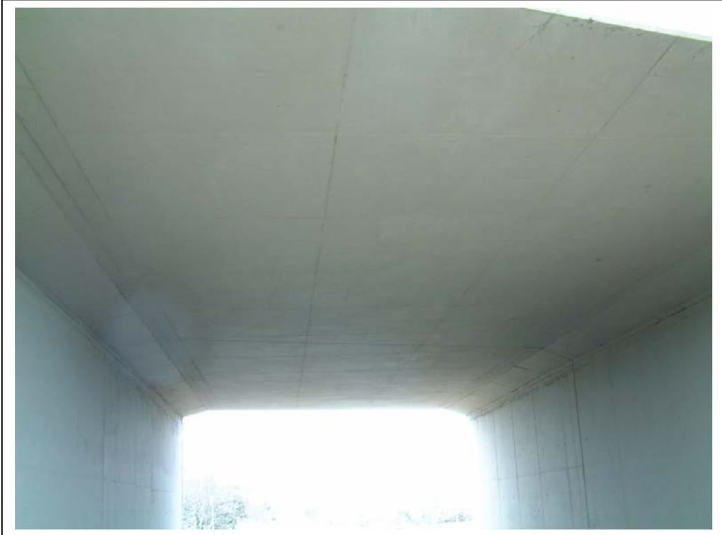
FOTOGRAFÍA N° 5: VISTA INFERIOR DE TABLERO
