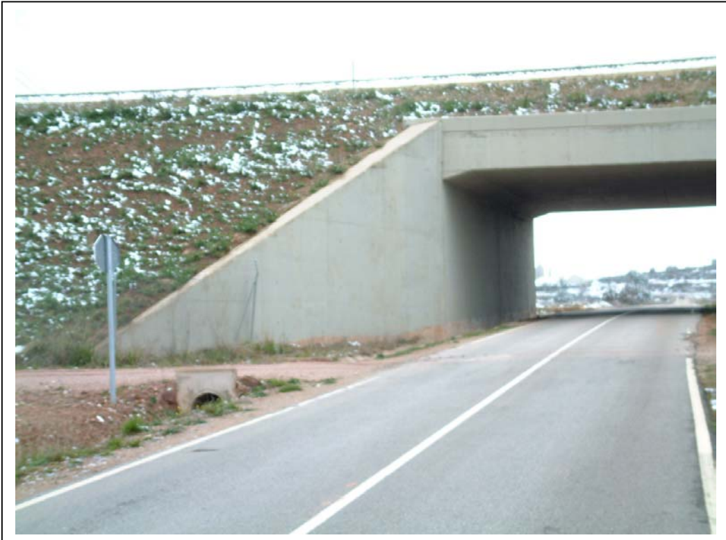
FOTOGRAFÍA Nº 3: VISTA DE ALETA DERECHA DEL ESTRIBO MADRID
