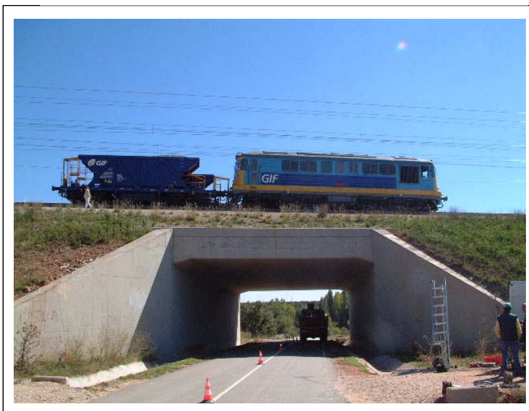
FOTOGRAFÍA 10: Tren tipo circulando durante uno de los ensayos dinámicos
