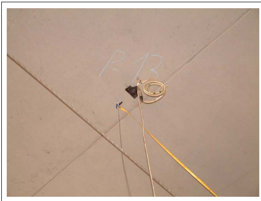
FOTOGRAFÍA 7: Transductor de desplazamiento para la medida de la flecha en el centro del tablero
