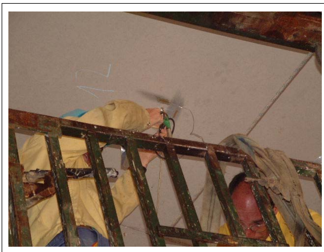
FOTOGRAFÍA 6: Transductor de desplazamiento (Punto P-12) para la medida de la flecha bajo el carril exterior de la vía 1
