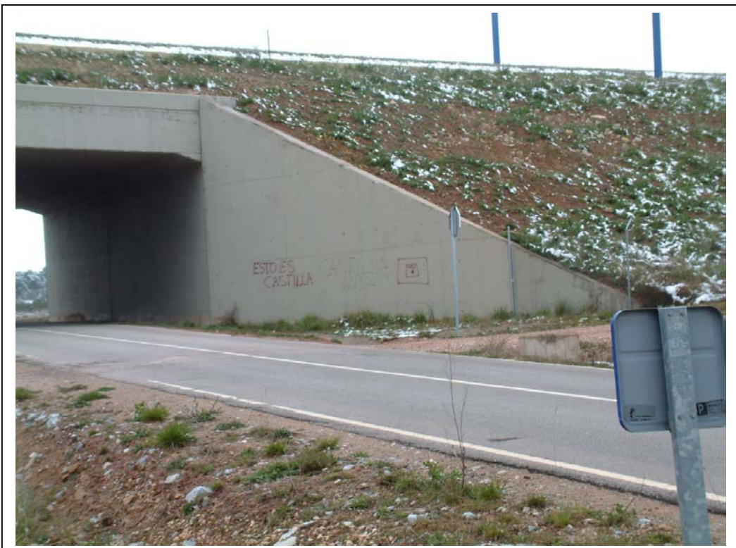
FOTOGRAFÍA Nº 4: VISTA DE ALETA DERECHA DEL ESTRIBO ZARAGOZA
