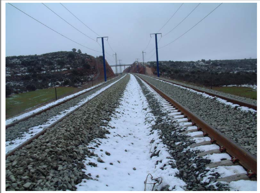
FOTOGRAFÍA Nº 7: VISTA SUPERIOR DESDE EL ESTRIBO MADRID
