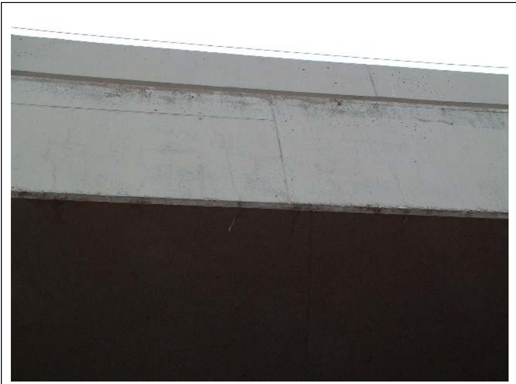
FOTOGRAFÍA N° 6: CANTO DE TABLERO
