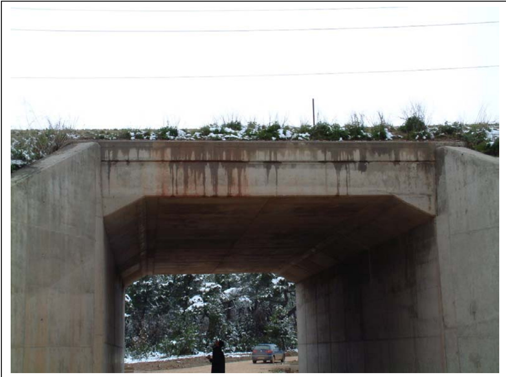
FOTOGRAFÍA Nº 5: VISTA LATERAL DERECHA DE TABLERO
