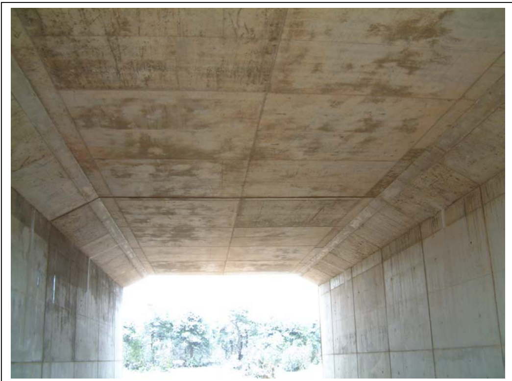
FOTOGRAFÍA Nº 6: VISTA INFERIOR DE TABLERO
