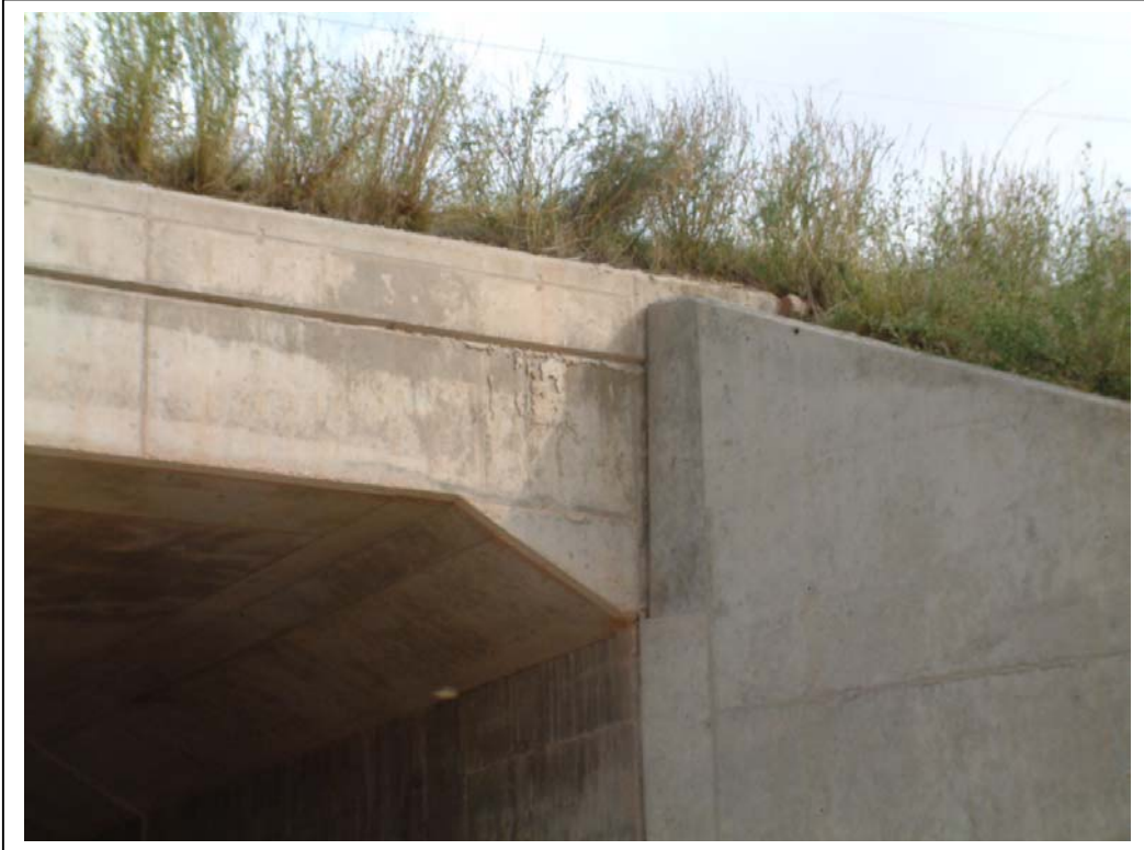
FOTOGRAFÍA N° 7: UNIÓN TABLERO-ESTRIBO ZARAGOZA (VISTA LATERAL DERECHA)
