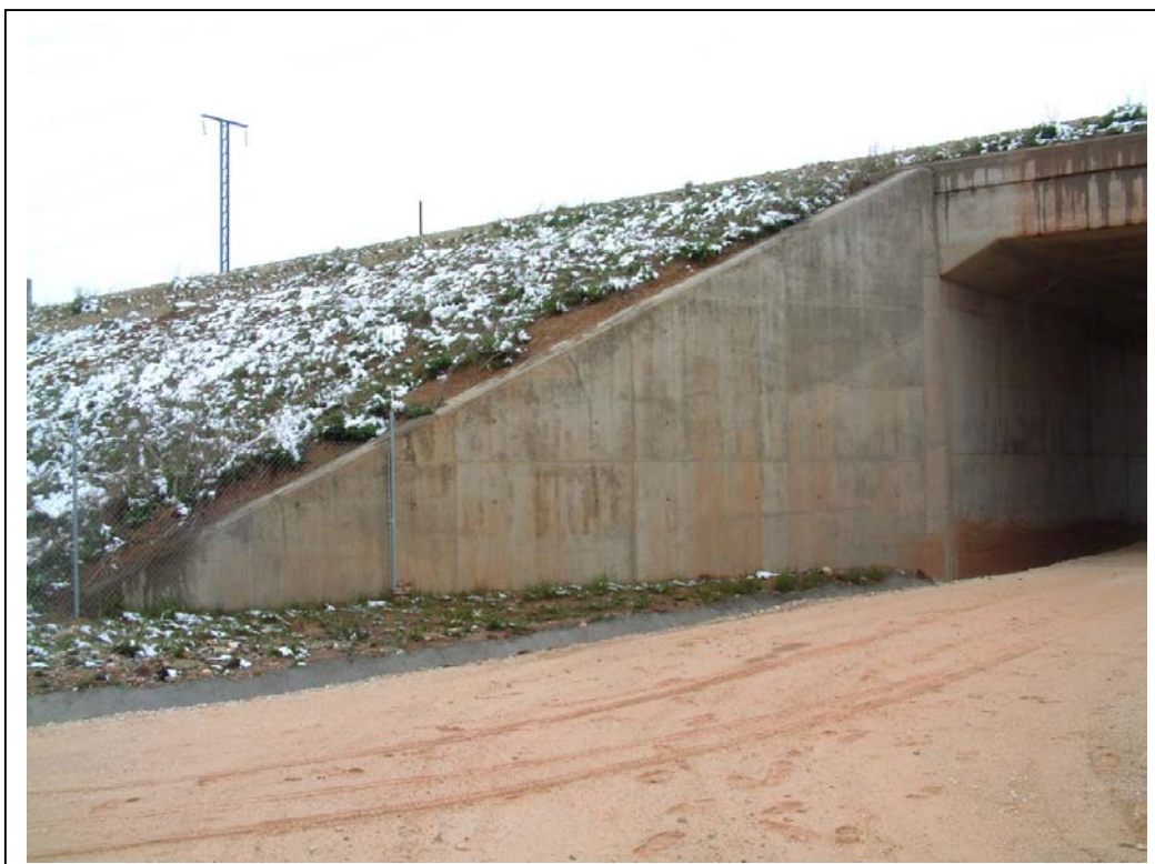
FOTOGRAFÍA Nº 4: ALETA DERECHA DEL ESTRIBO MADRID
