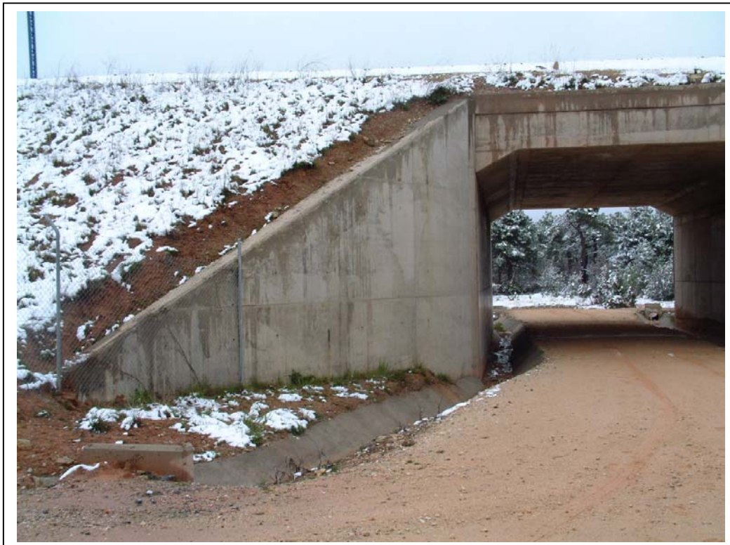
FOTOGRAFÍA Nº 3: ALETA IZQUIERDA DEL ESTRIBO ZARAGOZA
