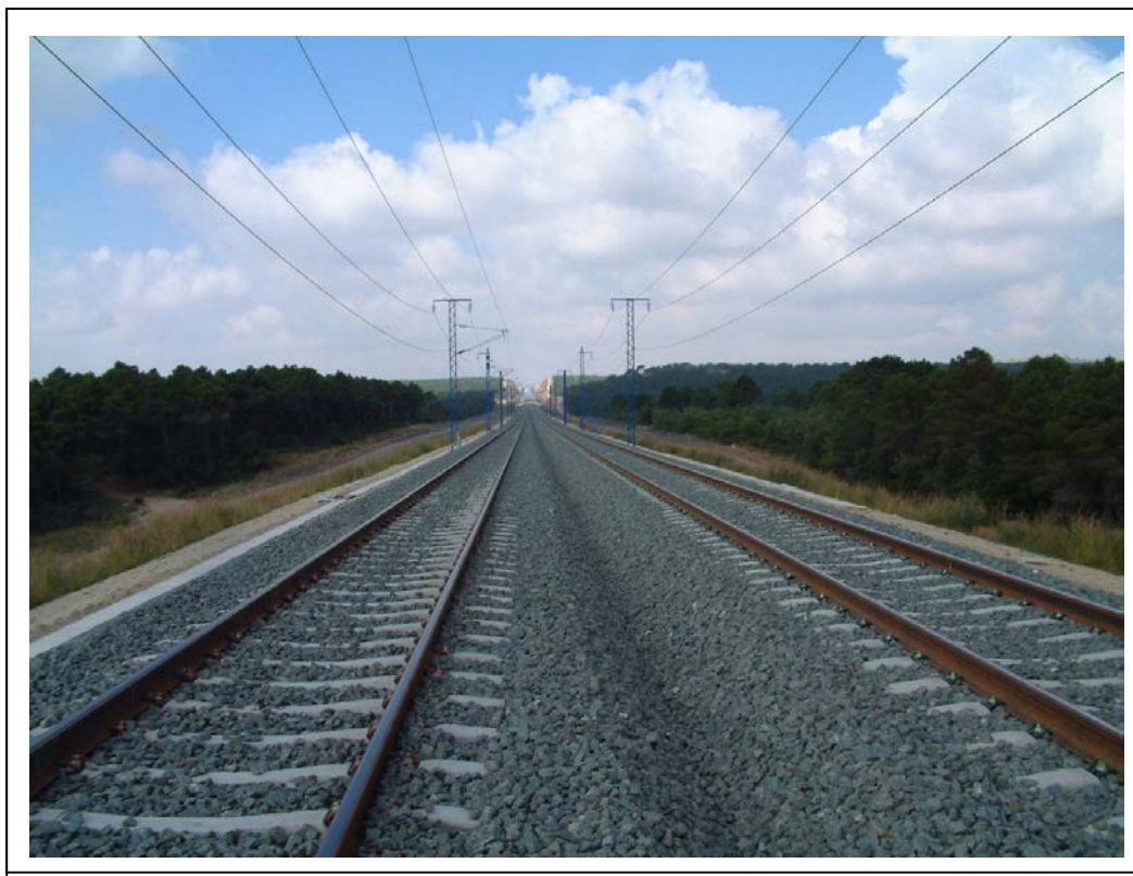
FOTOGRAFÍA 3: Vista superior desde estribo Zaragoza
