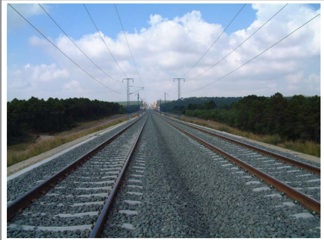
FOTOGRAFÍA Nº 9: VISTA SUPERIOR DESDE ESTRIBO ZARAGOZA
