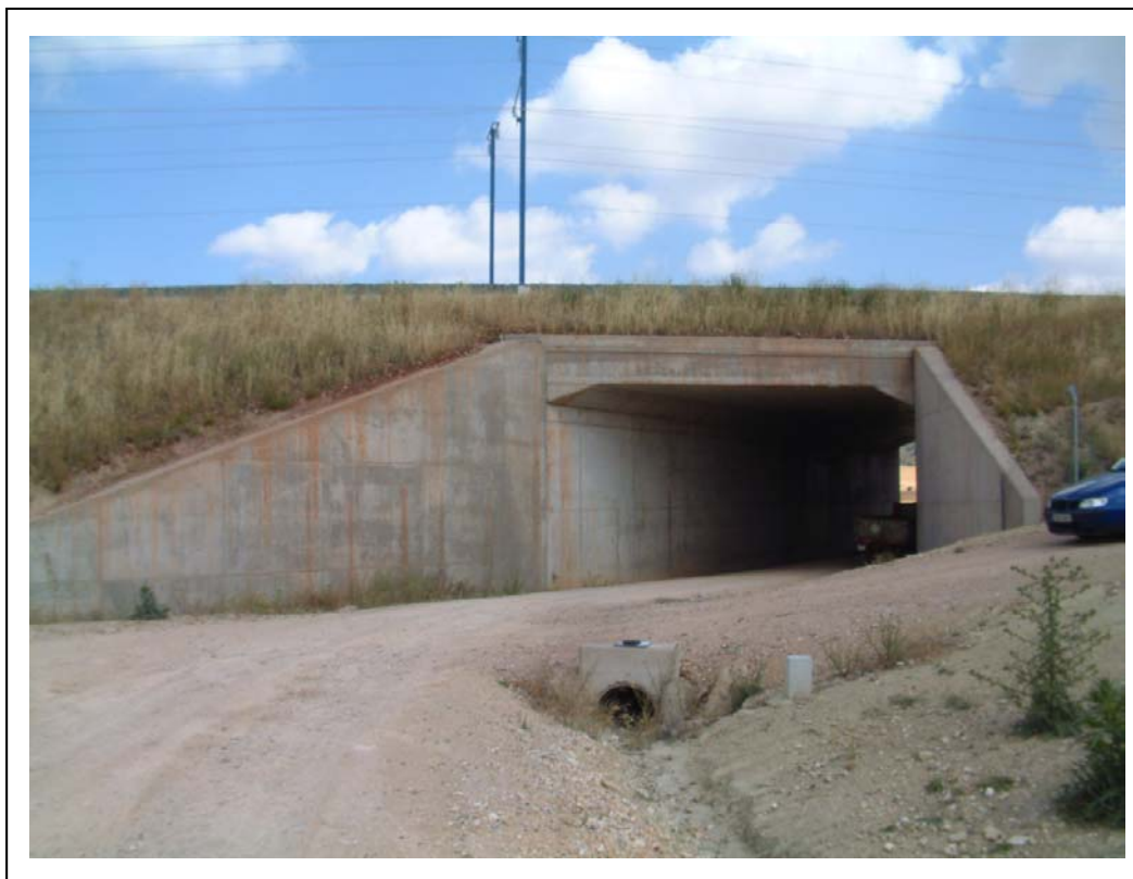
FOTOGRAFÍA 1: Vista superior desde el estribo Zaragoza
