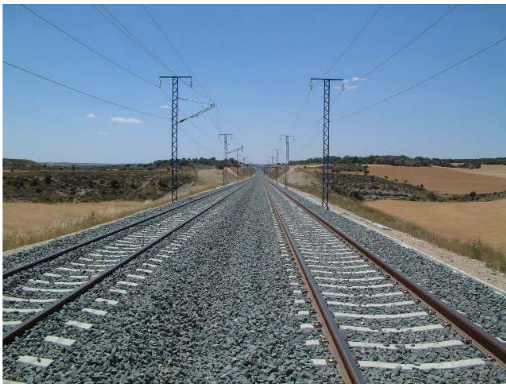
FOTOGRAFÍA 4: Vista superior del Paso Inferior
