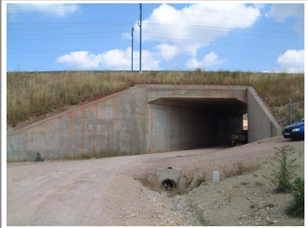
FOTOGRAFÍA N° 1: VISTA LATERAL DERECHA
