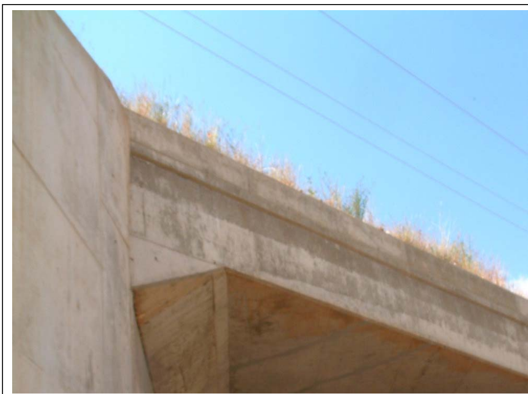
FOTOGRAFÍA Nº 4: UNIÓN TABLERO-ESTRIBO ZARAGOZA (VISTA LATERAL IZQUIERDA)
