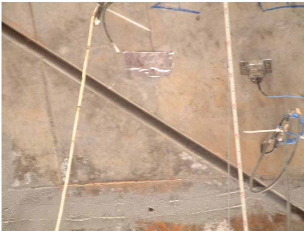
FOTOGRAFÍA 7: Banda extensométrica y acelerómetro cerca de la junta longitudinal del tablero
