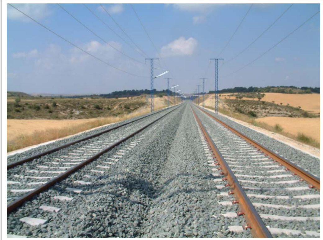
FOTOGRAFÍA N° 9: VISTA SUPERIOR DESDE EL ESTRIBO ZARAGOZA
