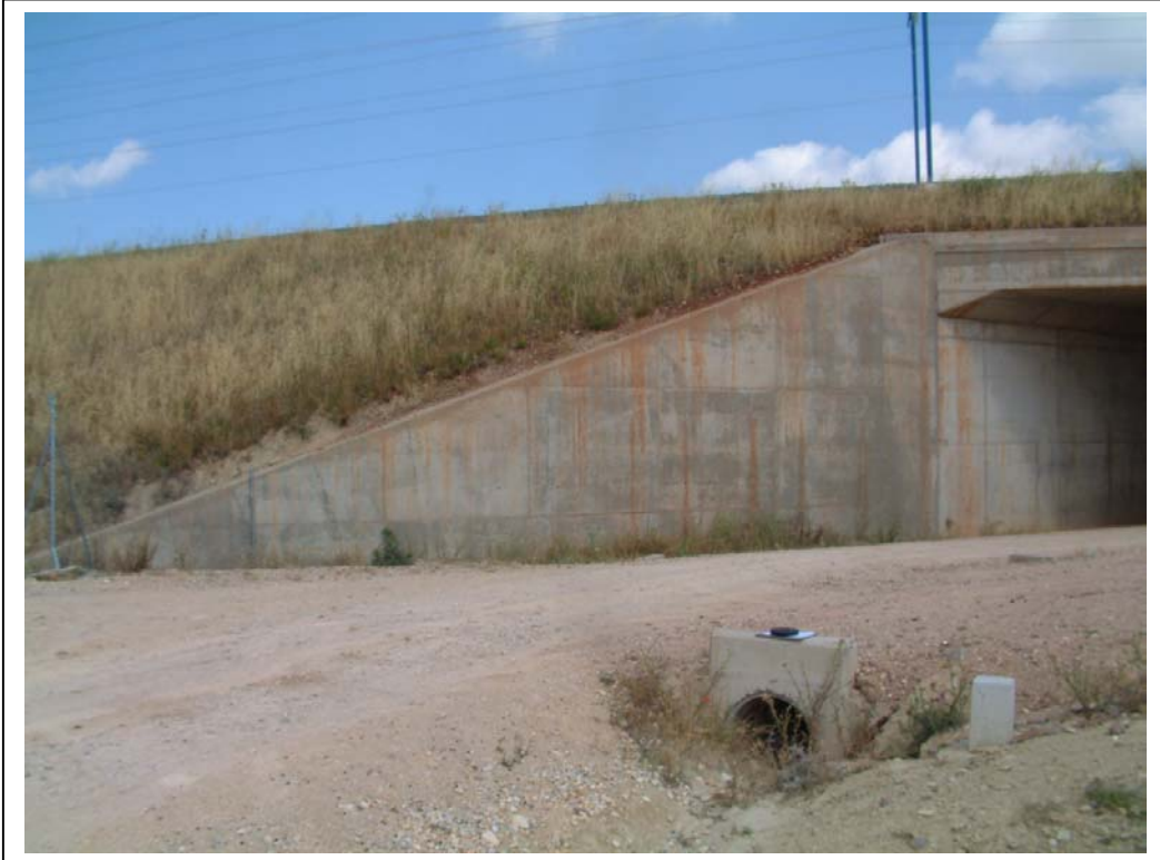
FOTOGRAFÍA Nº 5: ALETA DERECHA DEL ESTRIBO MADRID
