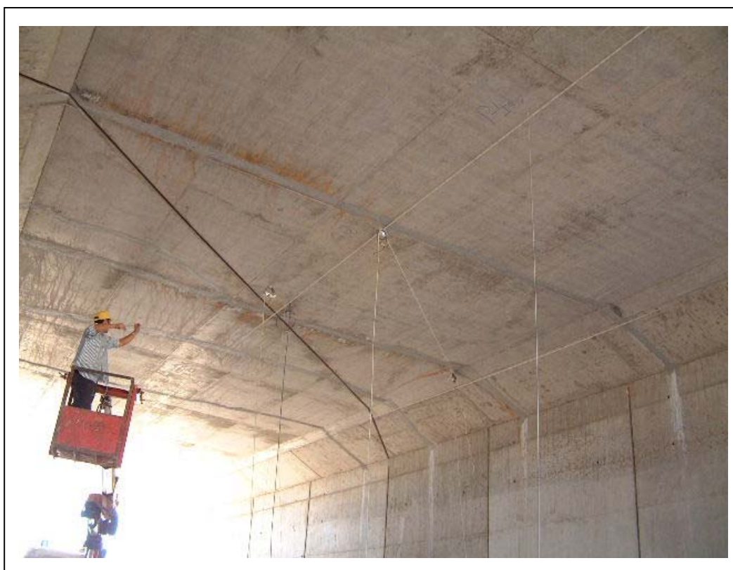
FOTOGRAFÍA 6: Cesta auxiliar para colocación de puntos de instrumentación. Vista de puntos en sección central de tablero
