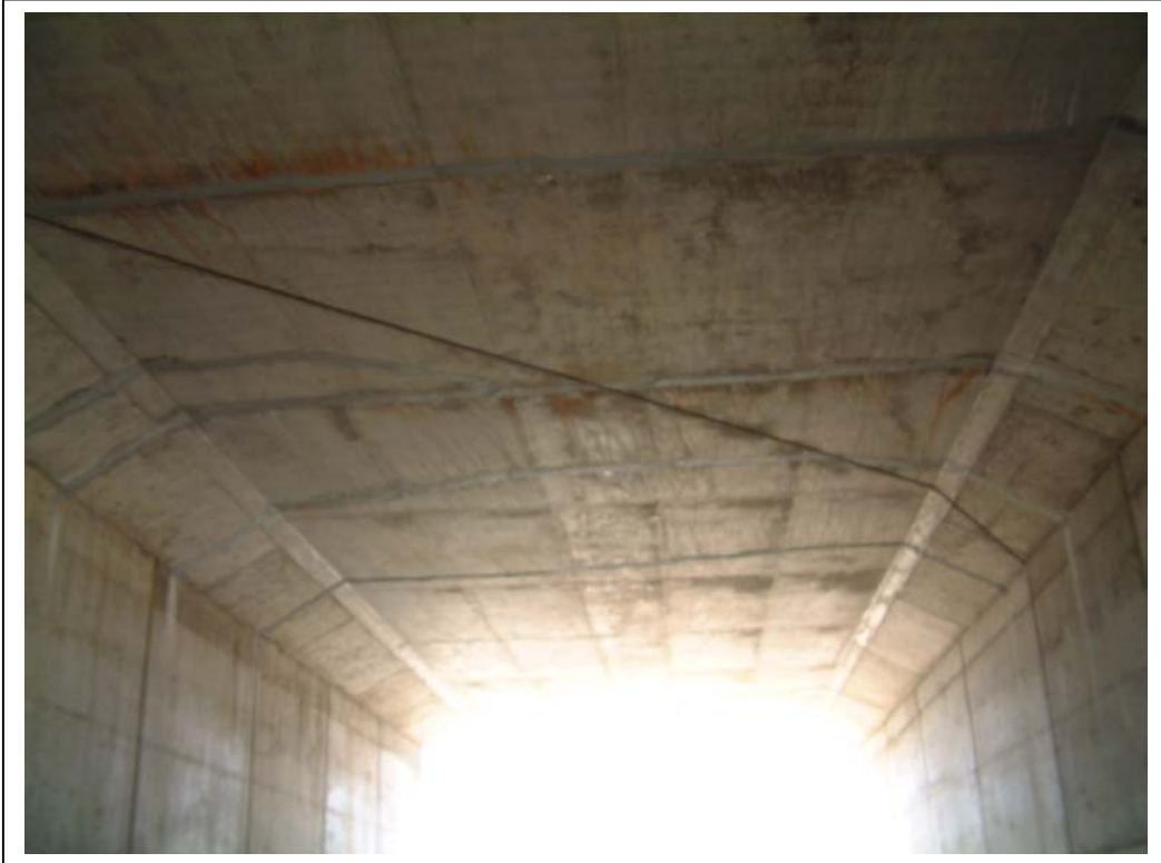
FOTOGRAFÍA Nº 7: VISTA INFERIOR DEL TABLERO. JUNTA DE DILATACIÓN DEL TABLERO
