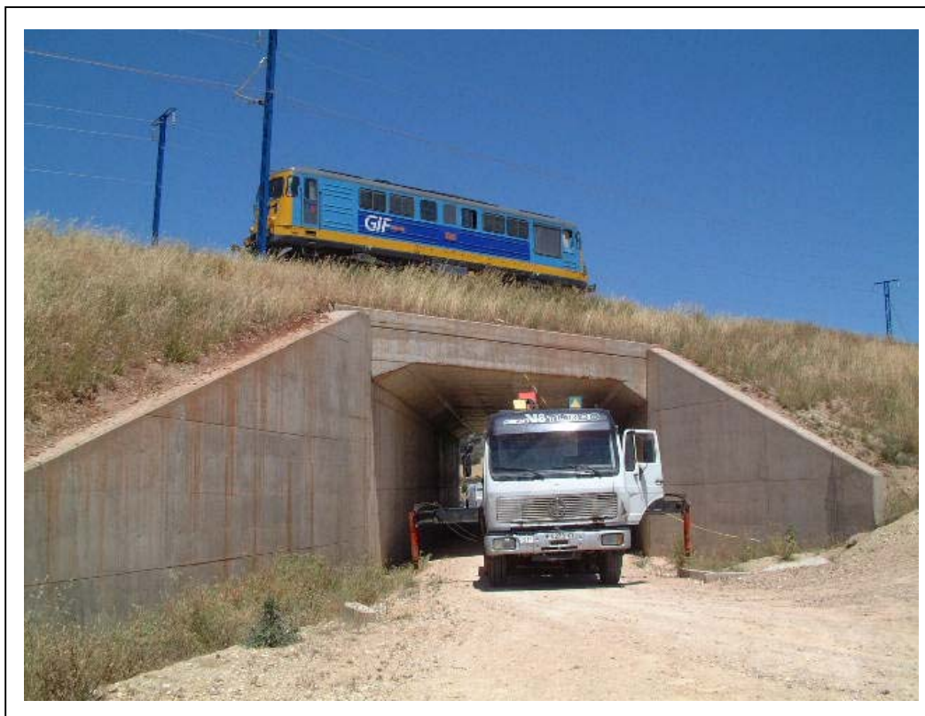
FOTOGRAFÍA 9: Locomotora circulando por el puente para prueba dinámica
