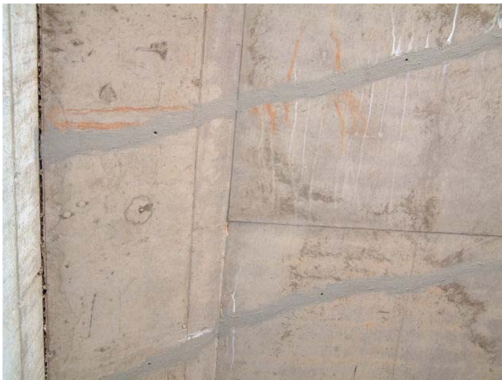
FOTOGRAFÍA 3: Otras fisuras reparadas en la parte inferior del tablero
