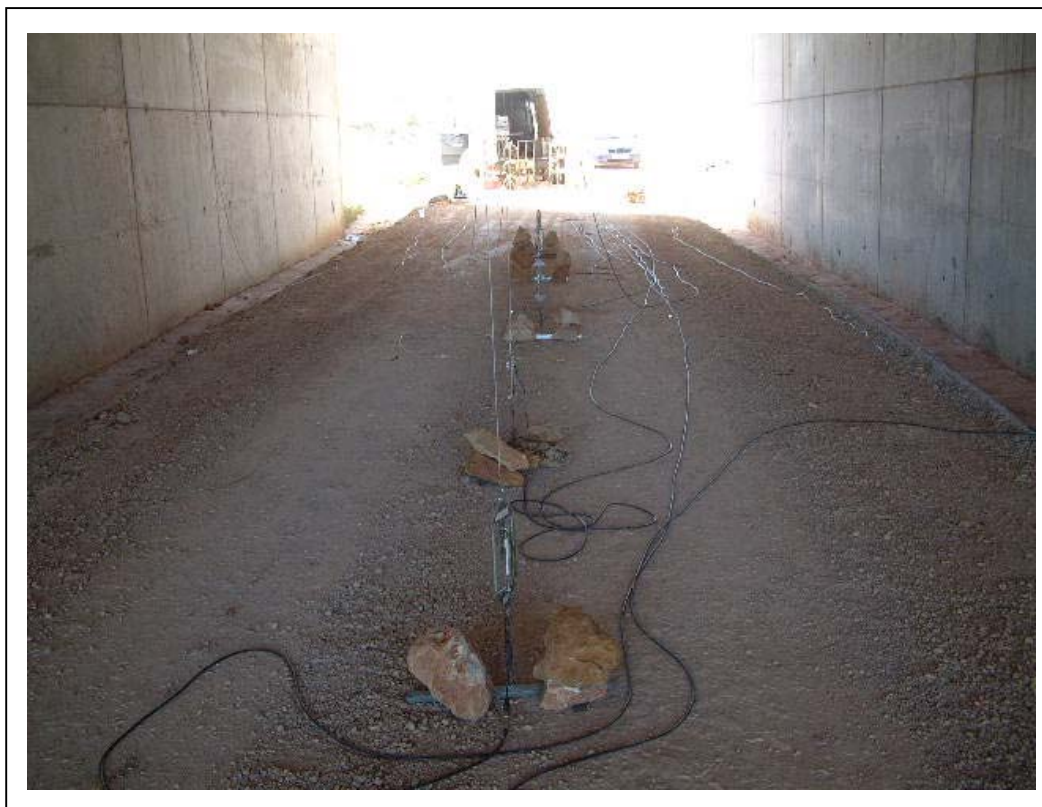
FOTOGRAFÍA 9: Transductores colocados en el centro del tablero del Paso Inferior fijados al suelo
