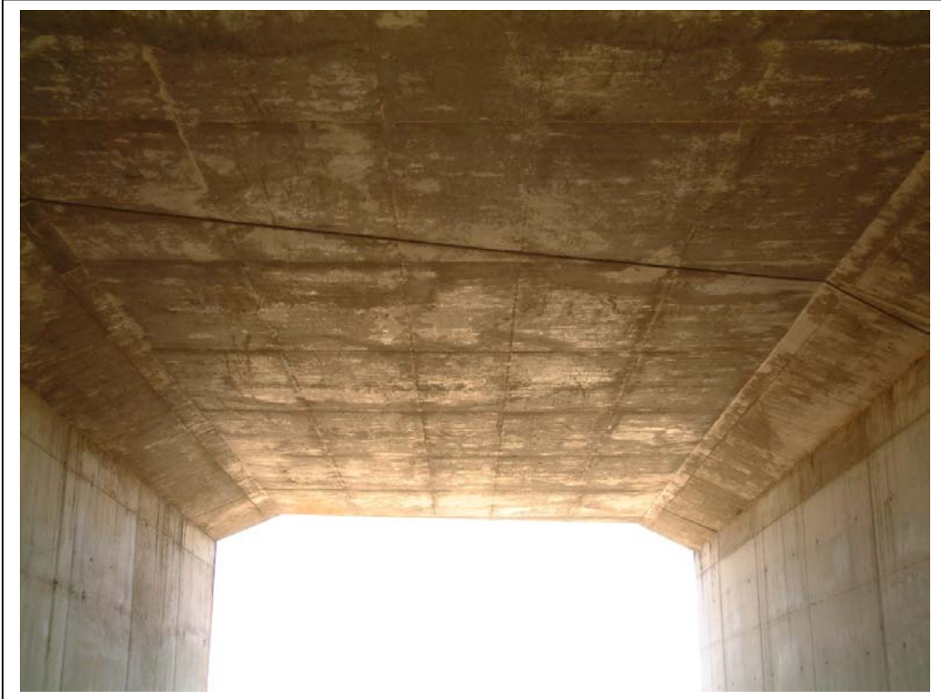
FOTOGRAFÍA N° 7: VISTA INFERIOR DEL TABLERO DESDE EL LADO DERECHO
