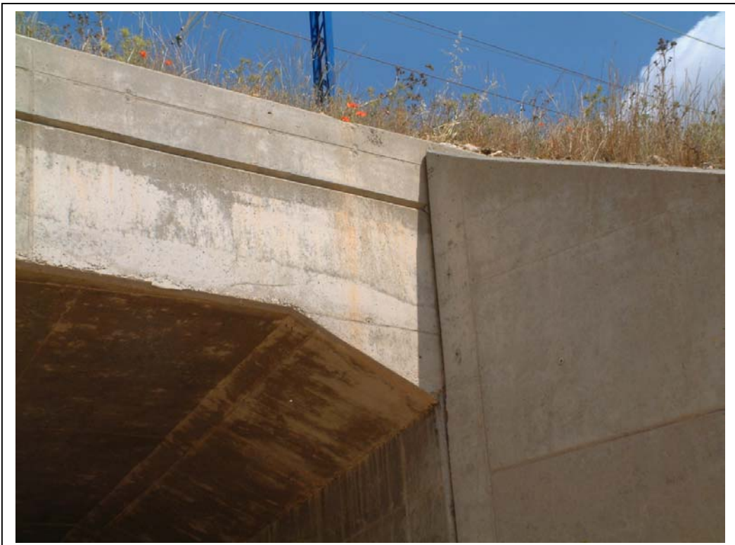
FOTOGRAFÍA Nº 6: UNIÓN TABLERO-ESTRIBO ZARAGOZA
