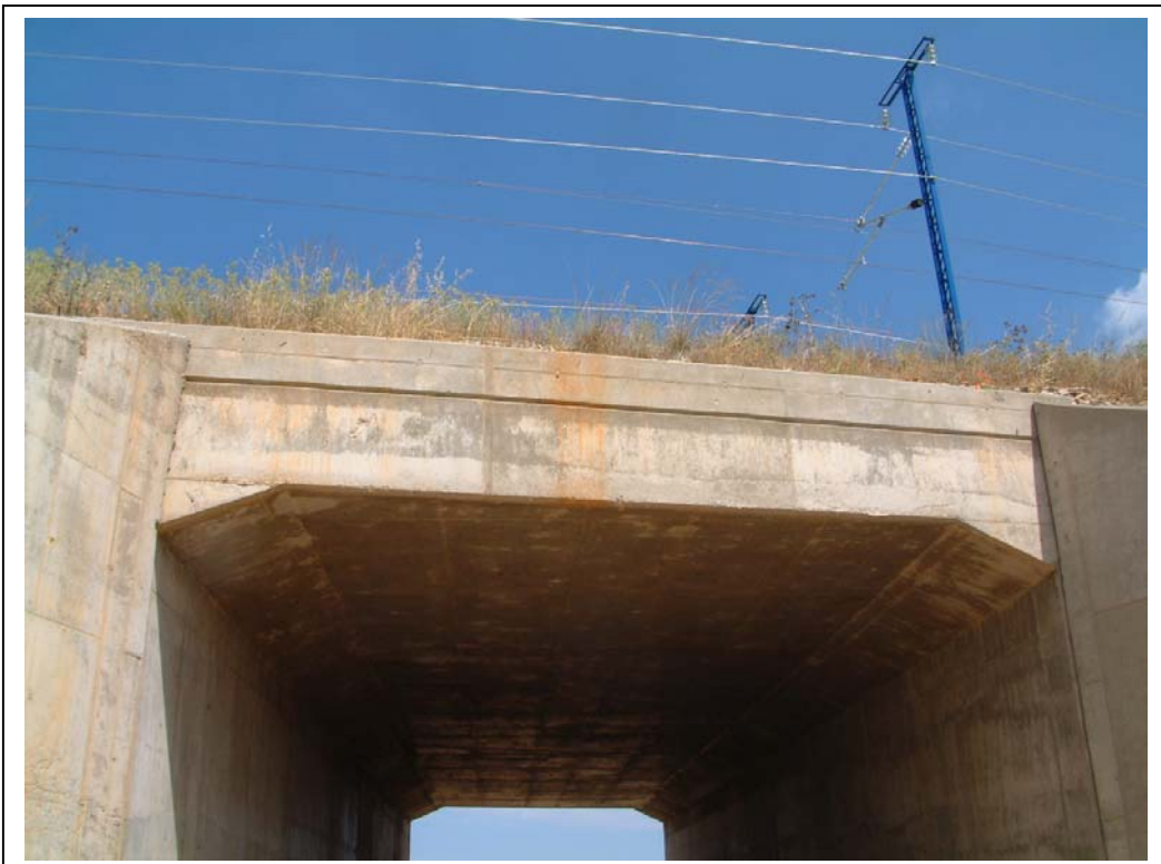
FOTOGRAFÍA Nº 2: VISTA LATERAL DERECHA DEL TABLERO
