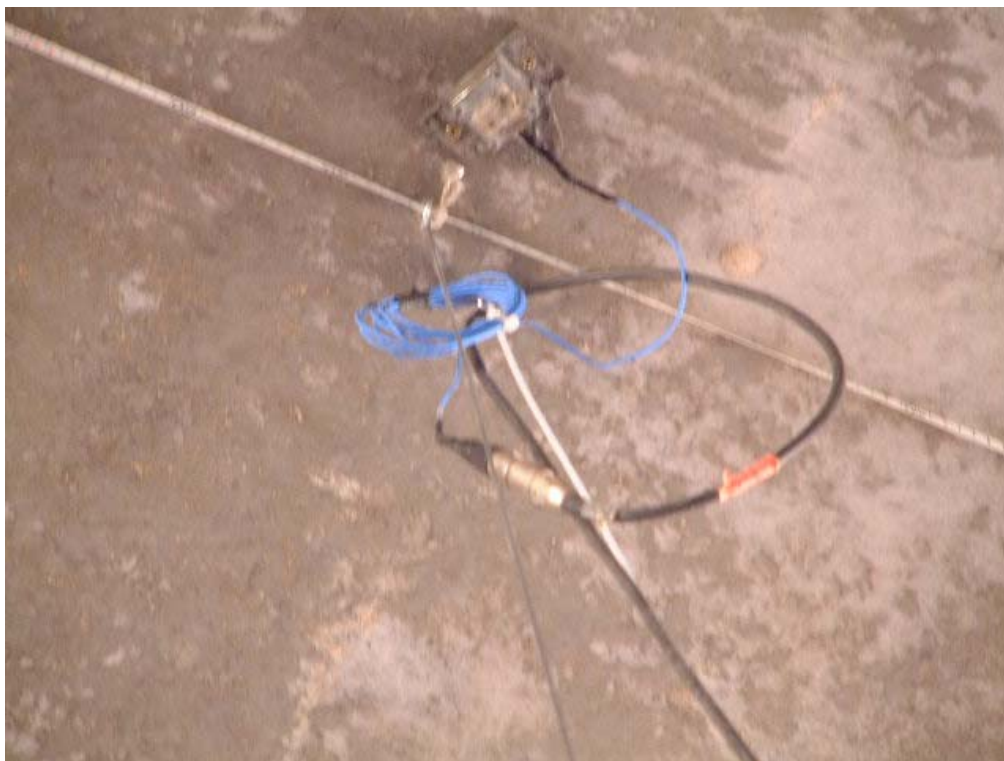
FOTOGRAFÍA 7: Acelerómetro colocado en la sección central del Paso Inferior
