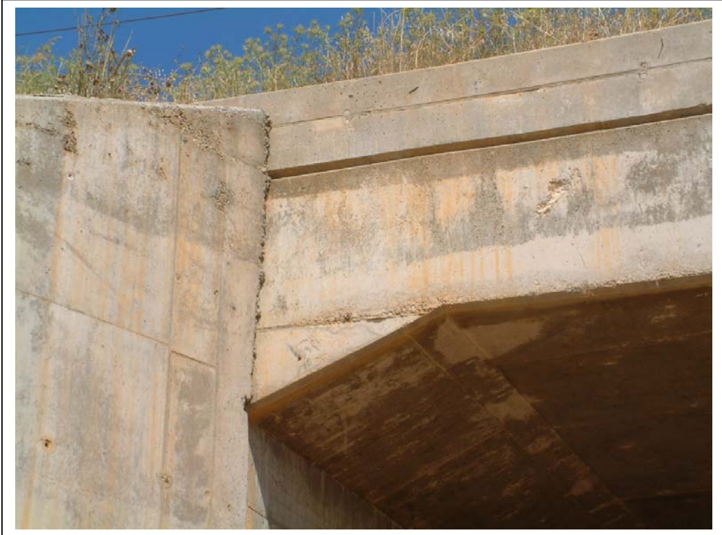
FOTOGRAFÍA Nº 5: UNIÓN TABLERO-ESTRIBO MADRID
