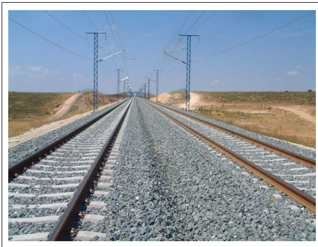
FOTOGRAFÍA 3: Vista superior desde el estribo Zaragoza
