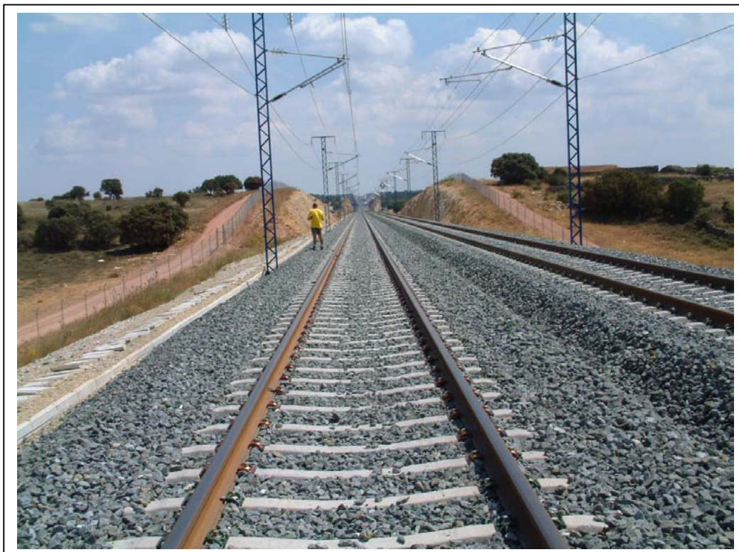
FOTOGRAFÍA Nº 9: VISTA SUPERIOR DESDE EL ESTRIBO MADRID
