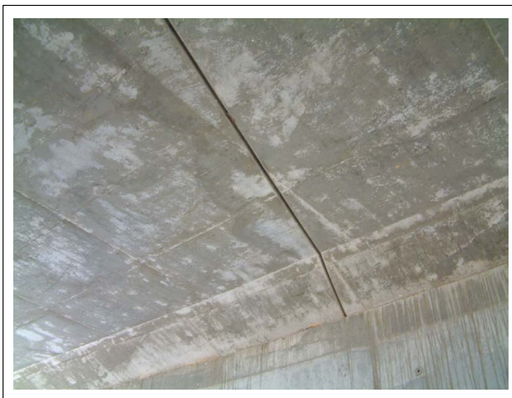
FOTOGRAFÍA 2: Junta longitudinal en tablero
