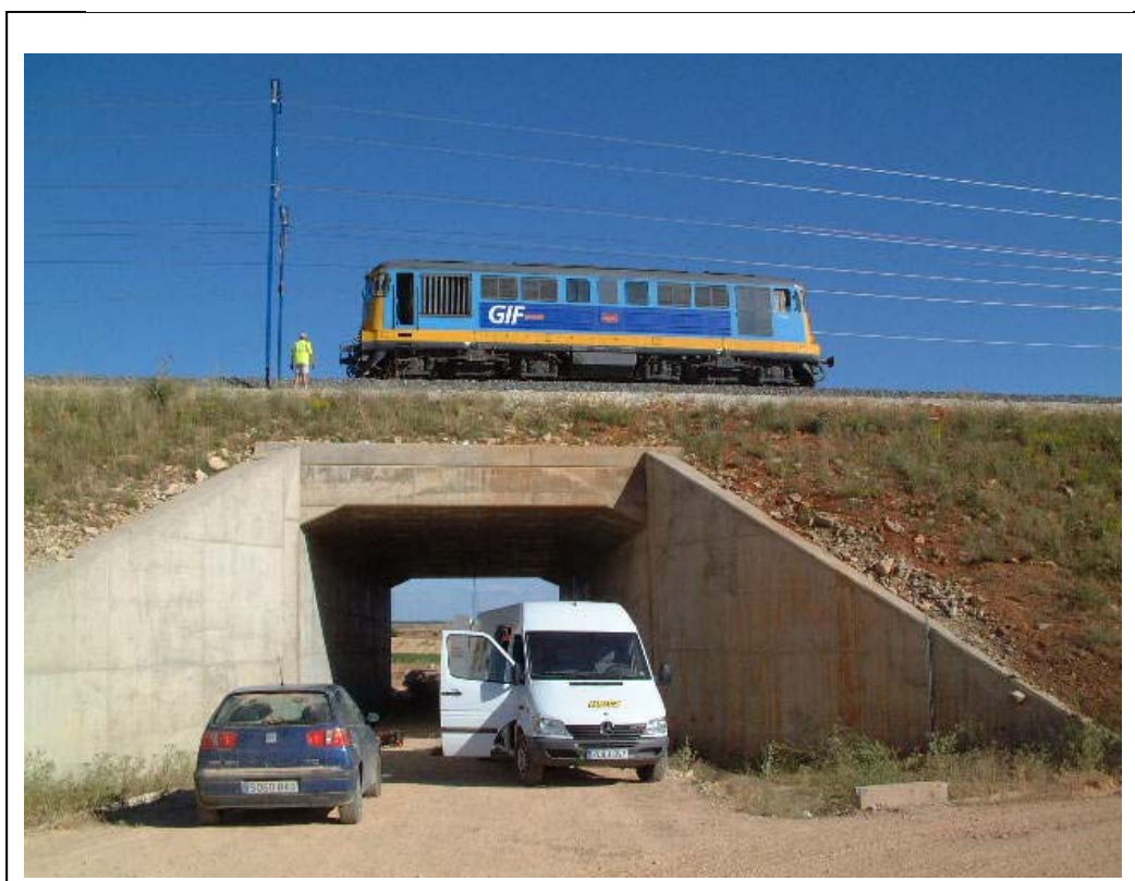
FOTOGRAFÍA 10: Locomotoras posicionadas para la prueba estática (vista lateral izquierda)
