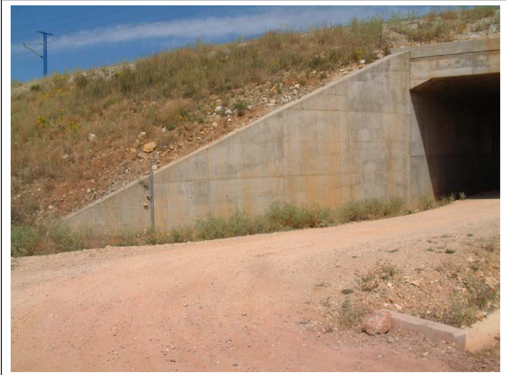
FOTOGRAFÍA Nº 3: ALETA DERECHA DEL ESTRIBO MADRID
