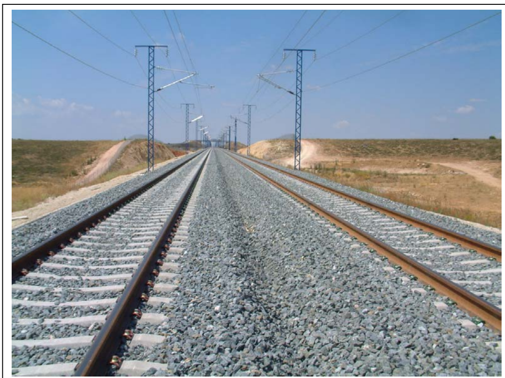
FOTOGRAFÍA Nº 10: VISTA SUPERIOR DESDE EL ESTRIBO ZARAGOZA
