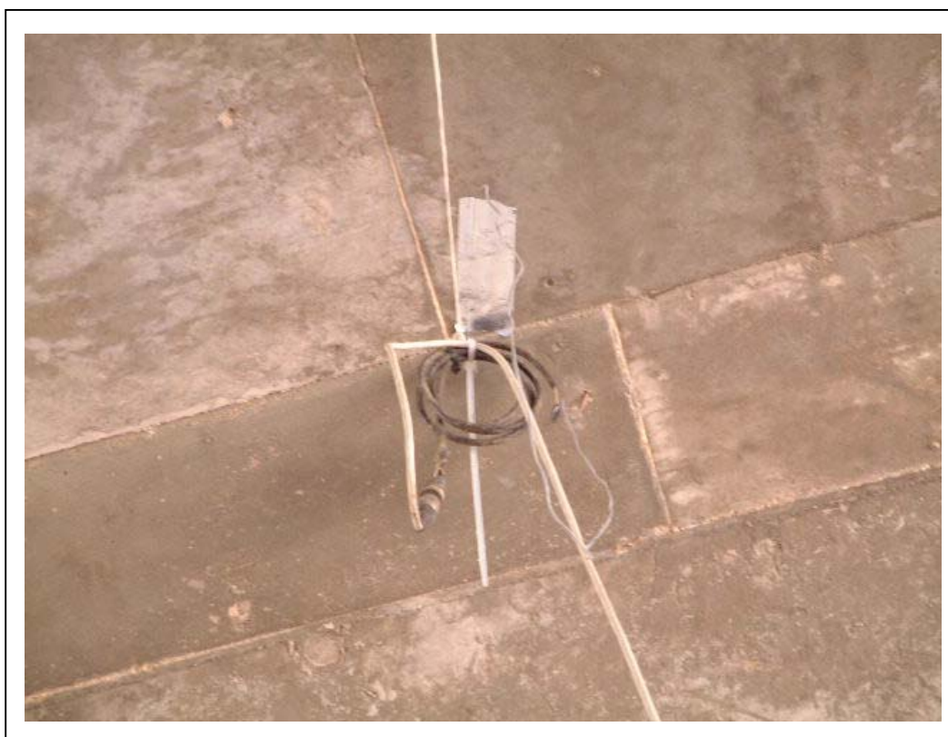
FOTOGRAFÍA 6: Idem junto a un estribo
