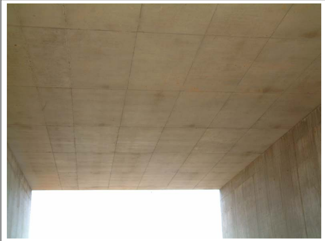
FOTOGRAFÍA N° 5: VISTA INFERIOR DE TABLERO
