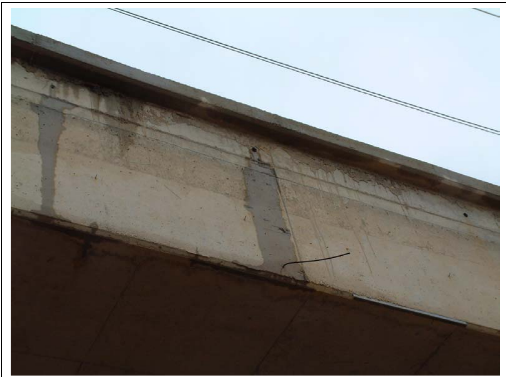
FOTOGRAFÍA N° 6: DRENAJE DEL TABLERO
