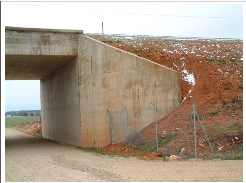
FOTOGRAFÍA Nº 4: ALETA IZQUIERDA DE ESTRIBO MADRID
