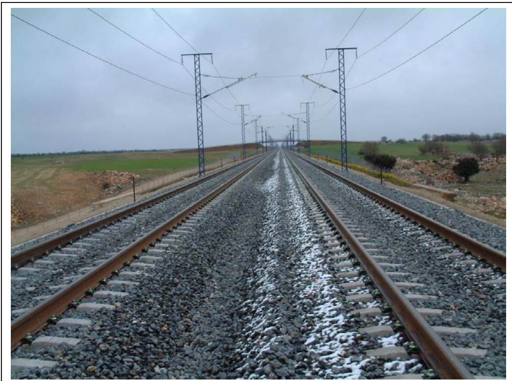
FOTOGRAFÍA Nº 8: VISTA SUPERIOR DESDE EL ESTRIBO MADRID
