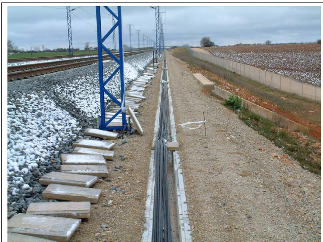
FOTOGRAFÍA Nº 10: CAMINO LATERAL EN LADO IZQUIERDO Y CANAL PARA COLOCACIÓN DE CABLEADO
