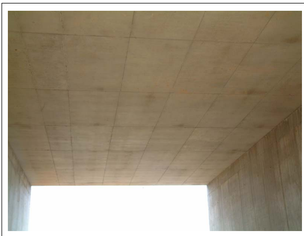
FOTOGRAFÍA 2: Vista inferior del tablero
