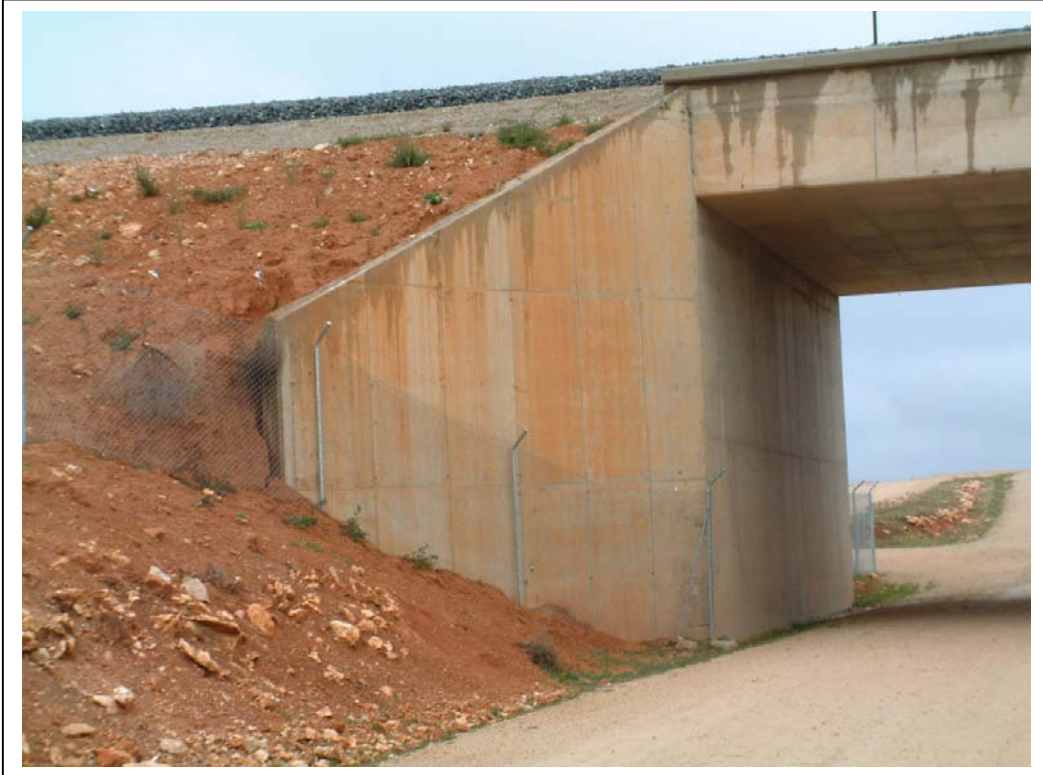
FOTOGRAFÍA Nº 3: ALETA DERECHA DE ESTRIBO MADRID
