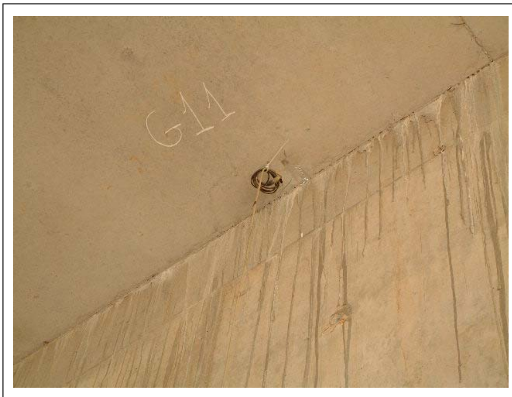
FOTOGRAFÍA 7: Galga instrumentada junto a estribo Madrid
