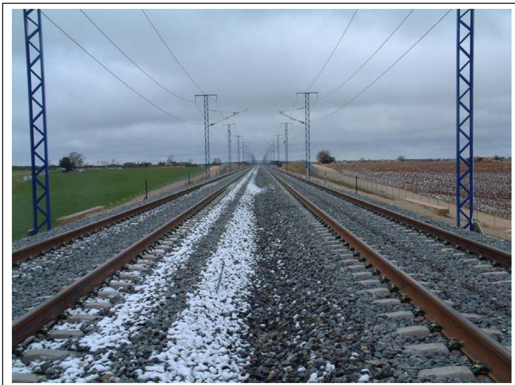
FOTOGRAFÍA Nº 9: VISTA SUPERIOR DESDE EL ESTRIBO ZARAGOZA
