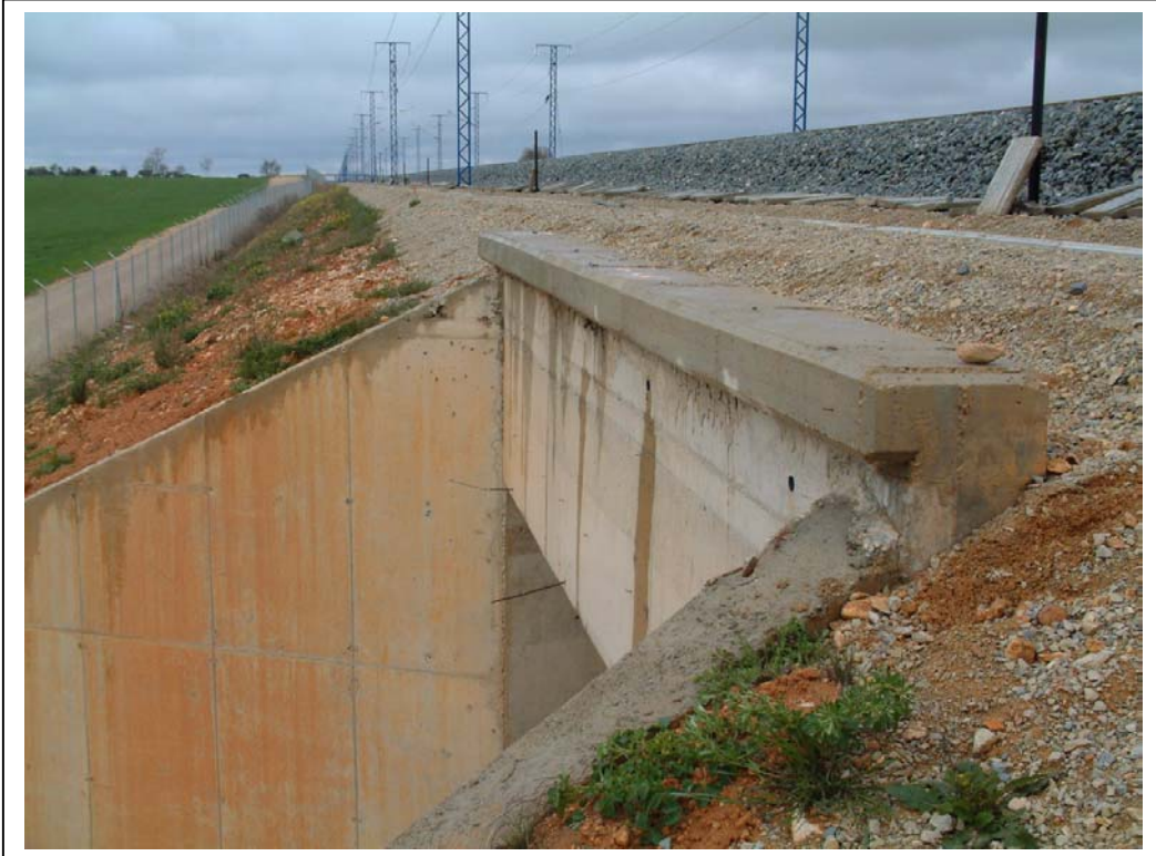
FOTOGRAFÍA Nº 7: CANTO DEL TABLERO (VISTA LATERAL DERECHA)
