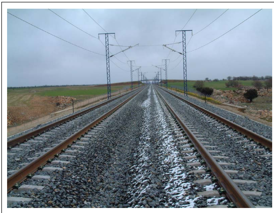
FOTOGRAFÍA 3: Vista superior desde el estribo Madrid
