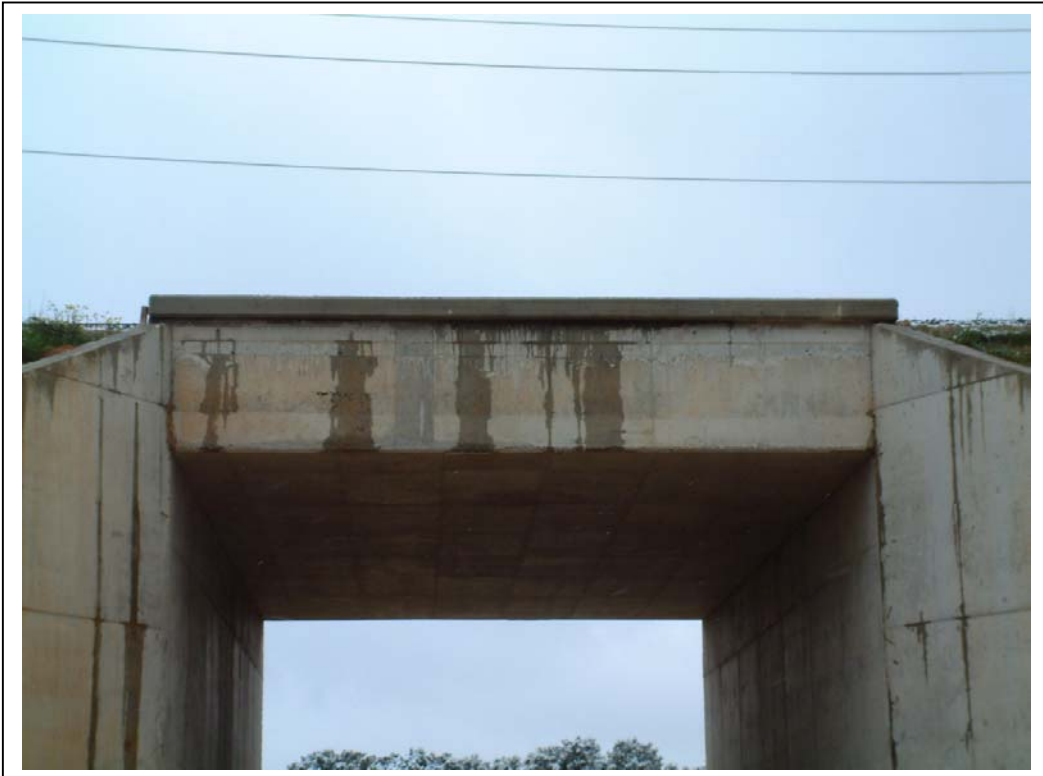
FOTOGRAFÍA N° 5: VISTA LATERAL DERECHA DEL TABLERO
