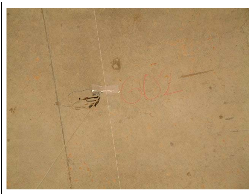
FOTOGRAFÍA 7: Galga bajo carril interior de vía 2
