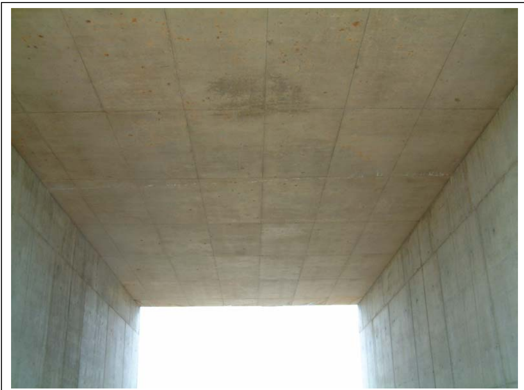
FOTOGRAFÍA N° 6: VISTA INFERIOR DEL TABLERO DESDE EL LADO DERECHO
