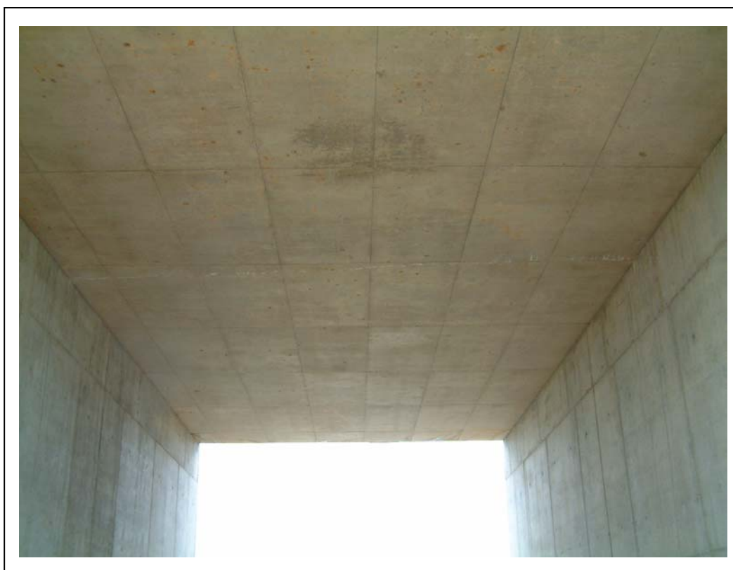
FOTOGRAFÍA 2: Vista inferior del tablero desde lado derecho
