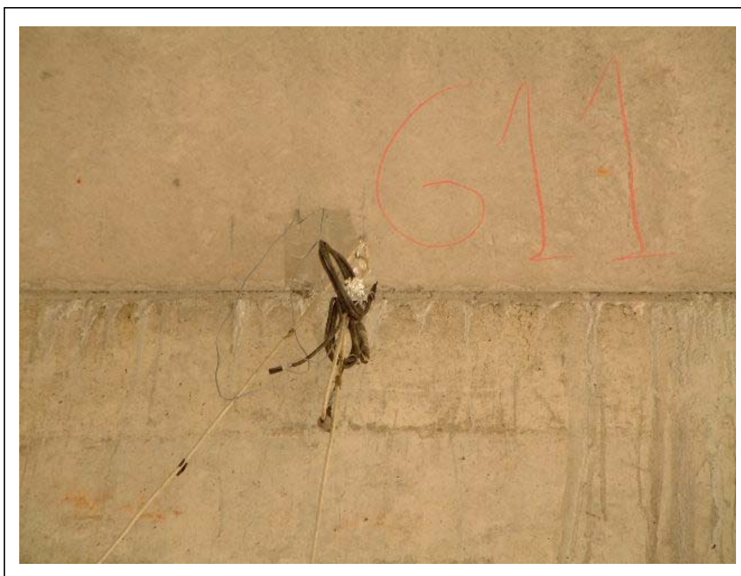
FOTOGRAFÍA 6: Galga bajo carril interior de vía 1
