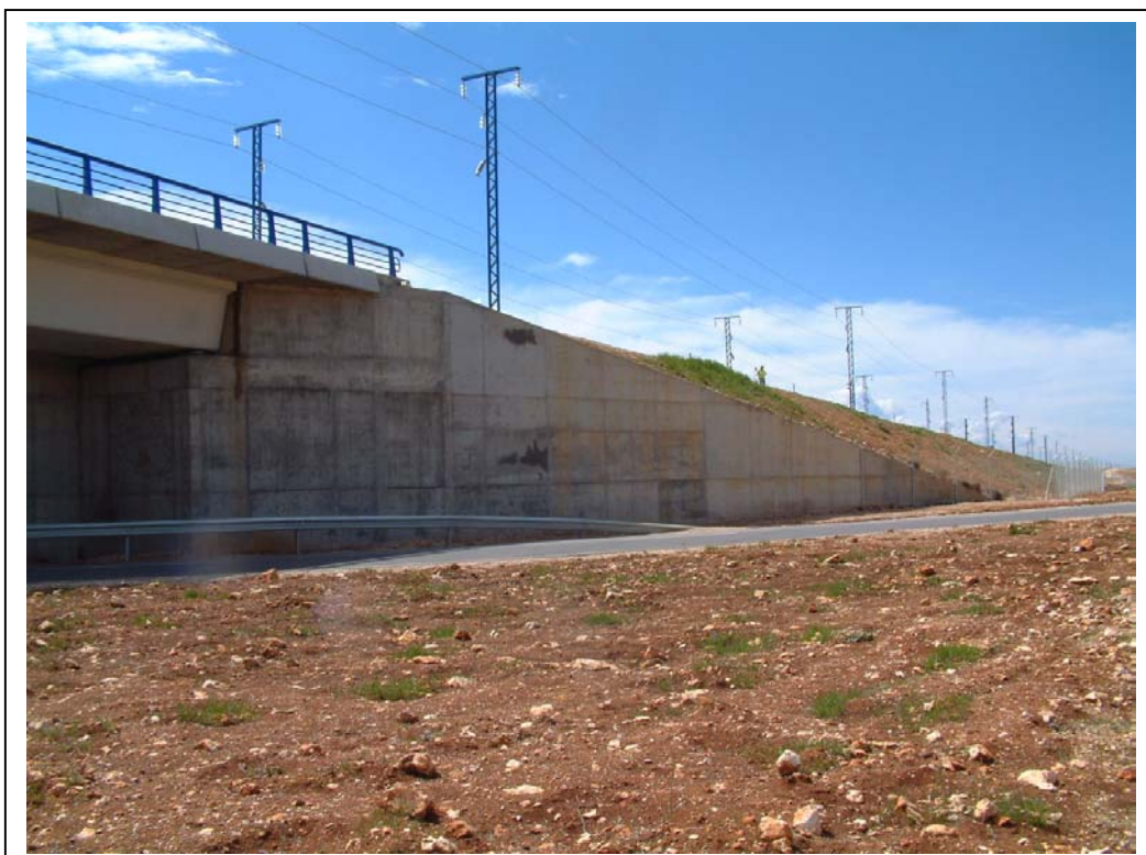
FOTOGRAFÍA Nº 4: ALETA IZQUIERDA DE ESTRIBO MADRID
