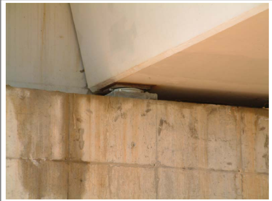
FOTOGRAFÍA Nº 7: DETALLE DE APOYO
