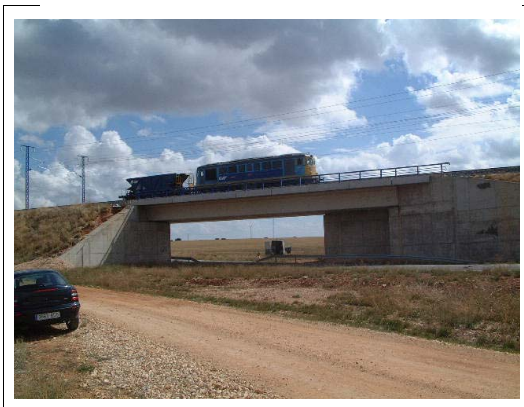
FOTOGRAFÍA 9: Trenes de carga posicionándose para la prueba estática (vista lateral derecha)
