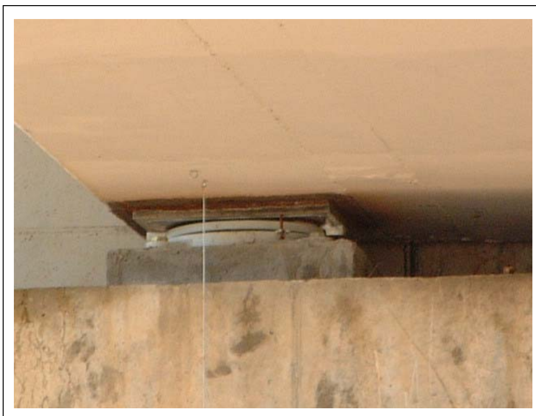
FOTOGRAFÍA 8: Detalle de transductor para medida de descenso de apoyo anclado en tablero
