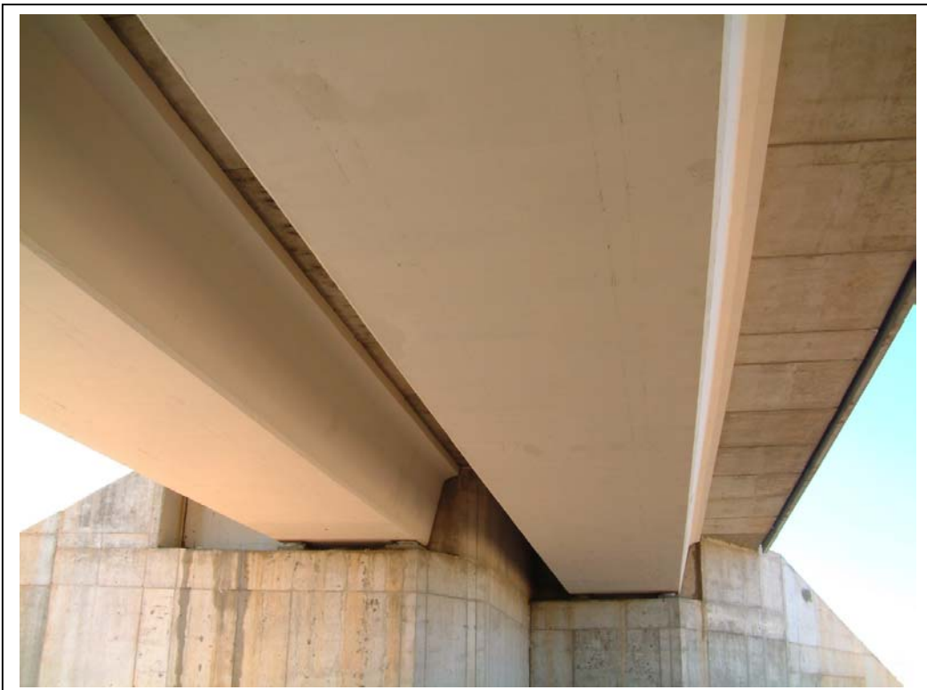
FOTOGRAFÍA Nº 6: VISTA INFERIOR DESDE EL ESTRIBO ZARAGOZA
