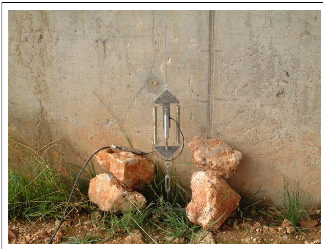
FOTOGRAFÍA 7: Transductor de desplazamiento para la medida de descenso de apoyo anclado al pie del estribo
