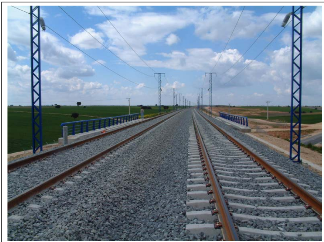
FOTOGRAFÍA N° 9: VISTA SUPERIOR DESDE EL ESTRIBO ZARAGOZA
