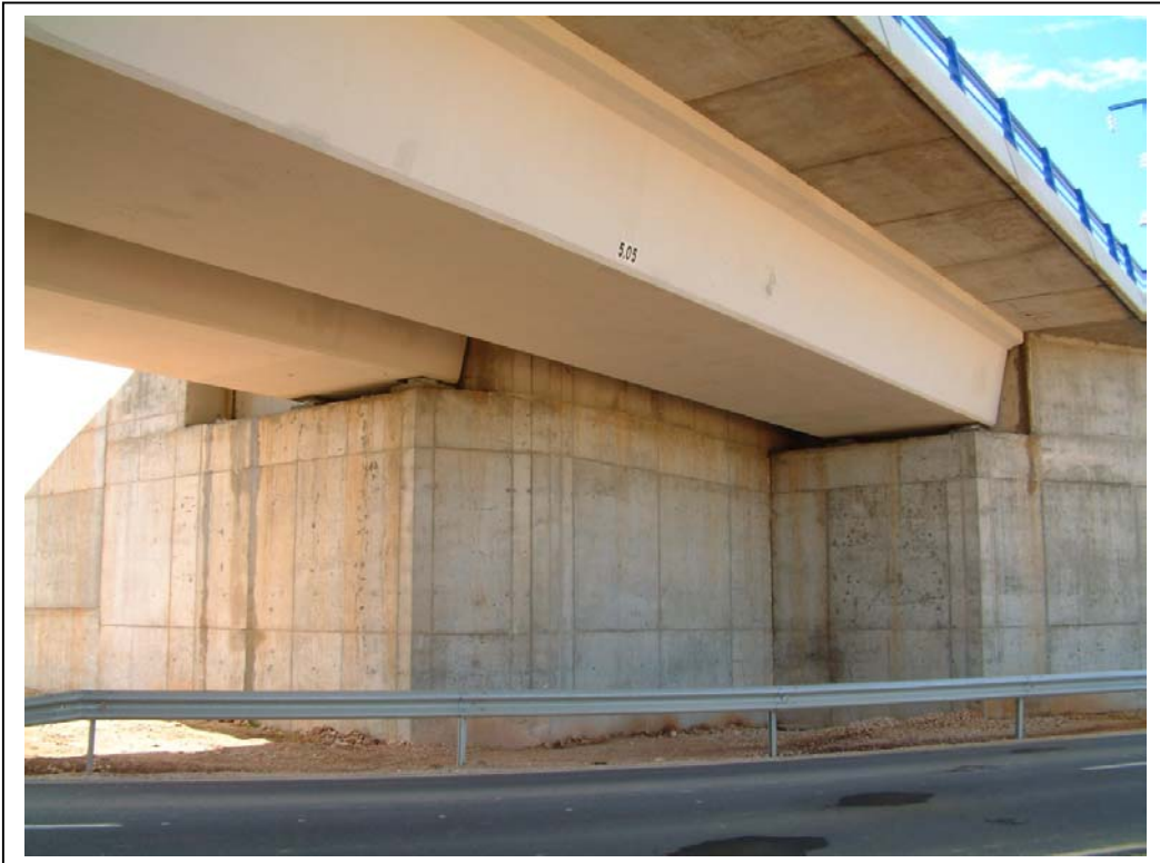
FOTOGRAFÍA Nº 5: APOYOS EN ESTRIBO MADRID
