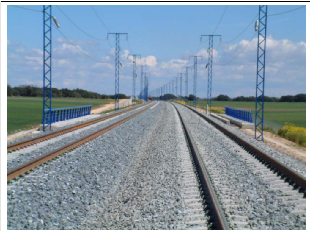
FOTOGRAFÍA Nº 8: VISTA SUPERIOR DESDE EL ESTRIBO MADRID
