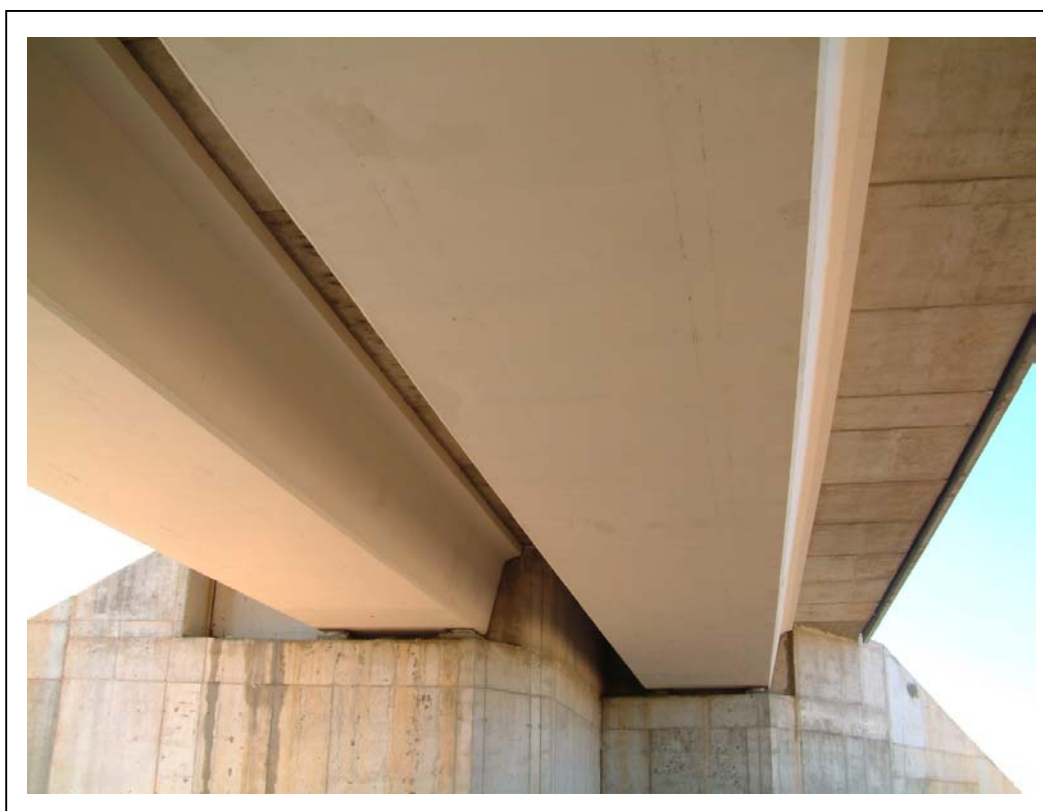
FOTOGRAFÍA 2: Vista inferior desde el estribo Zaragoza
