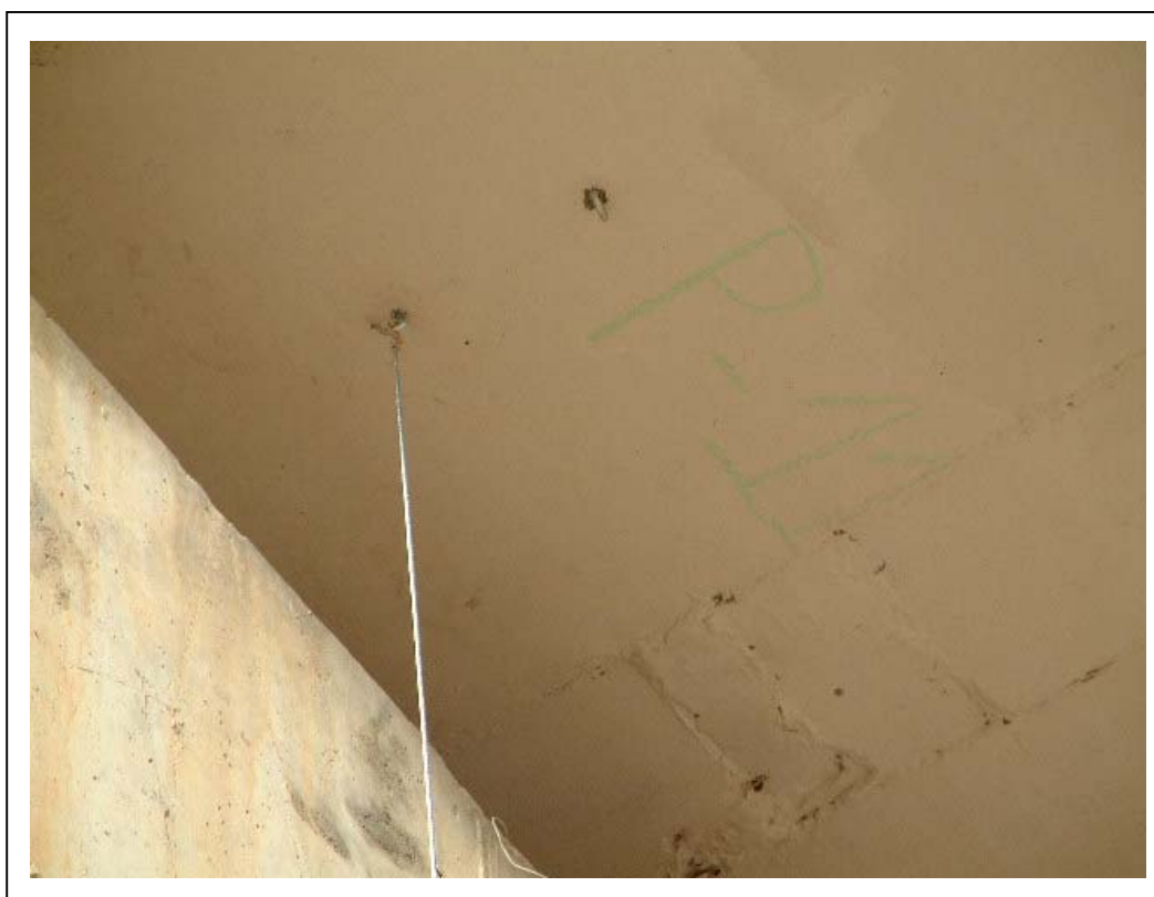
FOTOGRAFÍA 6: Apoyo de tablero 1 instrumentado (P-11)
