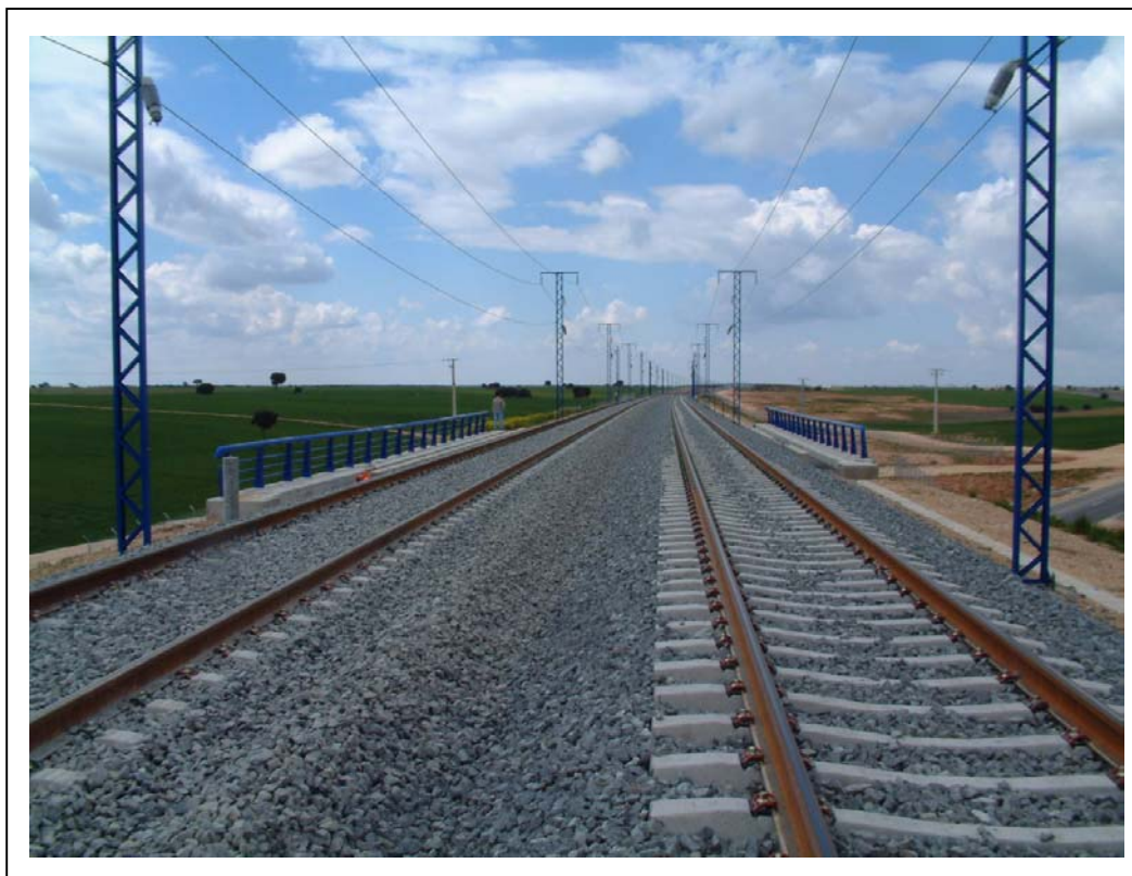
FOTOGRAFÍA 3: Vista superior desde el estribo Zaragoza
