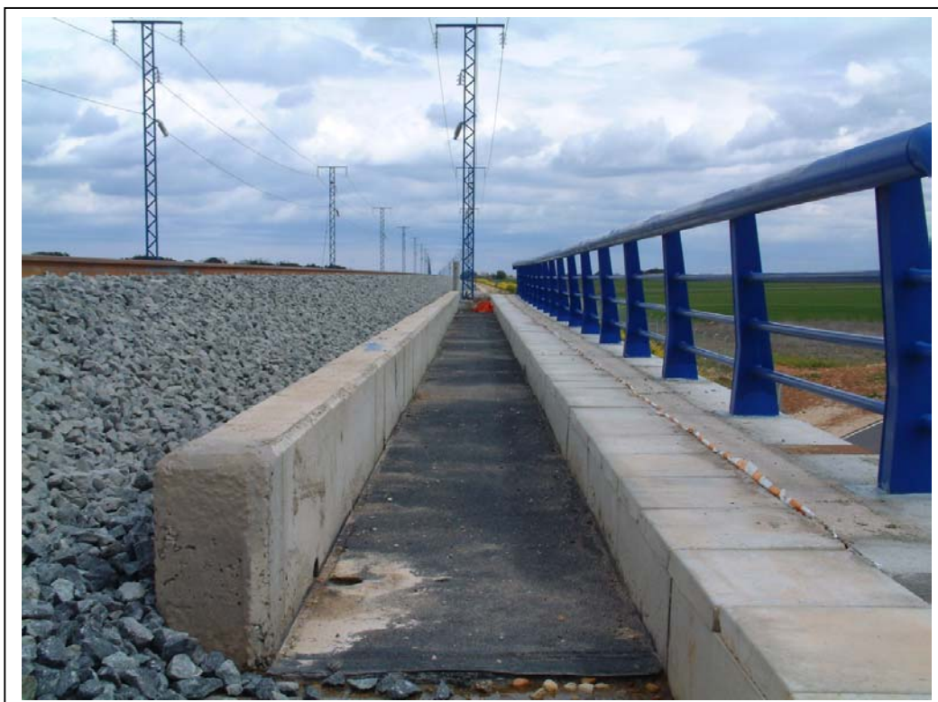
FOTOGRAFÍA N° 10: VISTA DE PASILLO LATERAL DERECHO DESDE EL ESTRIBO MADRID
