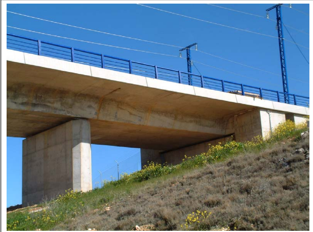
FOTOGRAFÍA N° 5: VISTA LATERAL DERECHA DE TRAMO 3
