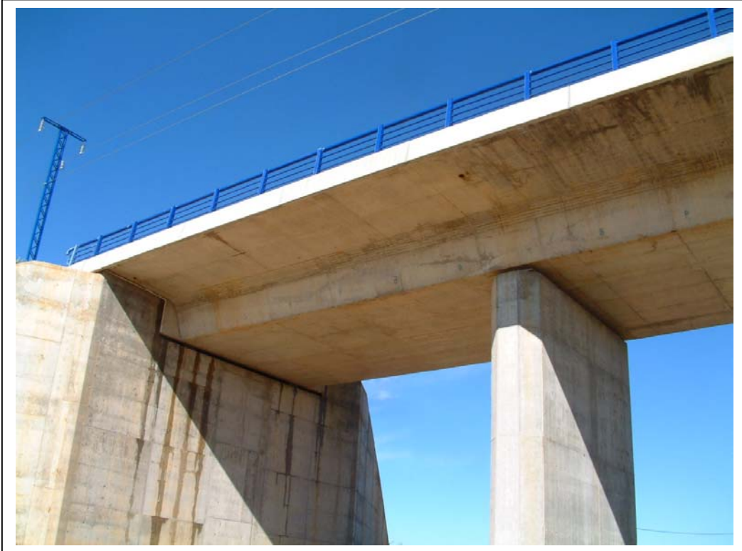
FOTOGRAFÍA N° 3: VISTA LATERAL DERECHA DE TRAMO 1
