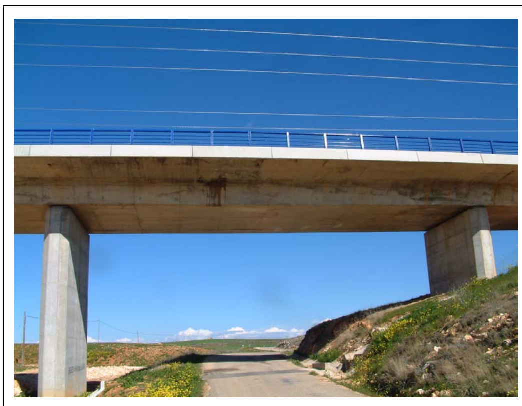
FOTOGRAFÍA 2: Vista lateral derecha de tramo 2
