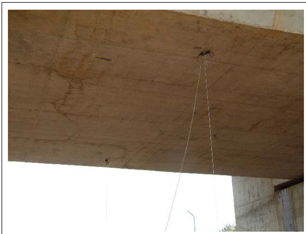
FOTOGRAFÍA 5: Galgas y flechas a 0,45 L en el tramo 1
