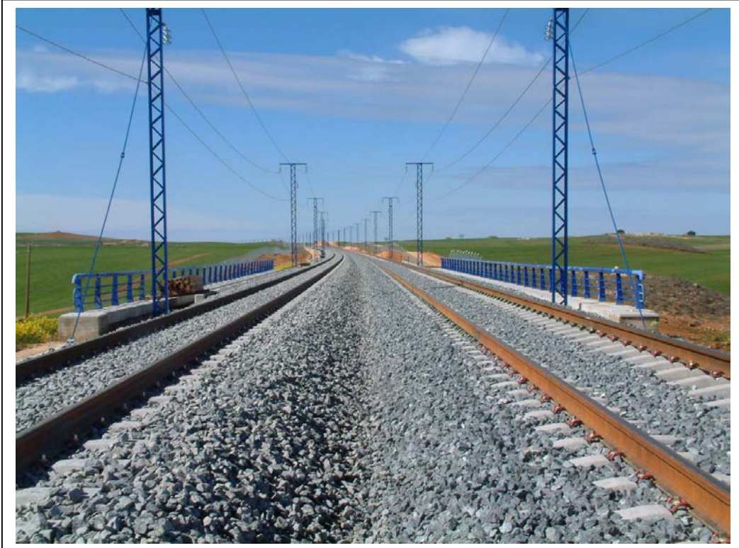
FOTOGRAFÍA N° 9: VISTA SUPERIOR DESDE ESTRIBO ZARAGOZA
