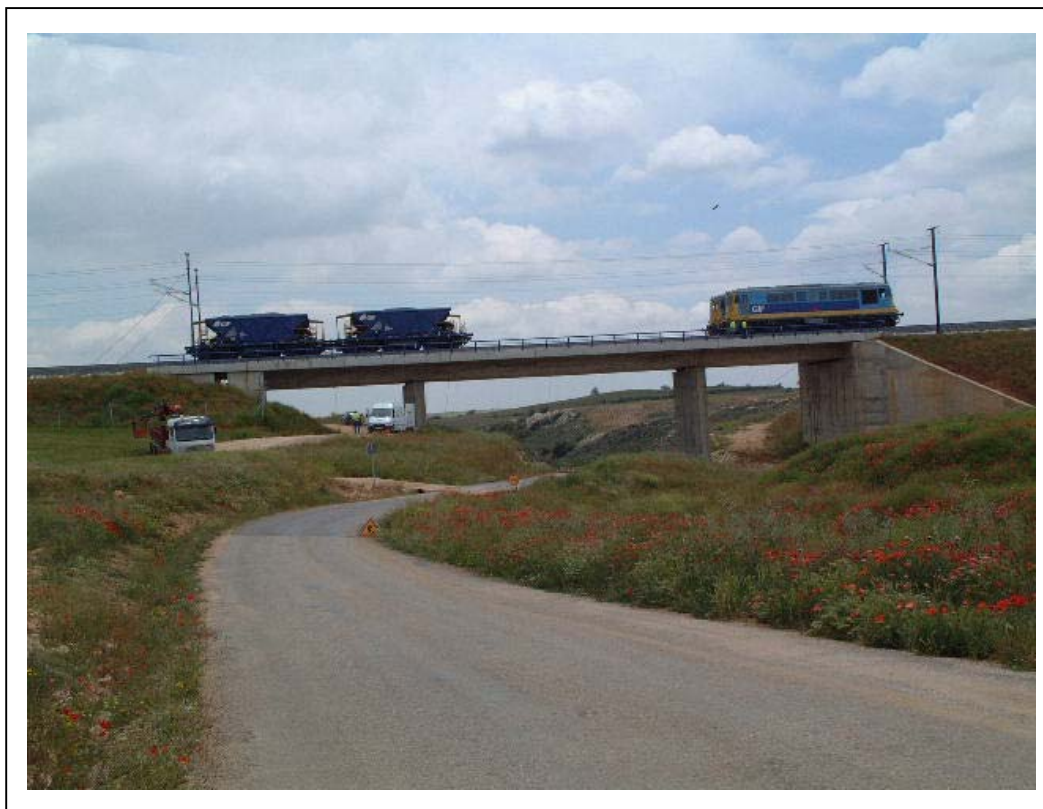
FOTOGRAFÍA 9: Trenes de carga posicionados para la prueba ESTÁTICA 01 (vista lateral derecha)
