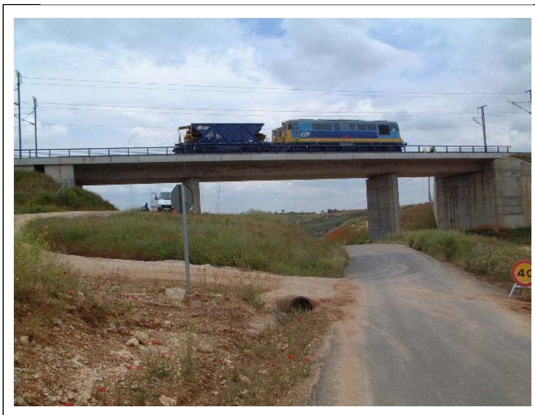
FOTOGRAFÍA 10: Trenes de carga posicionados para la prueba ESTÁTICA 02 (vista lateral derecha)
