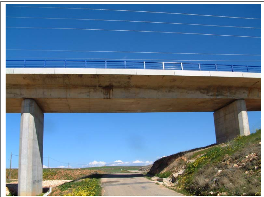
FOTOGRAFÍA N° 4: VISTA LATERAL DERECHA DE TRAMO 2
