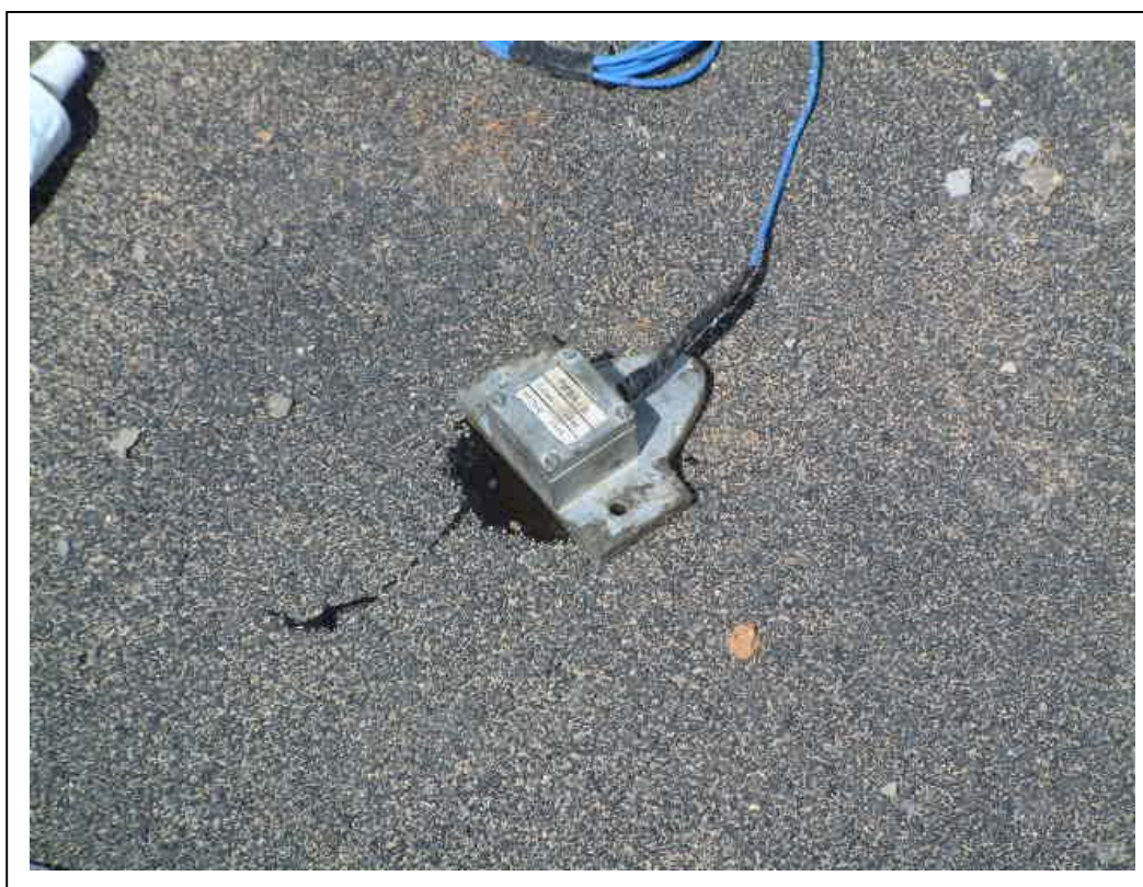
FOTOGRAFÍA 8: Acelerómetro para la medida de la frecuencia fundamental de vibración de la estructura
