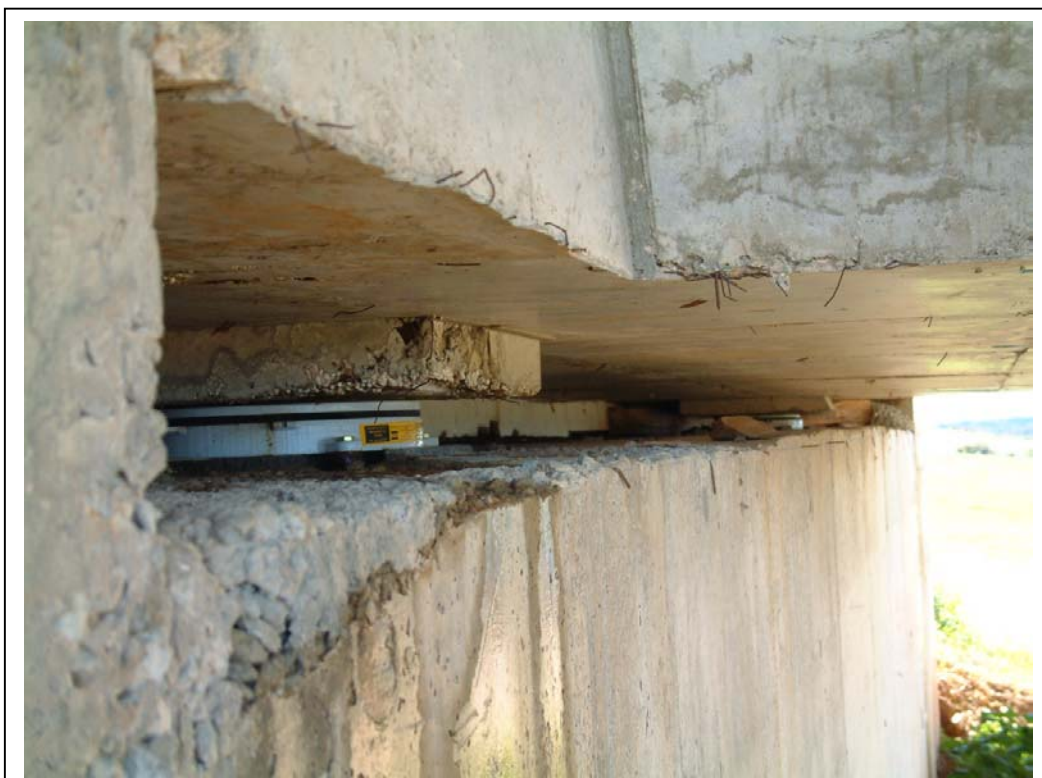
FOTOGRAFÍA Nº 8: APOYOS DE ESTRIBO
