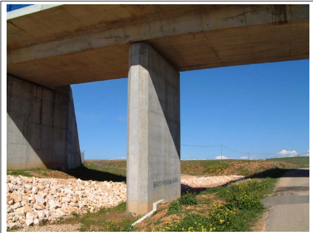
FOTOGRAFÍA N° 6: VISTA DE PILA 1
