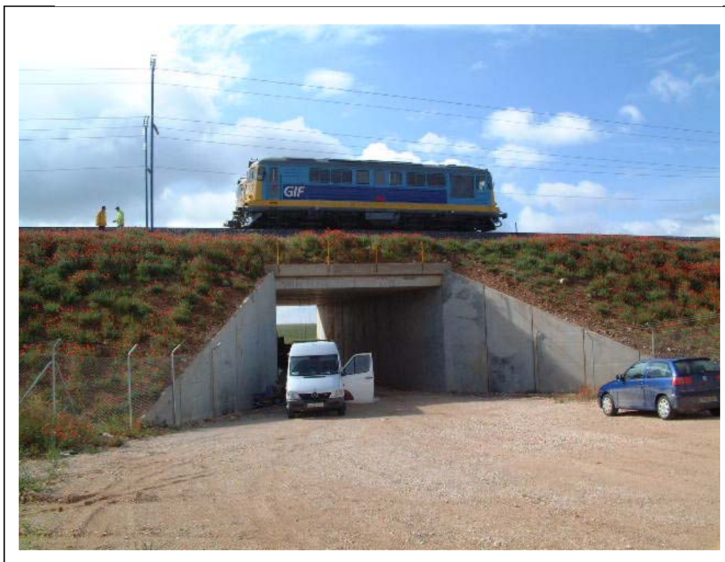
FOTOGRAFÍA 10: Trenes de carga posicionados para la prueba estática
