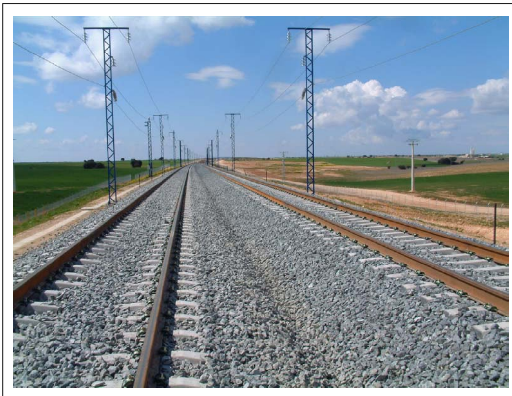
FOTOGRAFÍA 3: Vista superior desde el estribo Zaragoza
