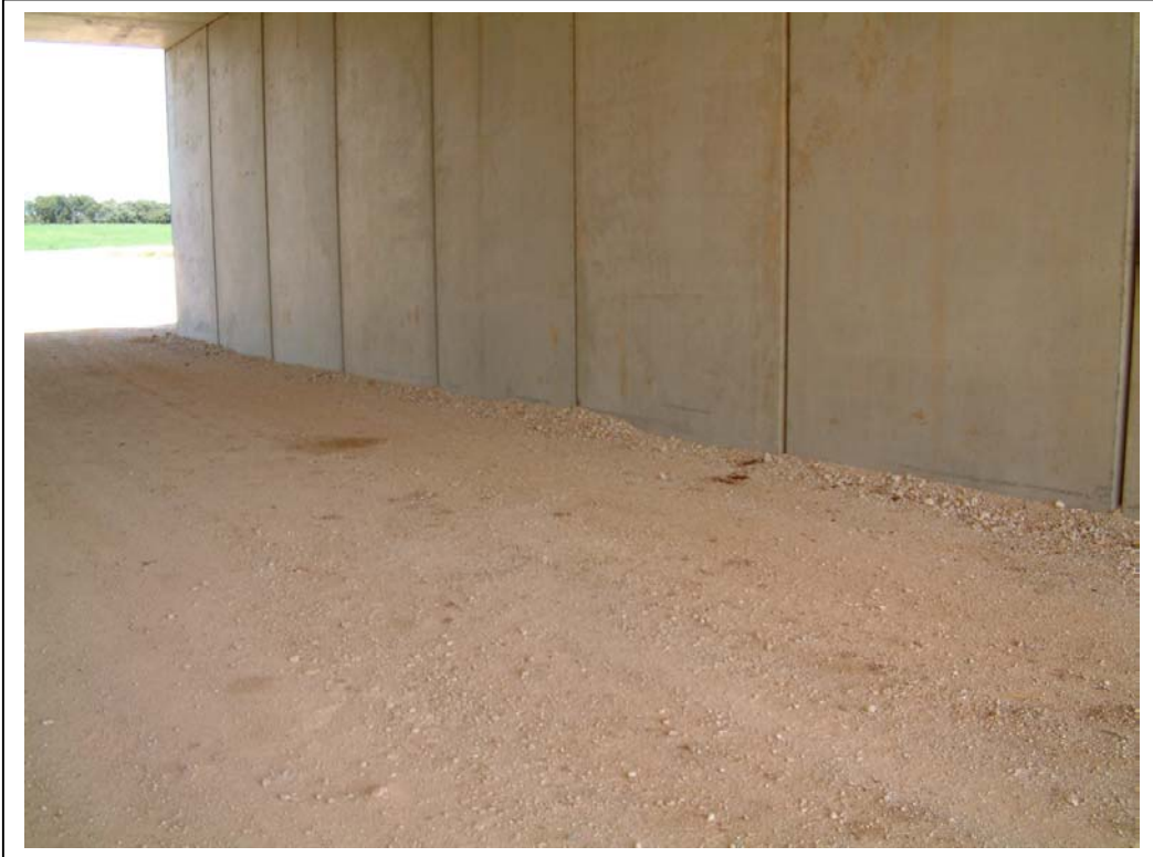
FOTOGRAFÍA N° 7: VISTA INFERIOR DE ESTRIBO
