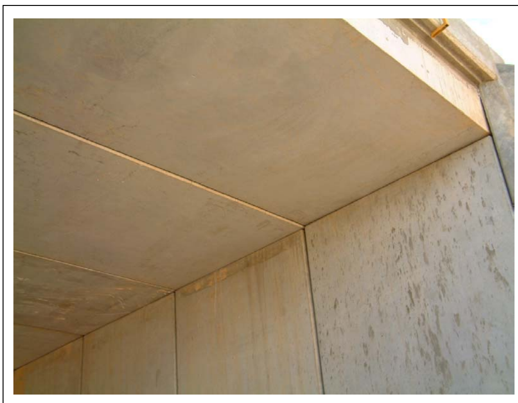
FOTOGRAFÍA 2: Vista inferior de lado izquierdo de tablero junto a estribo Madrid
