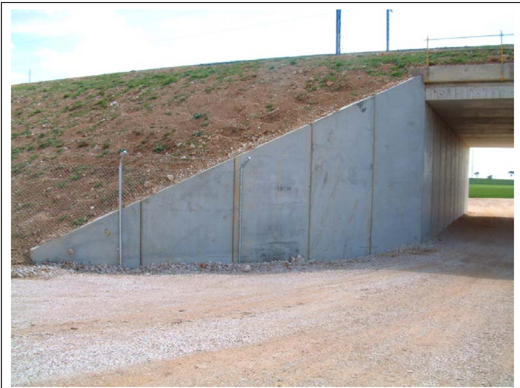
FOTOGRAFÍA Nº 4: VISTA DE ALETA IZQUIERDA DE ESTRIBO ZARAGOZA
