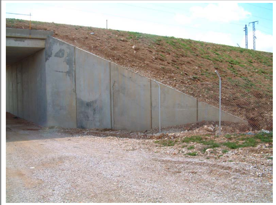
FOTOGRAFÍA Nº 3: VISTA DE ALETA IZQUIERDA DE ESTRIBO MADRID
