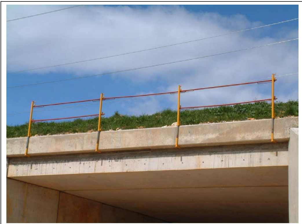
FOTOGRAFÍA N° 8: BARRERA DE PROTECCIÓN LATERAL EN TABLERO
