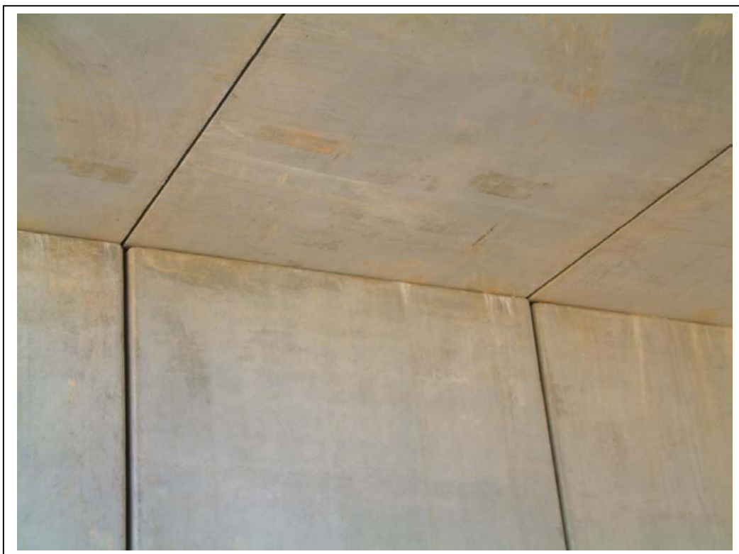
FOTOGRAFÍA N° 7: JUNTA DE PARAMENTO VERTICAL DE ESTRIBO Y LOSA PREFABRICADA
