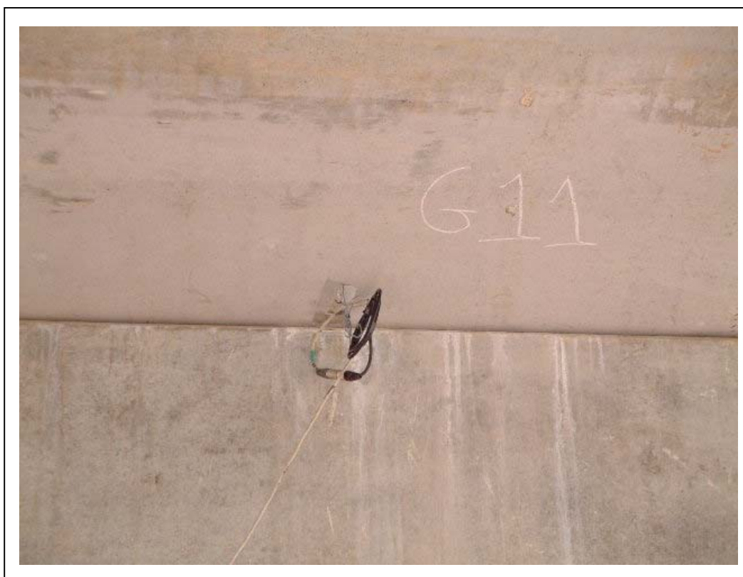
FOTOGRAFÍA 6: Galga extensométrica junto a estribo Zaragoza
