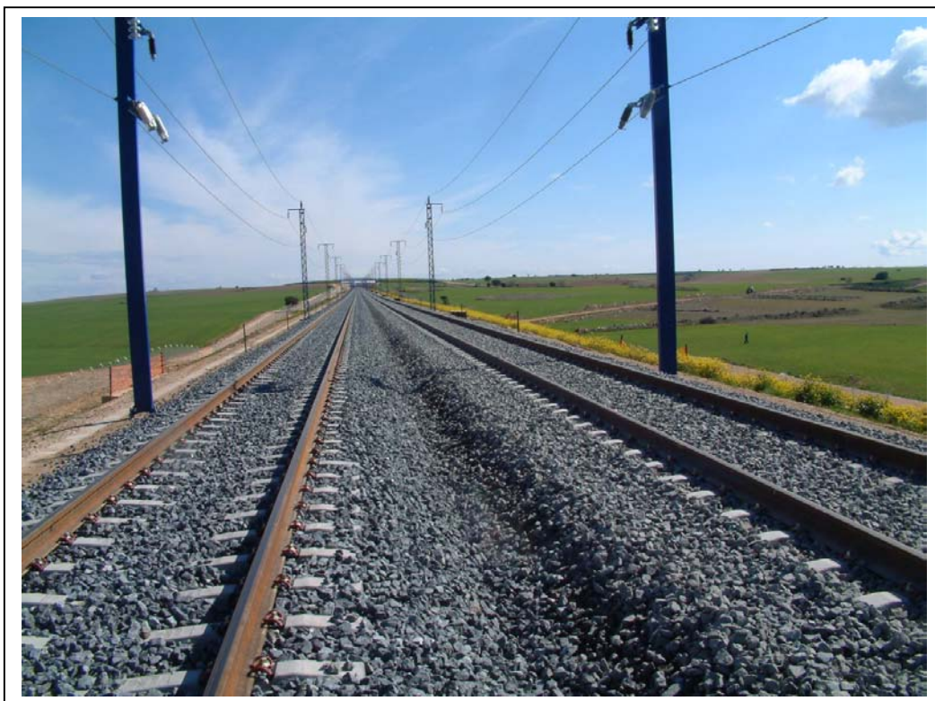
FOTOGRAFÍA Nº 9: VISTA SUPERIOR DESDE EL ESTRIBO MADRID
