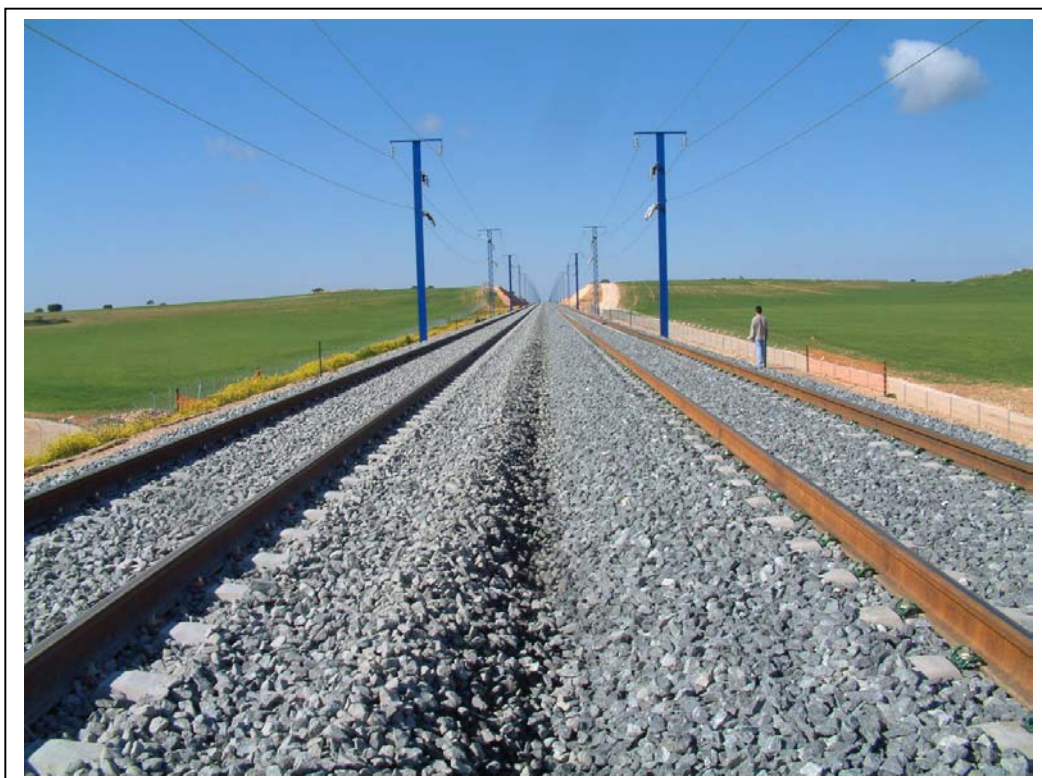
FOTOGRAFÍA Nº 10: VISTA SUPERIOR DESDE EL ESTRIBO ZARAGOZA
