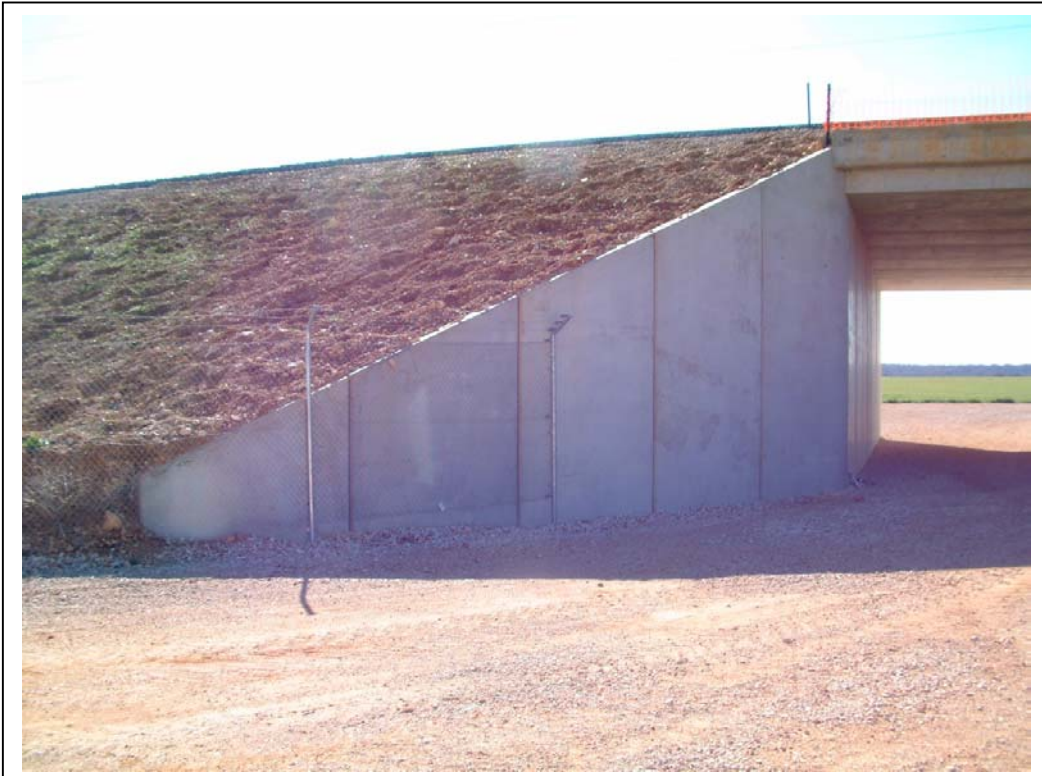
FOTOGRAFÍA Nº 3: VISTA DE ALETA IZQUIERDA DE ESTRIBO ZARAGOZA
