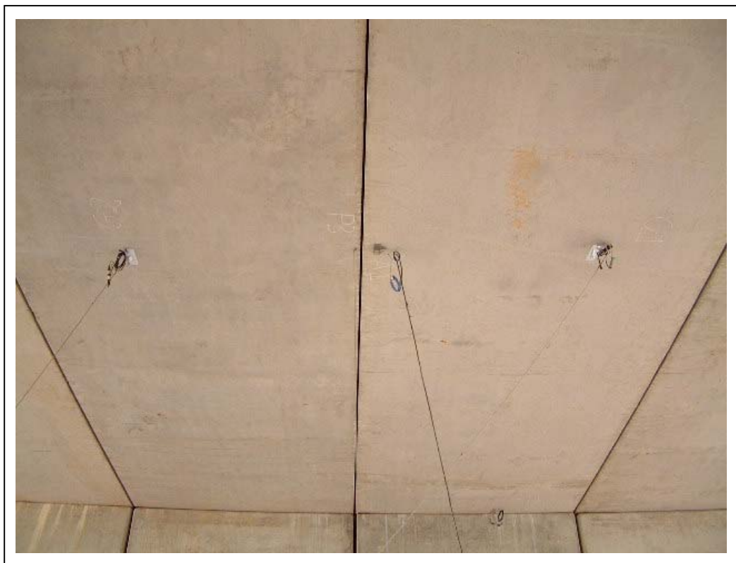
FOTOGRAFÍA 5: Galgas y flechas en el centro del tablero
