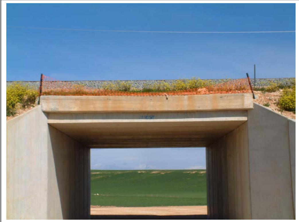
FOTOGRAFÍA N° 5: VISTA LATERAL DERECHA DE TABLERO
