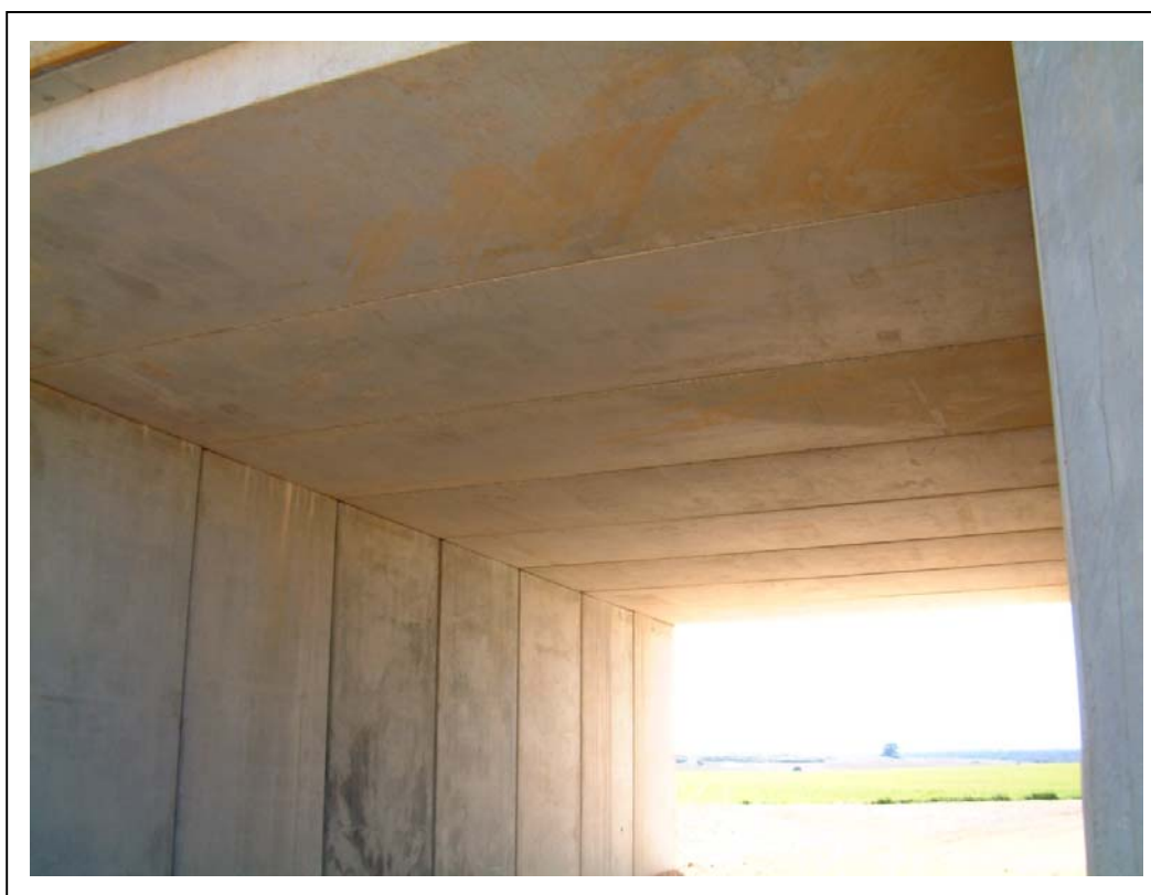
FOTOGRAFÍA 2: Vista inferior de tablero
