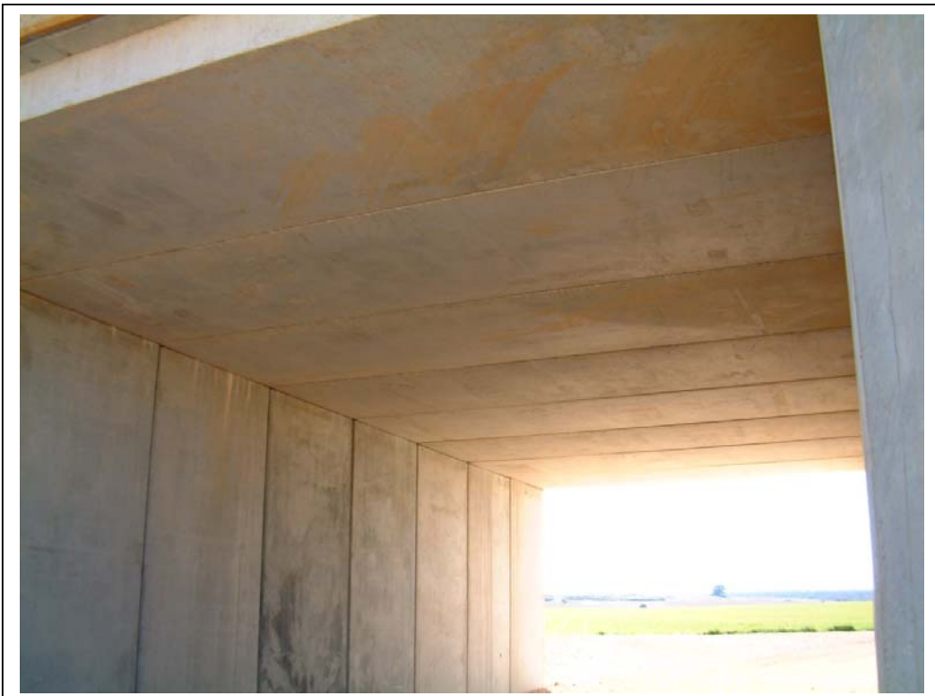
FOTOGRAFÍA N° 6: VISTA INFERIOR DE TABLERO
