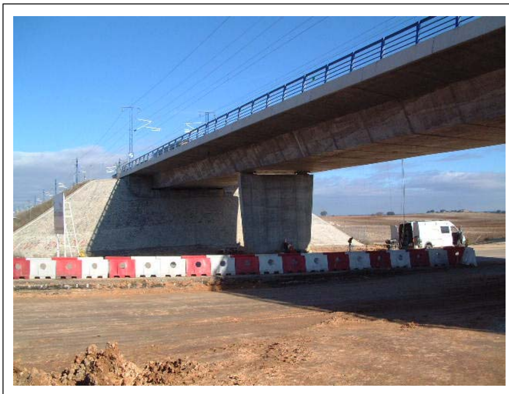
FOTOGRAFÍA 1: Alzado izquierdo de vanos 2 y 3
