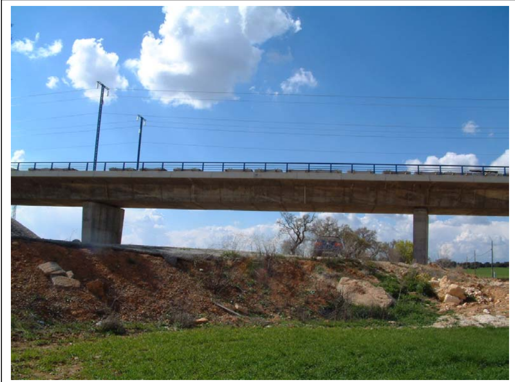
FOTOGRAFÍA Nº 3: VISTA LATERAL DERECHA DE TRAMO 2
