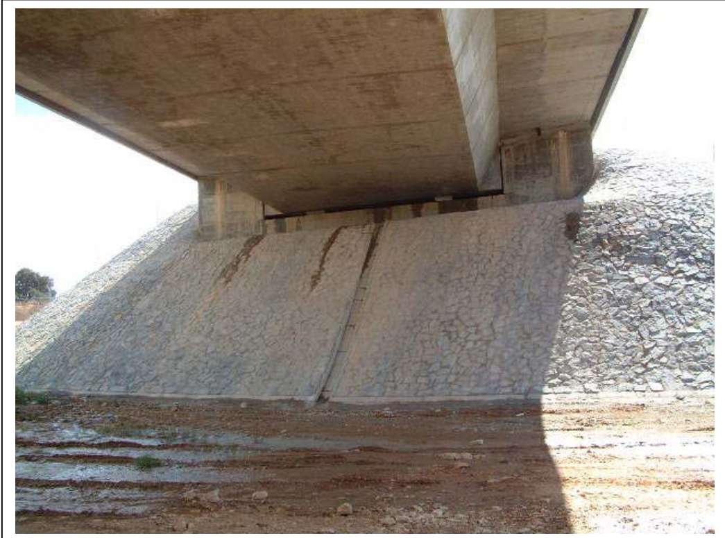
FOTOGRAFÍA N° 5: VISTA INFERIOR DE TABLERO HACIA ESTRIBO ZARAGOZA
