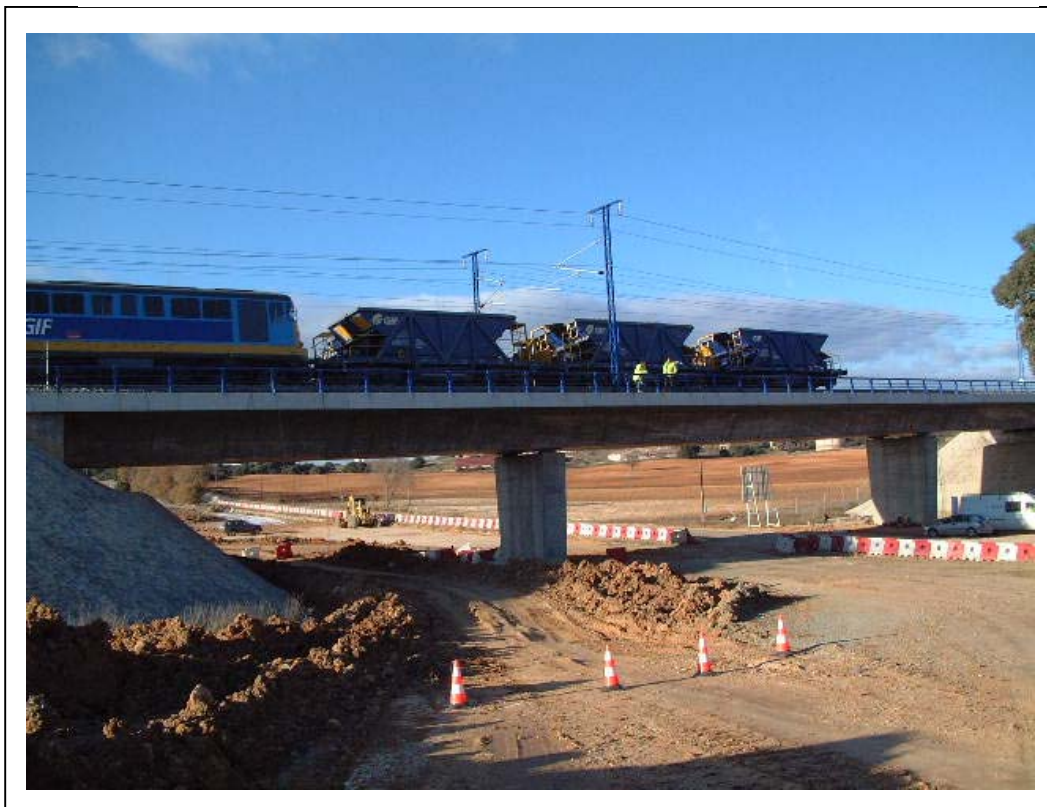
FOTOGRAFÍA 12: Trenes de carga posicionados para la prueba estática 03 en vanos 1 y 2 (vista lateral derecha)
