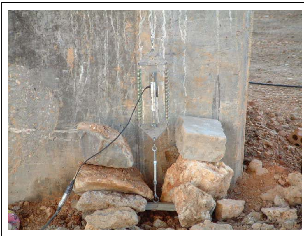
FOTOGRAFÍA 9: Aparato de medida de desplazamientos verticales en apoyos anclado al suelo
