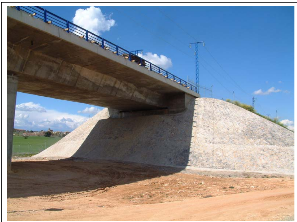
FOTOGRAFÍA Nº 7: VISTA DE ESTRIBO ZARAGOZA
