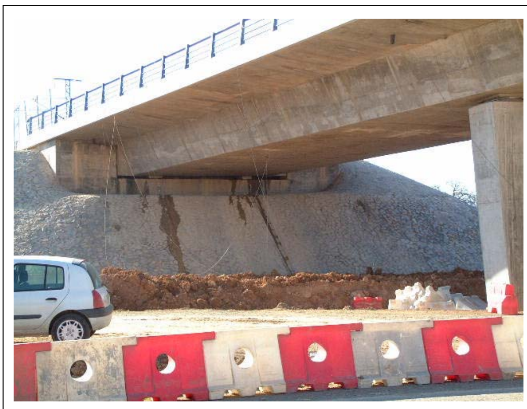
FOTOGRAFÍA 2: Vista derecha de vano 1 y estribo Madrid
