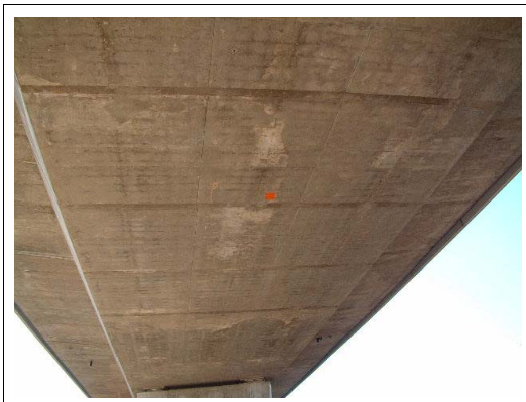
FOTOGRAFÍA 5: Adhesivo para lectura de flechas mediante láser en vano 2
