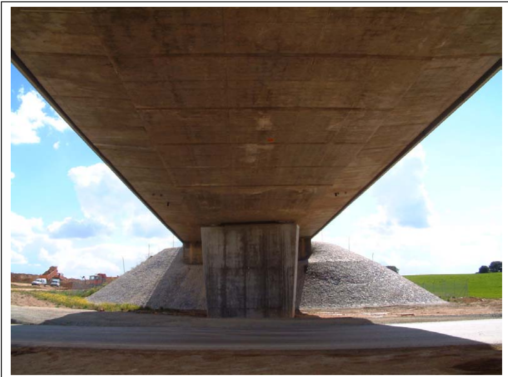
FOTOGRAFÍA Nº 4: VISTA INFERIOR DE TABLERO HACIA ESTRIBO MADRID
