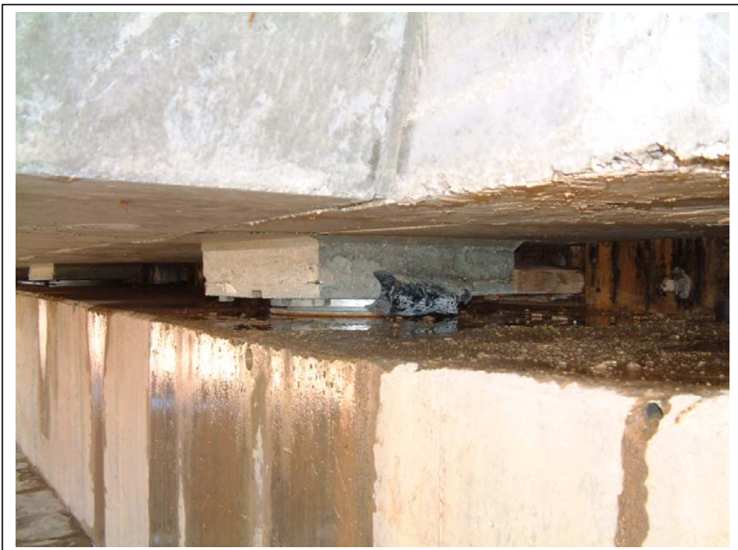
FOTOGRAFÍA Nº 10: APOYOS DE ESTRIBO MADRID
