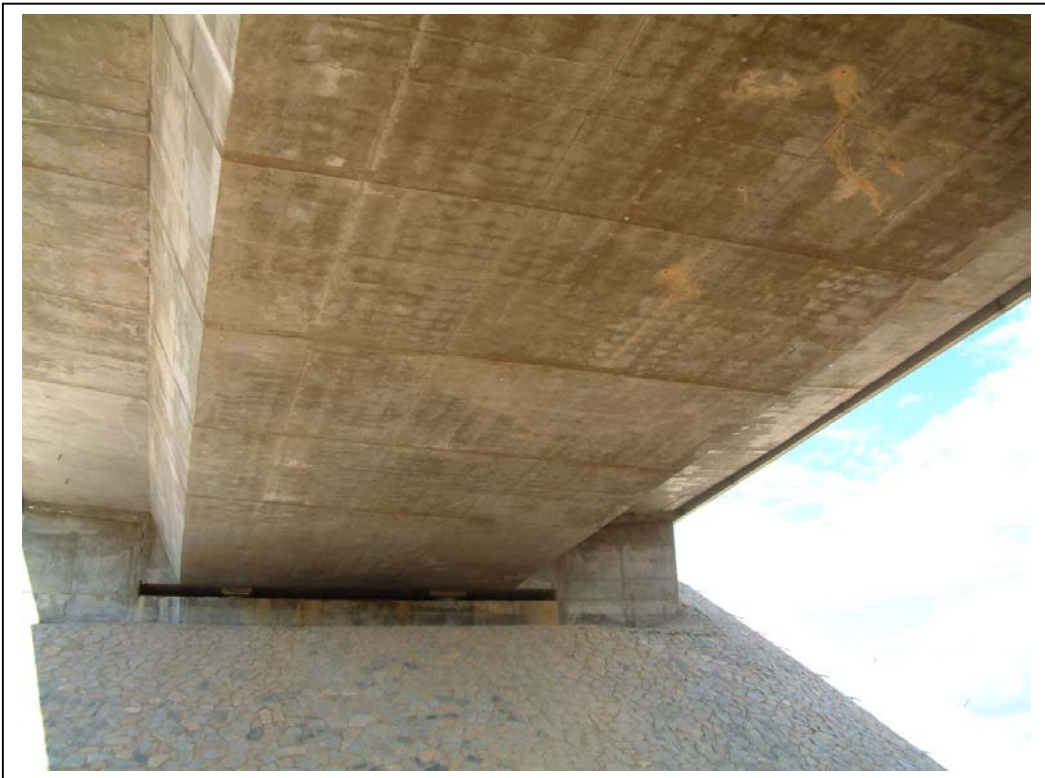
FOTOGRAFÍA N° 6: VISTA DE ESTRIBO MADRID
