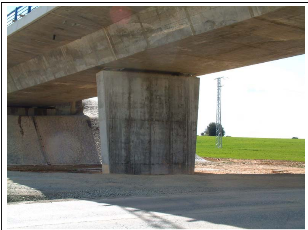
FOTOGRAFÍA Nº 8: VISTA DE PILA 1
