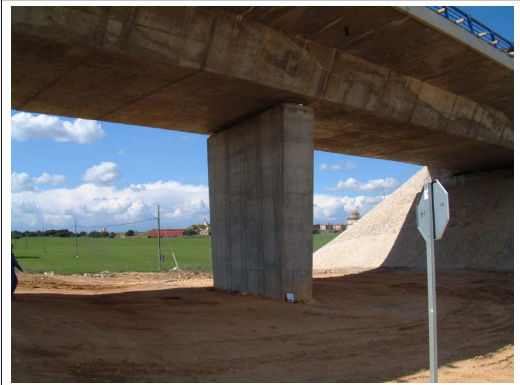
FOTOGRAFÍA Nº 9: VISTA DE PILA 2
