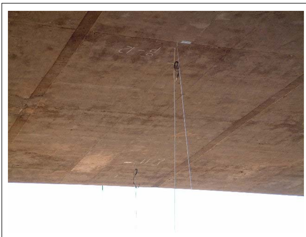
FOTOGRAFÍA 4: Puntos P-11 y P-12 para la medida de flechas a L/4 y puntos G-11 y G-12 para la medida de deformaciones unitarias en vano 1
