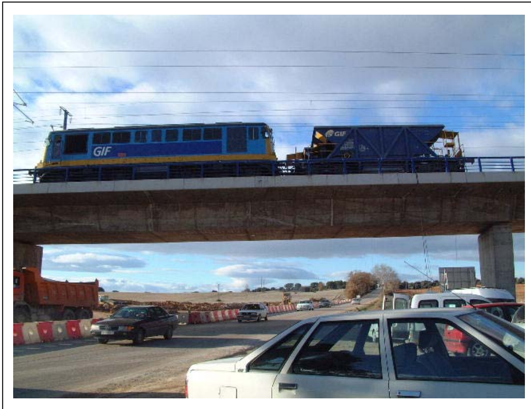
FOTOGRAFÍA 11: Trenes de carga posicionados para la prueba estática 02 en vano 2 (vista lateral derecha)
