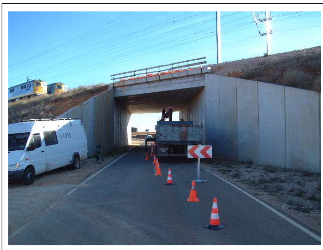
FOTOGRAFÍA 2: Alzado izquierdo y vista del corte realizado en la calzada para la colocación de la instrumentación
