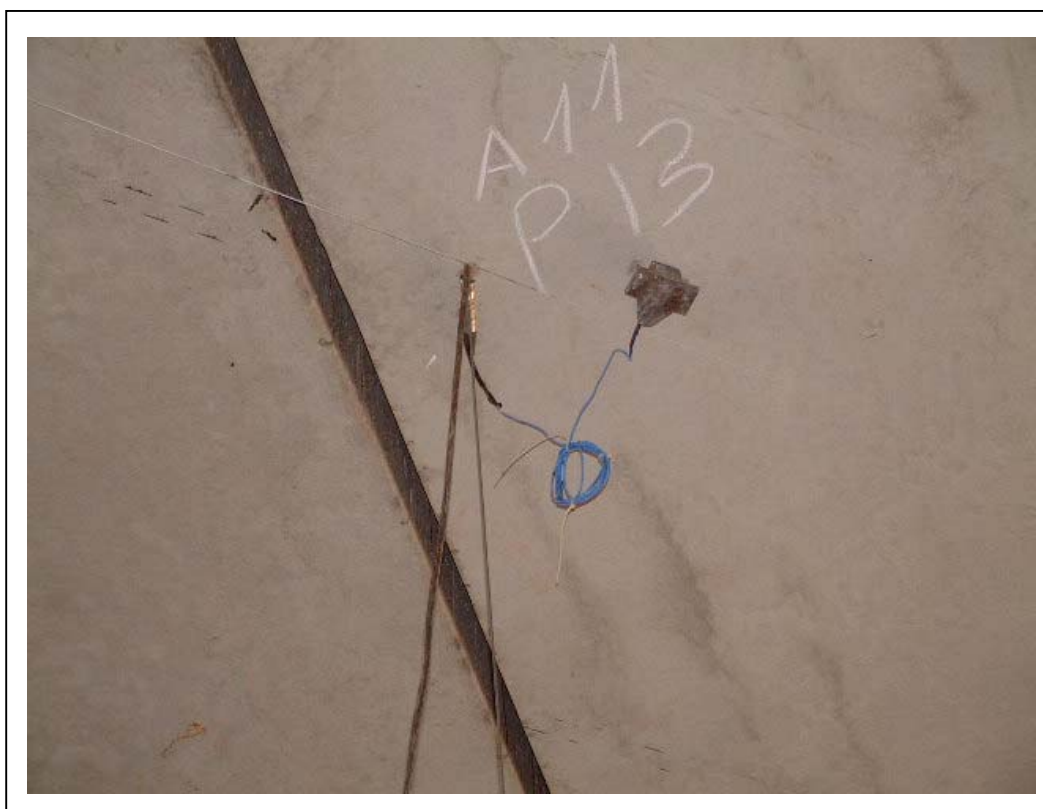
FOTOGRAFÍA 10: Punto P-13 para la medida de desplazamientos verticales en centro de vano y acelerómetro (A-11) para la obtención de la frecuencia de vibración de la estructura
