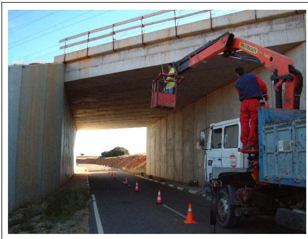
FOTOGRAFÍA 5: Grúa con cesta para colocación de puntos de instrumentación
