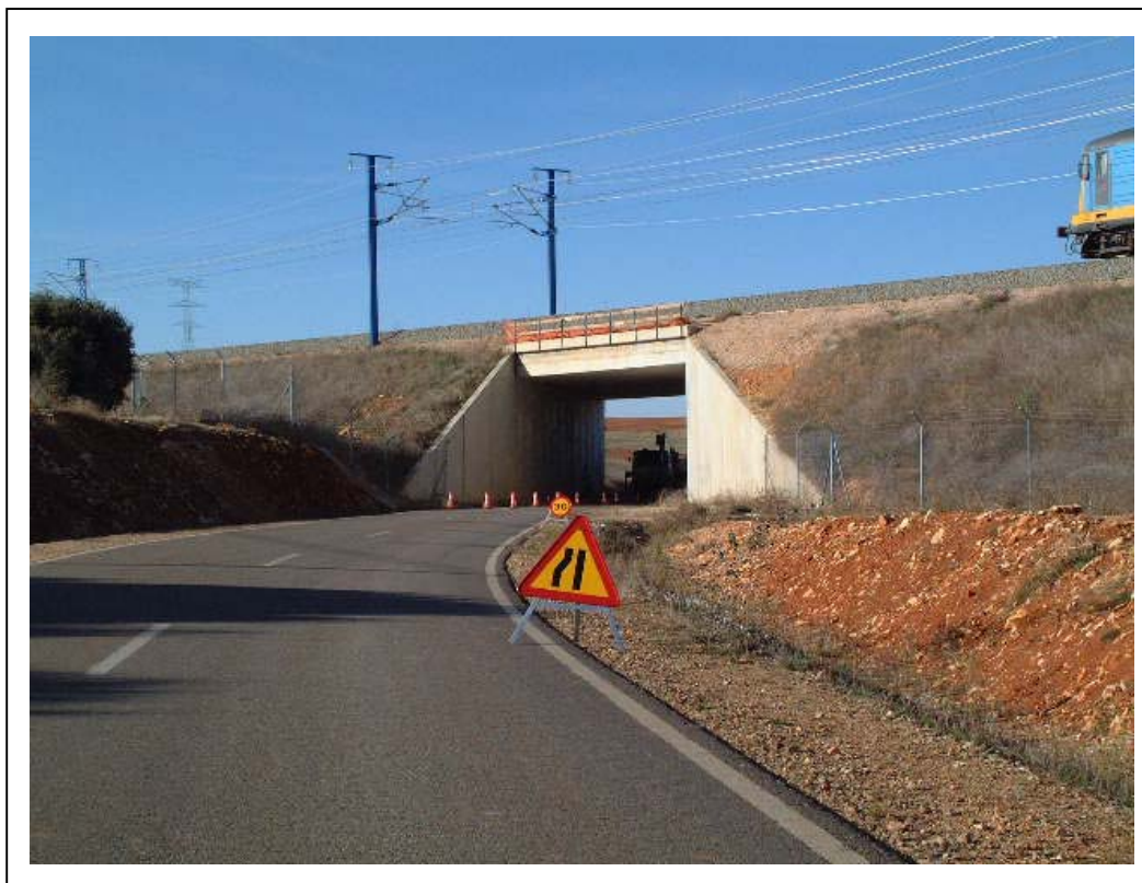
FOTOGRAFÍA 1: Alzado derecho del Paso Inferior
