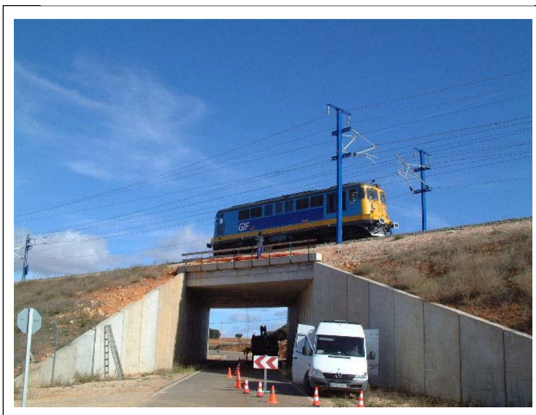
FOTOGRAFÍA 12: Tren tipo de carga circulando por la vía 2 para la realización de uno de los ensayos dinámicos
