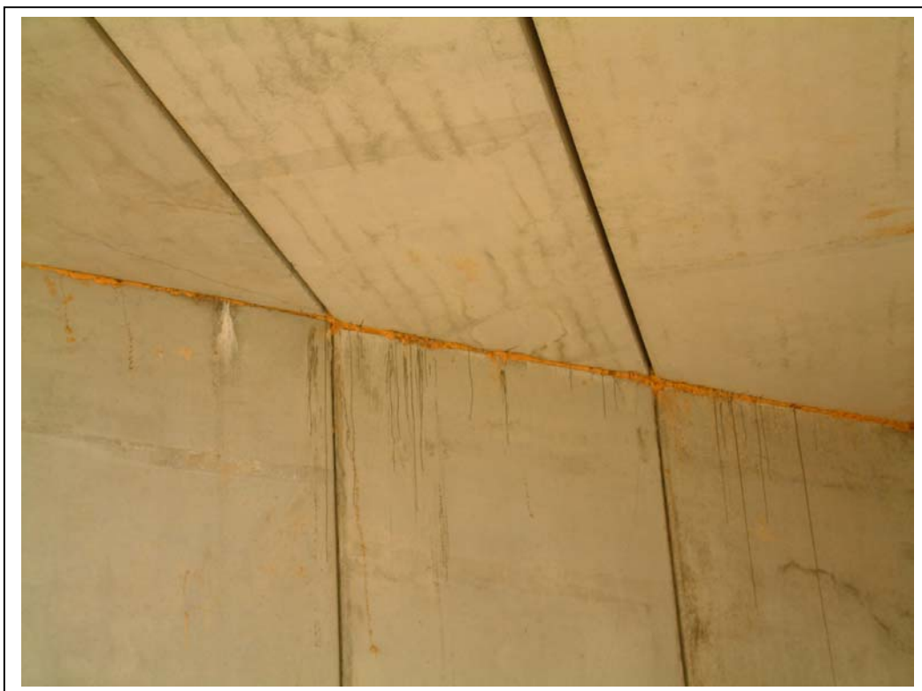
FOTOGRAFÍA Nº 7: DETALLE DE LA UNIÓN HASTIAL-TABLERO CON MATERIAL DE SELLADO DE JUNTA
