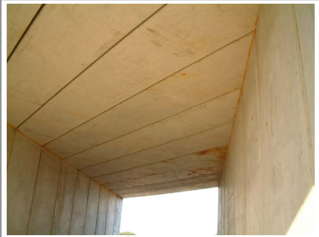
FOTOGRAFÍA Nº 5: VISTA INFERIOR DEL TABLERO DESDE EL LATERAL IZQUIERDO
