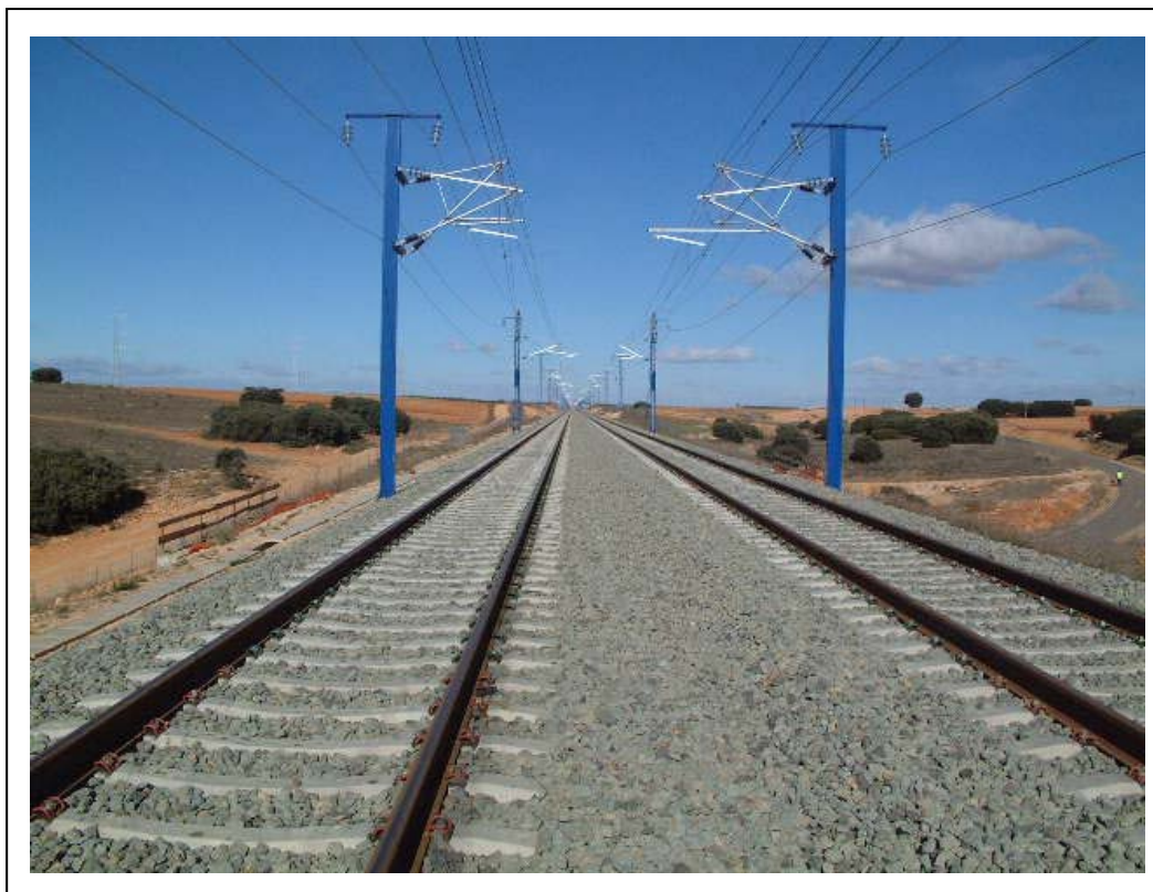
FOTOGRAFÍA 3: Vista superior desde el lado Madrid
