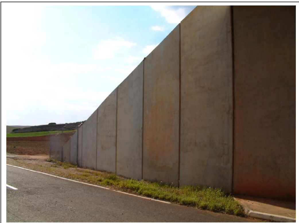
FOTOGRAFÍA Nº 4: VISTA ALETA IZQUIERDA DE ESTRIBO ZARAGOZA
