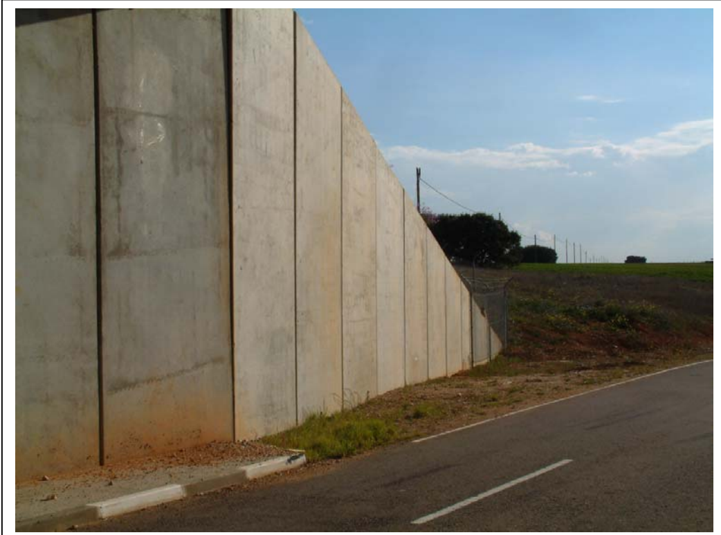
FOTOGRAFÍA Nº 3: VISTA ALETA IZQUIERDA DE ESTRIBO MADRID
