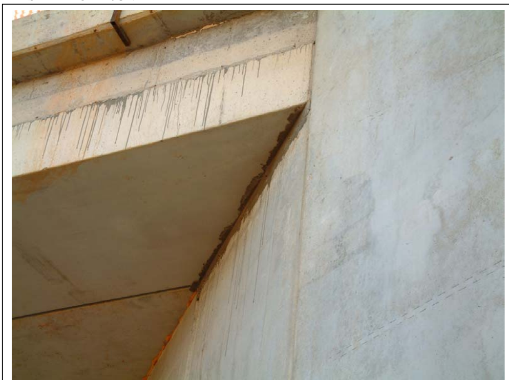
FOTOGRAFÍA Nº 8: VISTA LATERAL DE LA UNIÓN HASTIAL-TABLERO
