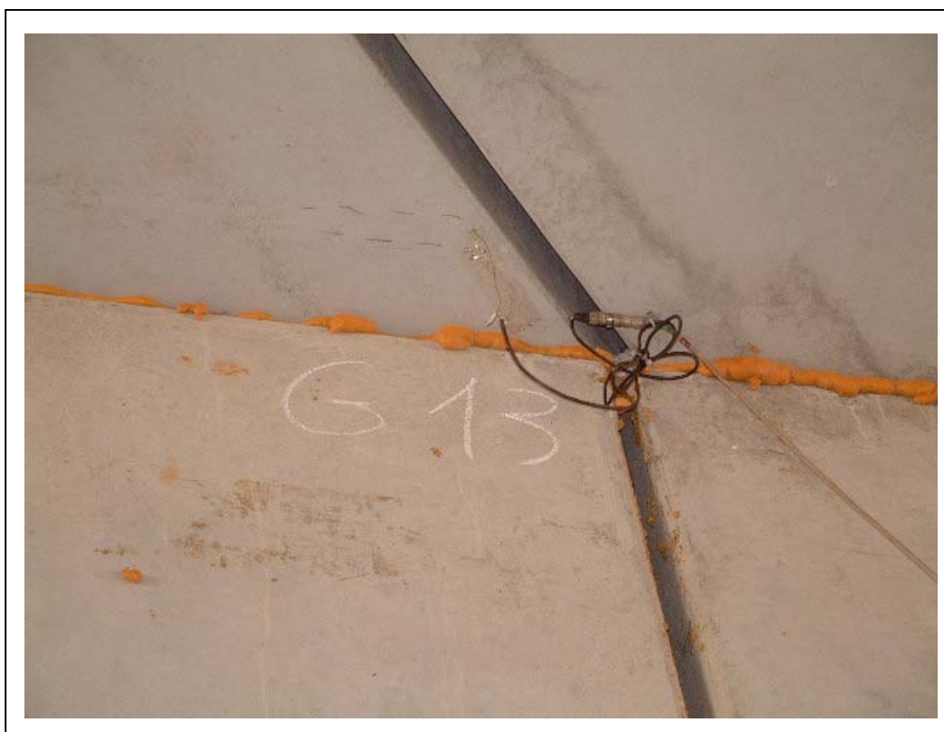
FOTOGRAFÍA 8: Punto G-13 para la medida de deformaciones unitarias colocado junto al estribo Madrid (bajo vía 1)
