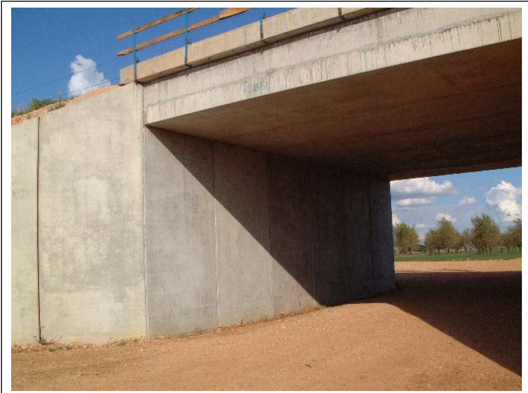
FOTOGRAFÍA Nº 3: VISTA LATERAL IZQUIERDA DEL ESTRIBO ZARAGOZA
