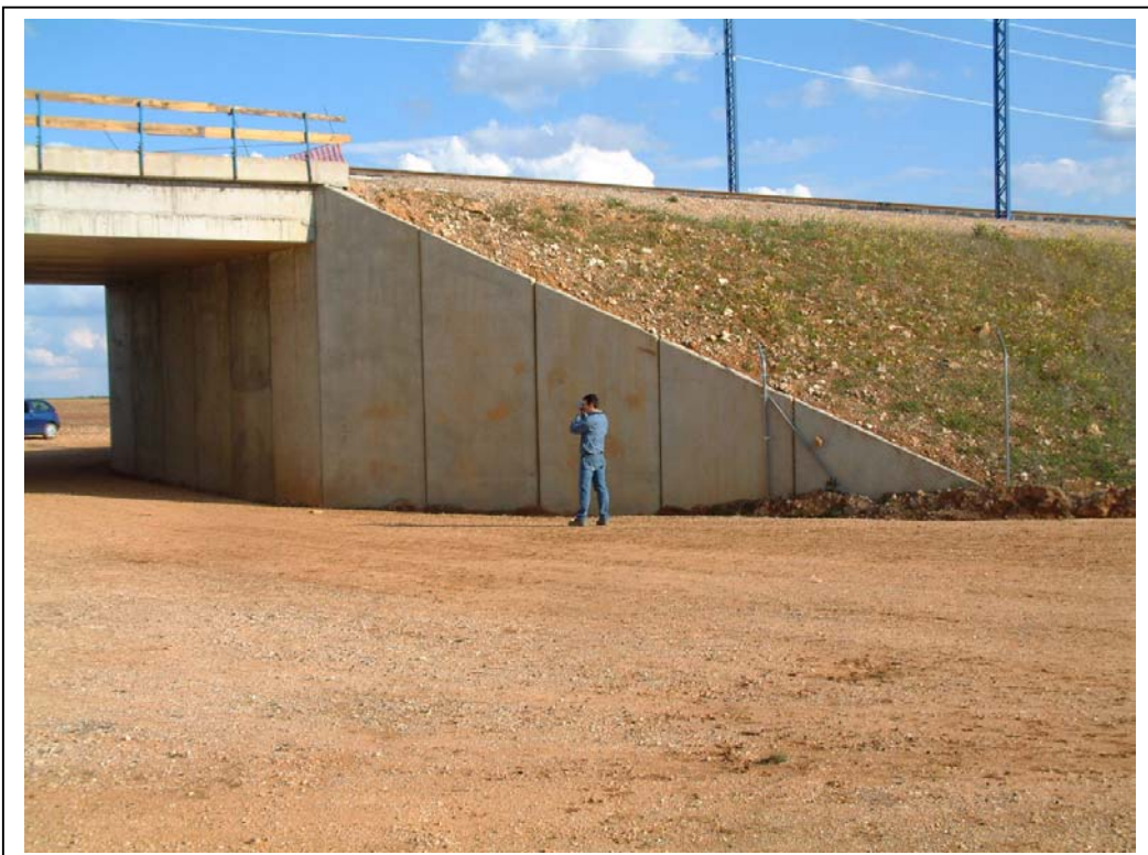
FOTOGRAFÍA Nº 4: ALETA IZQUIERDA DE ESTRIBO MADRID
