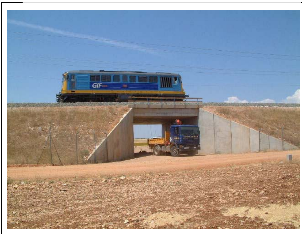
FOTOGRAFÍA 10: Trenes de carga posicionados para la prueba estática (vista lateral izquierda)
