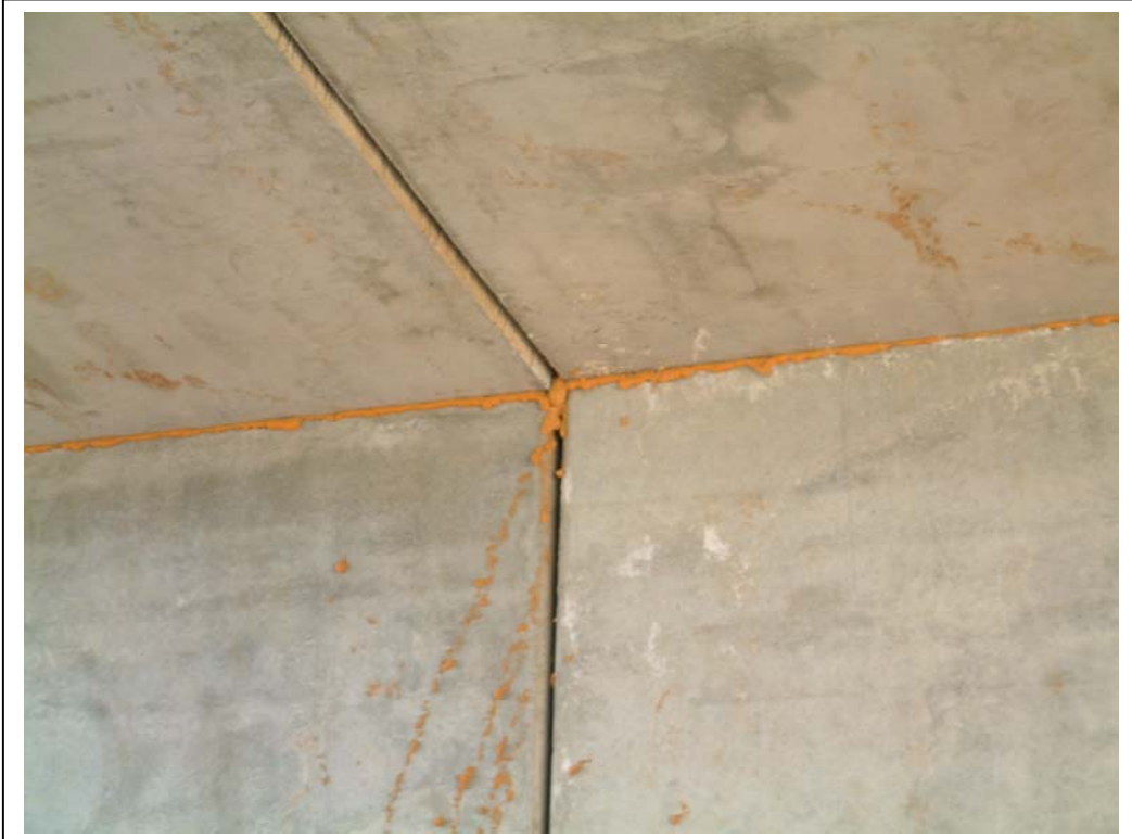
FOTOGRAFÍA Nº 5: JUNTA DE PARAMENTO VERTICAL CON TABLERO
