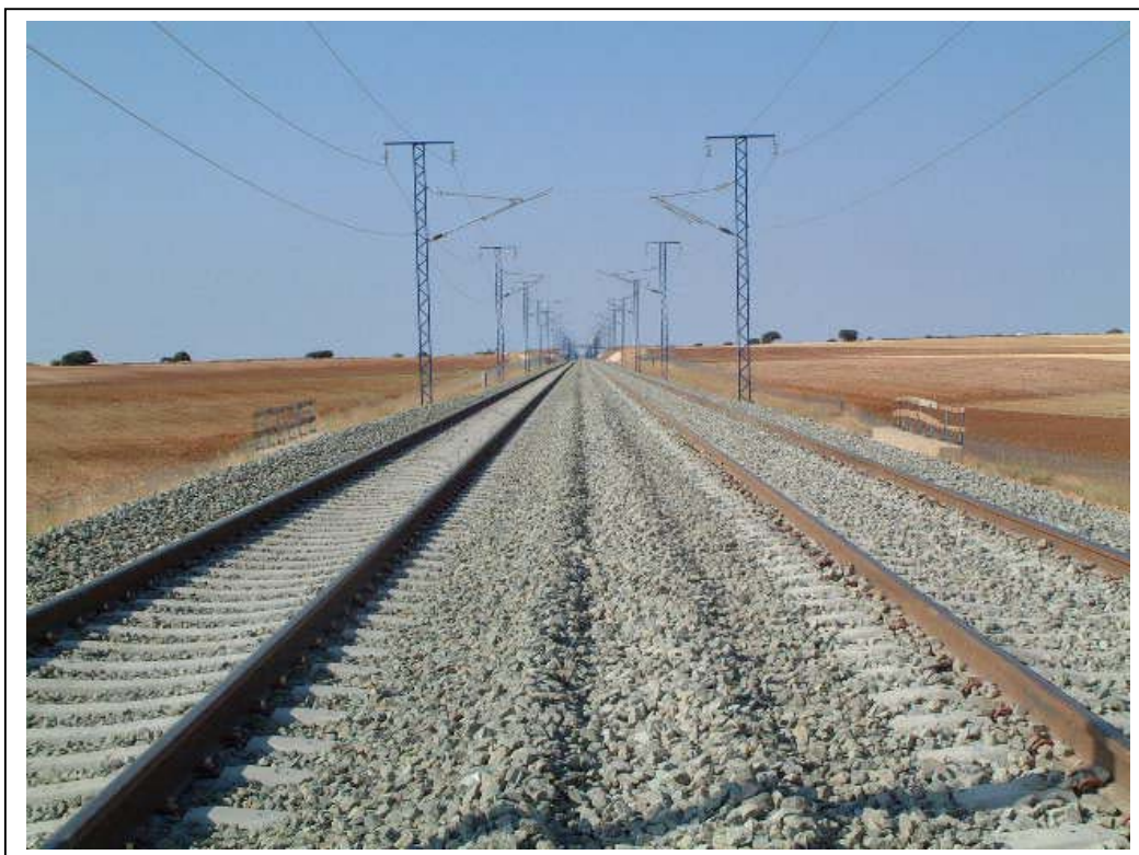
FOTOGRAFÍA Nº 9: VISTA SUPERIOR DEL PASO INFERIOR DESDE EL ESTRIBO ZARAGOZA
