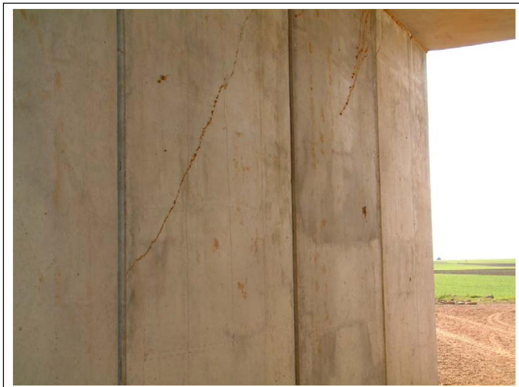
FOTOGRAFÍA Nº 7: JUNTAS ENTRE MARCOS VERTICALES DE PARAMENTOS DE ESTRIBOS
