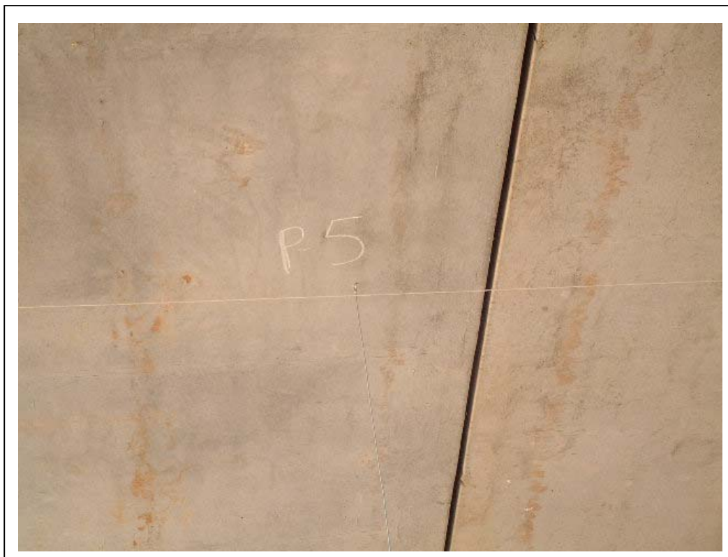
FOTOGRAFÍA 5: Transductor de desplazamiento colocado a 2 metros del carril exterior de la vía 2
