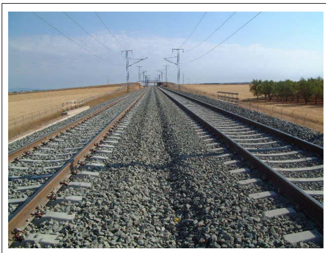
FOTOGRAFÍA 2: Vista superior del Paso Inferior desde el estribo Madrid
