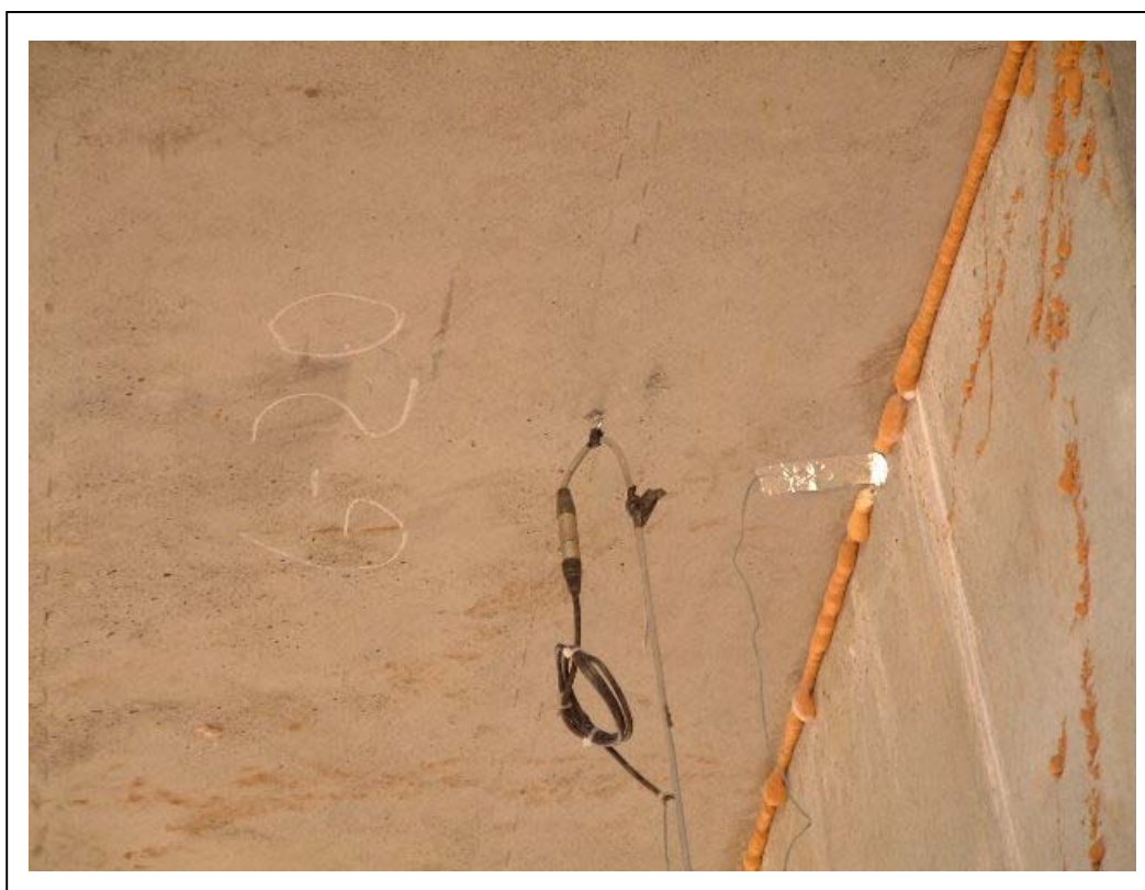
FOTOGRAFÍA 8: Galga instrumentada junto al hastial Madrid
