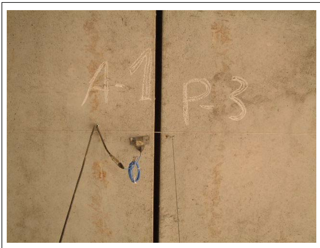
FOTOGRAFÍA 7: Detalle de flecha y acelerómetro instrumentados en el punto medio de la sección central del tablero
