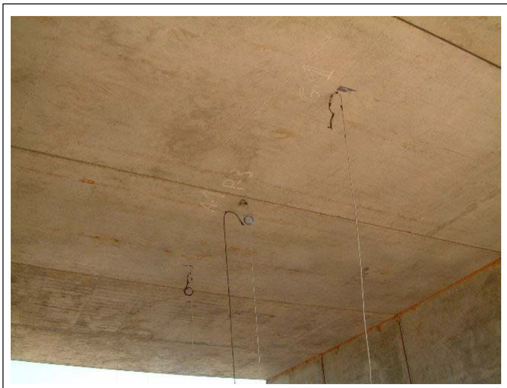
FOTOGRAFÍA 5: Galgas, flechas y acelerómetro instrumentados a mitad de la luz del tablero del Paso Inferior
