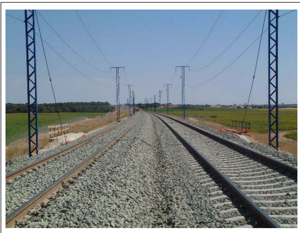
FOTOGRAFÍA 3: Vista superior del Paso Inferior desde el estribo Madrid
