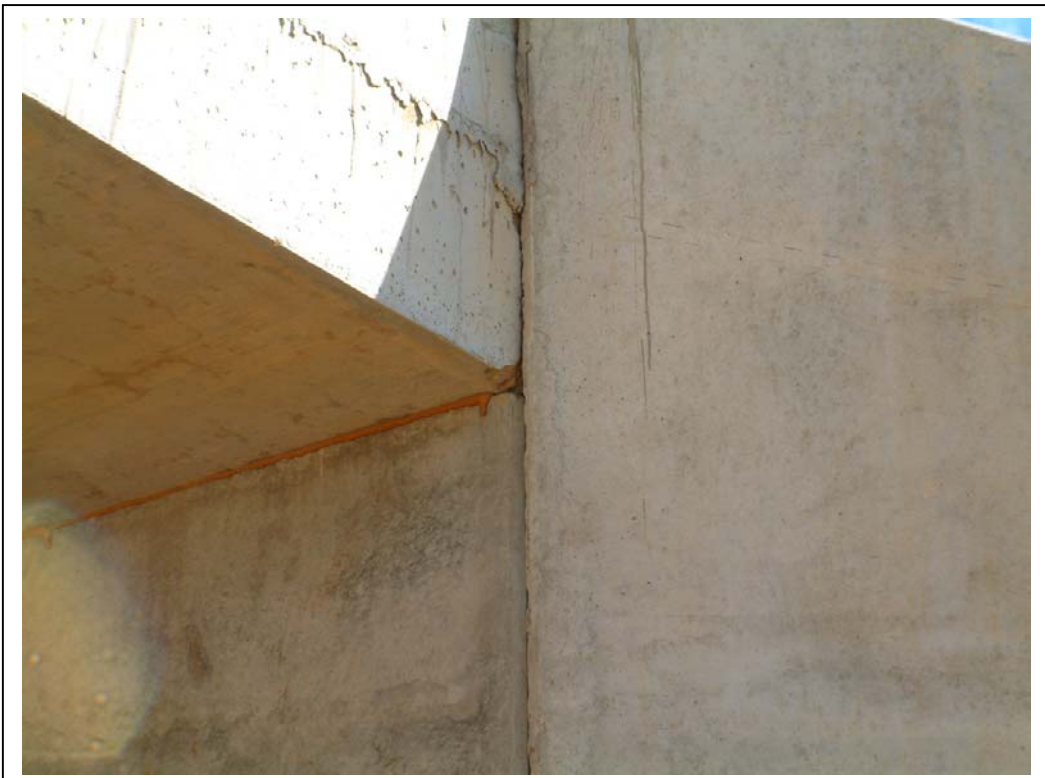
FOTOGRAFÍA N° 6: VISTA LATERAL DE UNIÓN DE PARAMENTO VERTICAL, TABLERO Y ALETA
