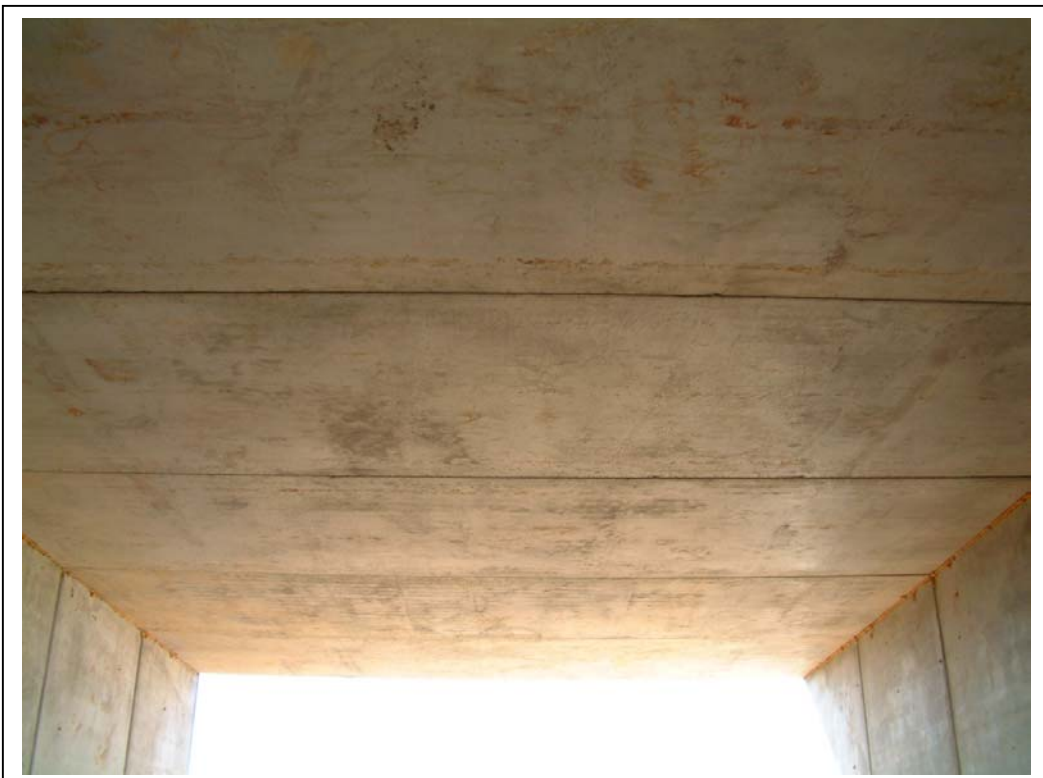
FOTOGRAFÍA Nº 4: VISTA INFERIOR DEL TABLERO
