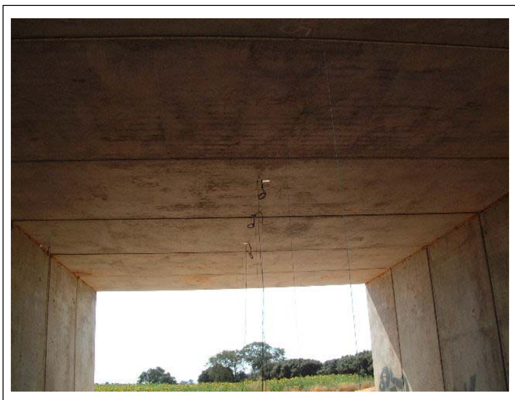
FOTOGRAFÍA 6: Vista desde el lateral izquierdo de la zona central del tablero con los puntos de medida colocados
