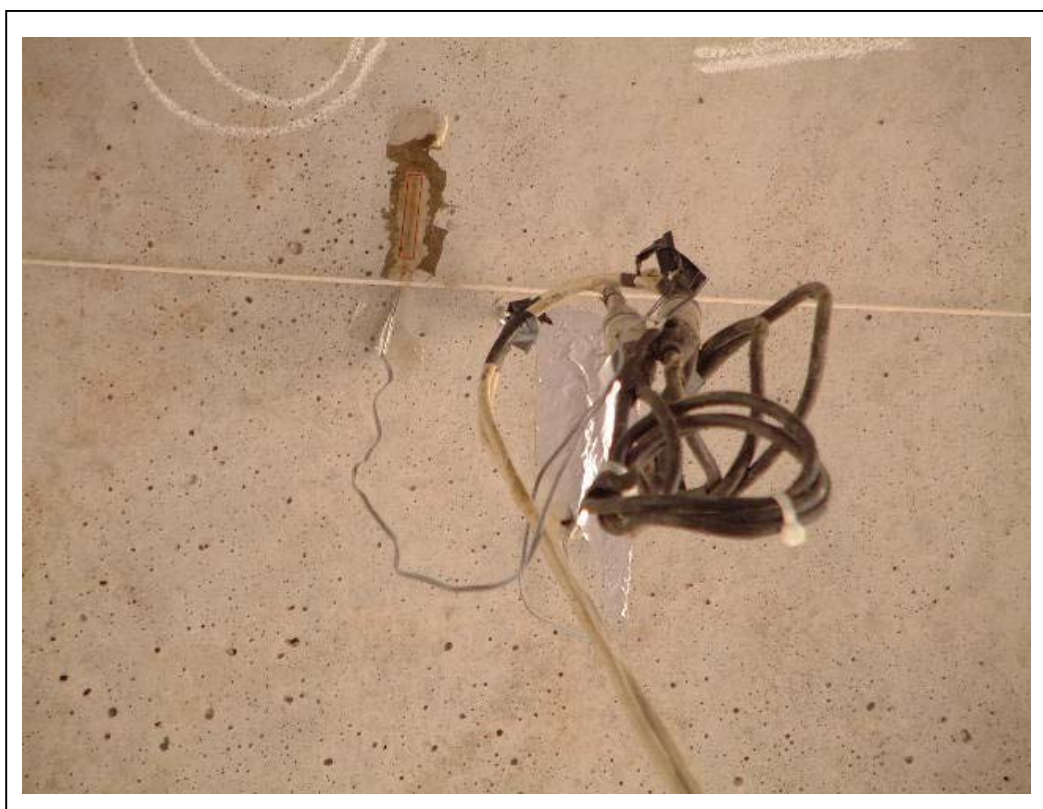
FOTOGRAFÍA 8: Detalle de punto de medida de deformaciones unitarias en la sección central del tablero
