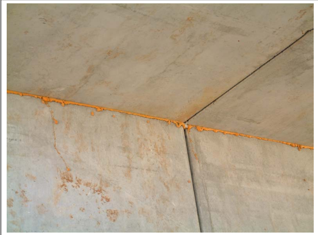
FOTOGRAFÍA N° 5: JUNTA ENTRE PARAMENTO VERTICAL Y LOSA DE TABLERO
