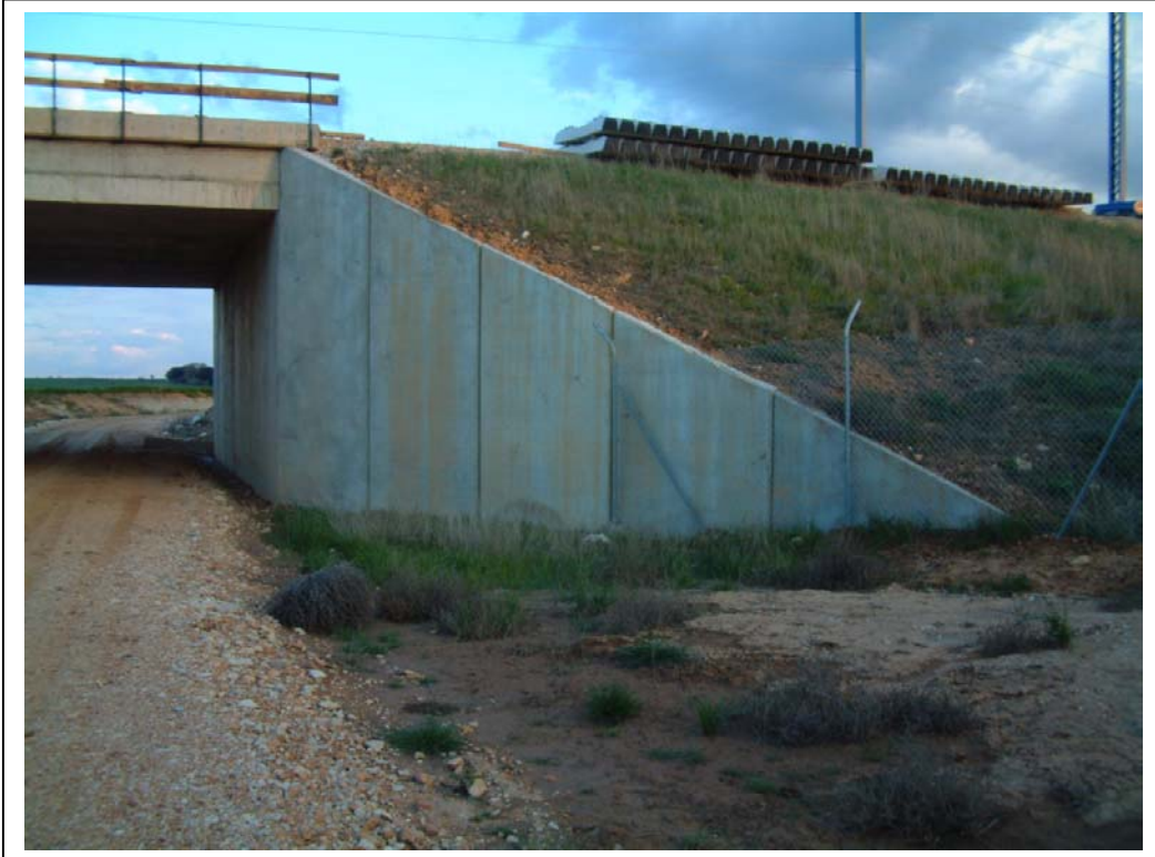
FOTOGRAFÍA N° 3: VISTA DE ALETA DERECHA DESDE ESTRIBO MADRID
