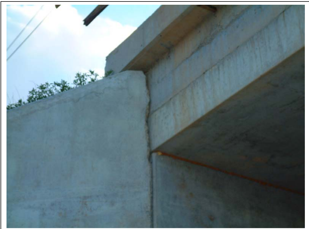
FOTOGRAFÍA Nº 6: VISTA LATERAL DE UNIÓN DE PARAMENTO VERTICAL TABLERO Y ALETA
