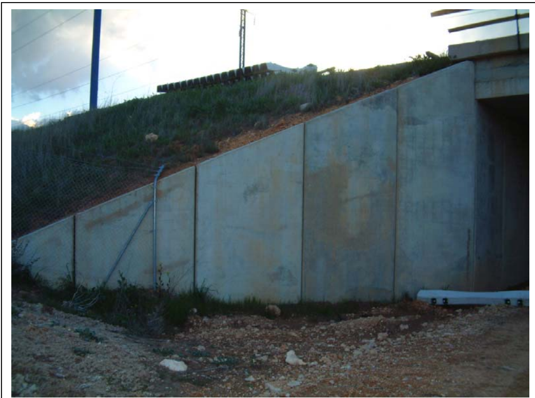
FOTOGRAFÍA N° 4: VISTA DE ALETA DERECHA DE ESTRIBO MADRID
