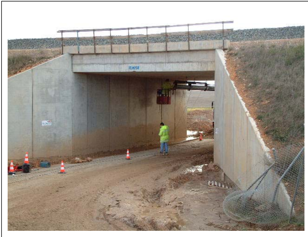
FOTOGRAFÍA 1: Alzado izquierdo del Paso Inferior
