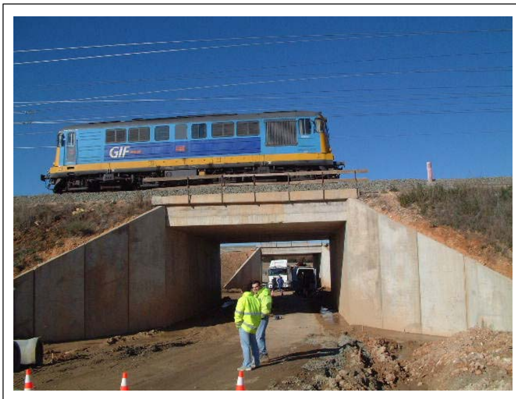
FOTOGRAFÍA 9: Tren de carga tipo circulando por vía 1 para la realización de uno de los ensayos dinámicos
