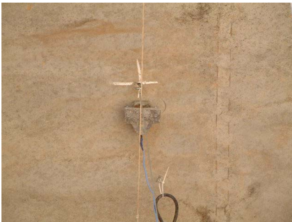
FOTOGRAFÍA 7: Acelerómetro para la medida de la frecuencia de vibración de la estructura y flecha en centro de vano
