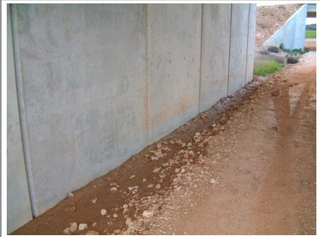
FOTOGRAFÍA Nº 7: CANAL INFERIOR JUNTO A ESTRIBO SIN ELEMENTOS DE FÁBRICA.
