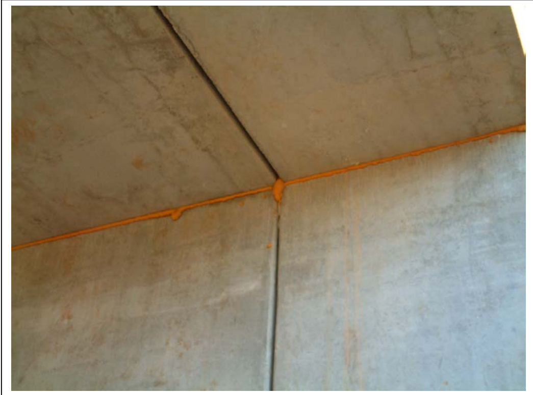
FOTOGRAFÍA Nº 5: JUNTA ENTRE PARAMENTO VERTICAL Y LOSA DE TABLERO
