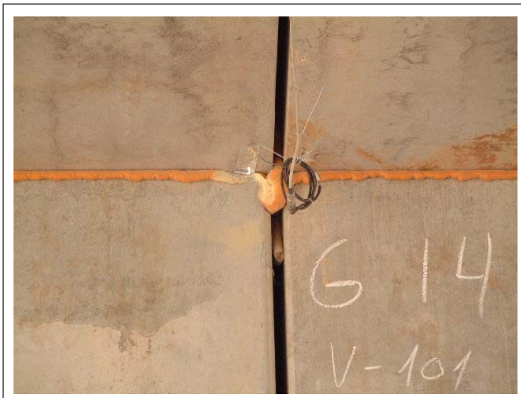
FOTOGRAFÍA 5: Punto G-14 para la medida de deformaciones unitarias junto al hastial Zaragoza
