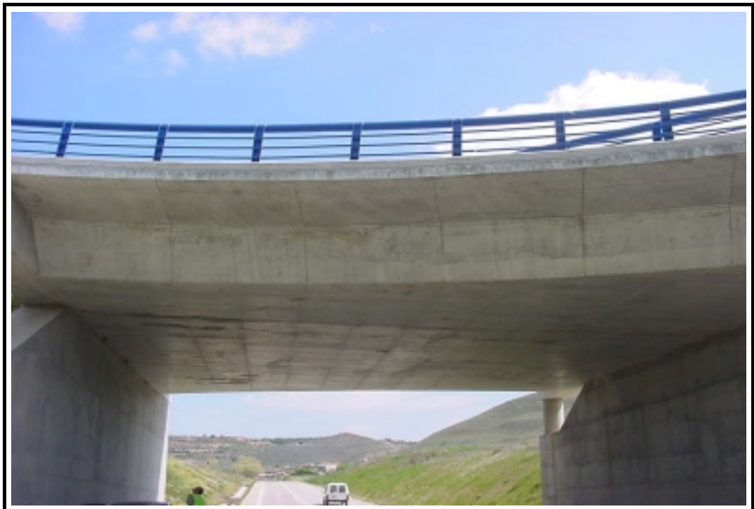
Foto 4: Vista inferior de la estructura
