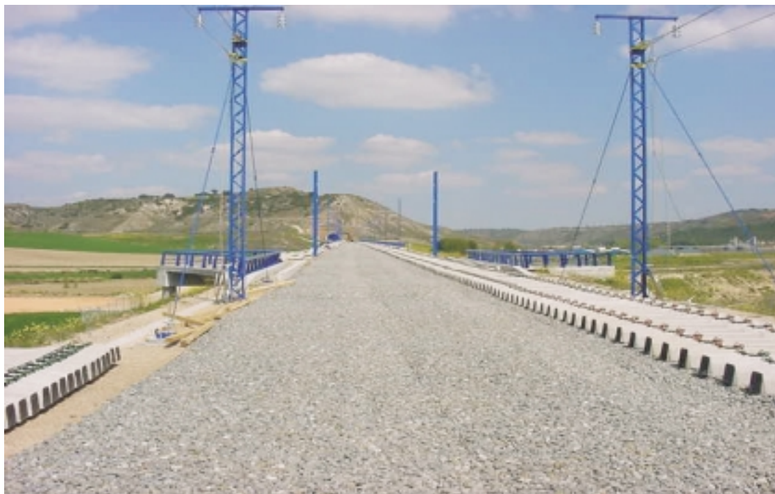
Foto 3: Vista superior desde entrada
