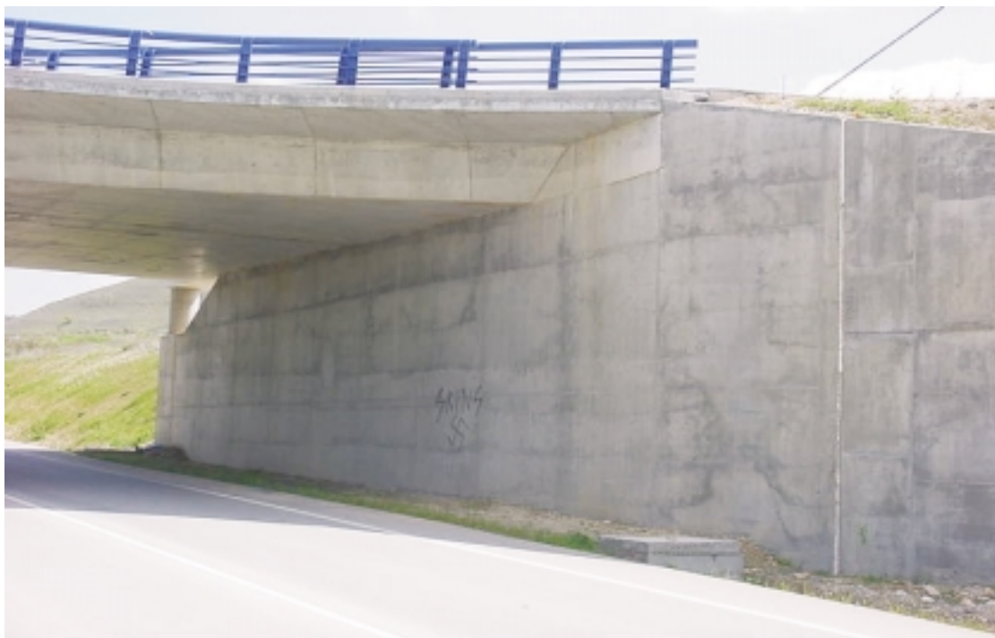
Foto 5: Estribo de entrada
