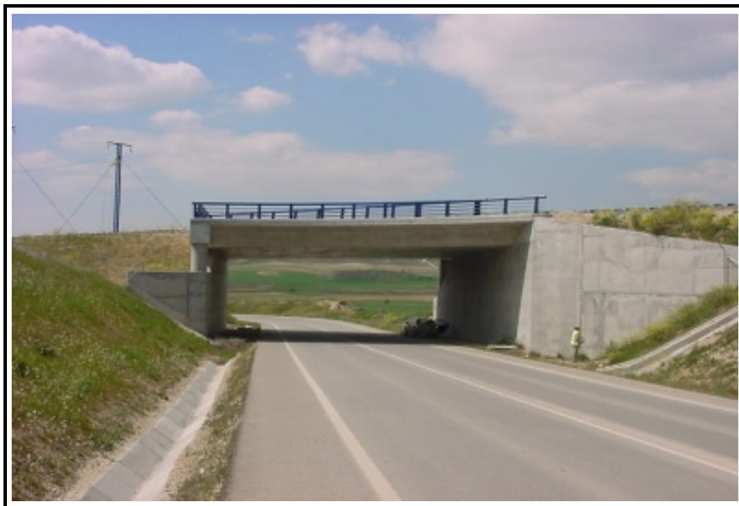
Foto 1: Vista general de la estructura
