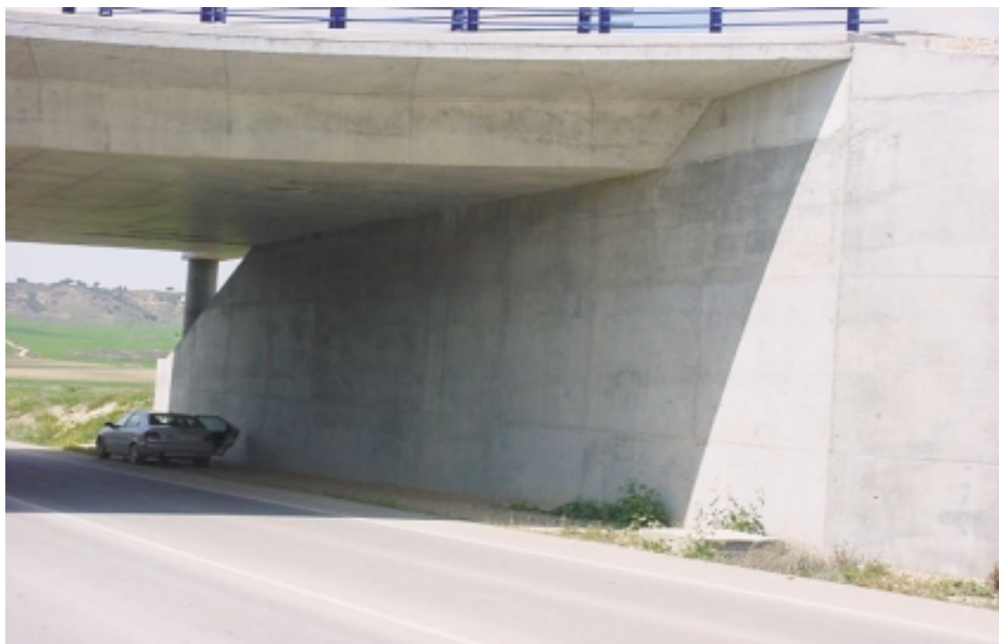
Foto 6: Estribo de salida
