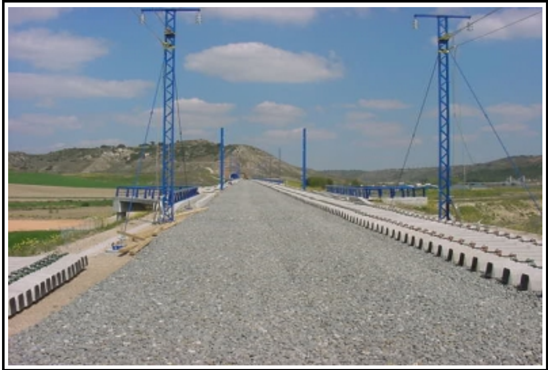
Foto 3: Vista superior de la estructura
