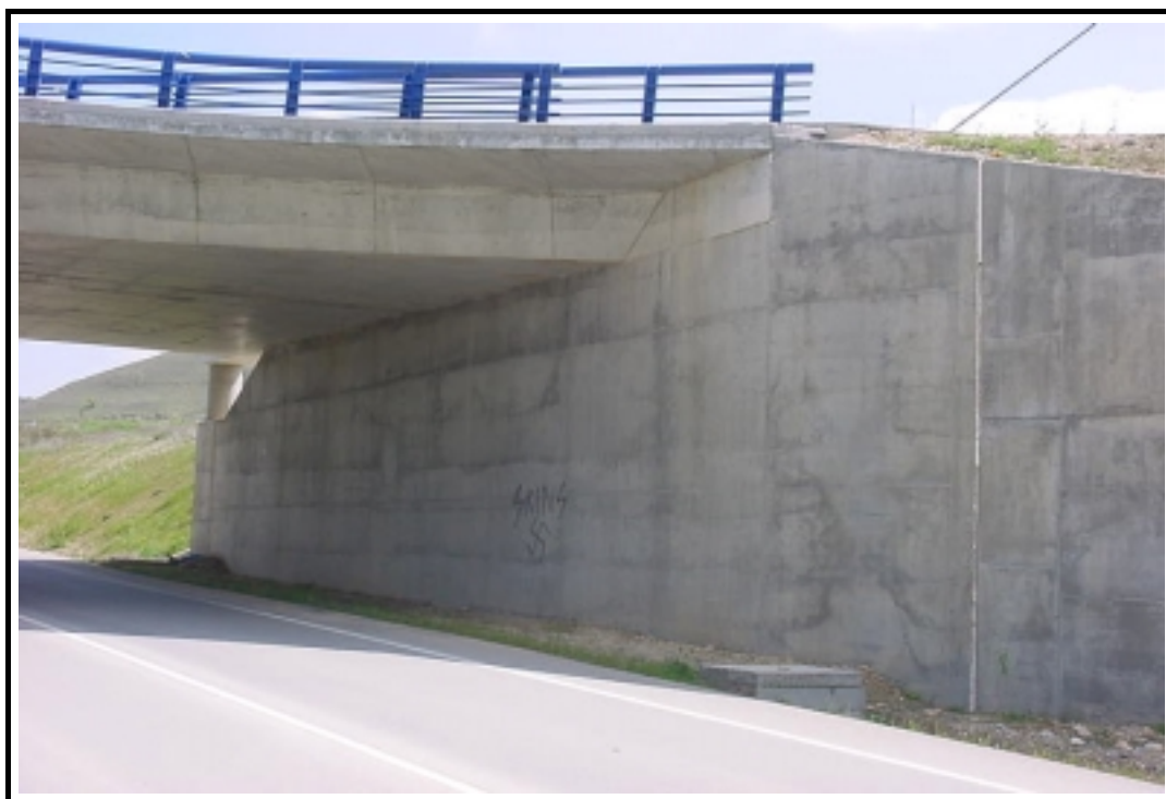
Foto 2: Estribo de entrada
