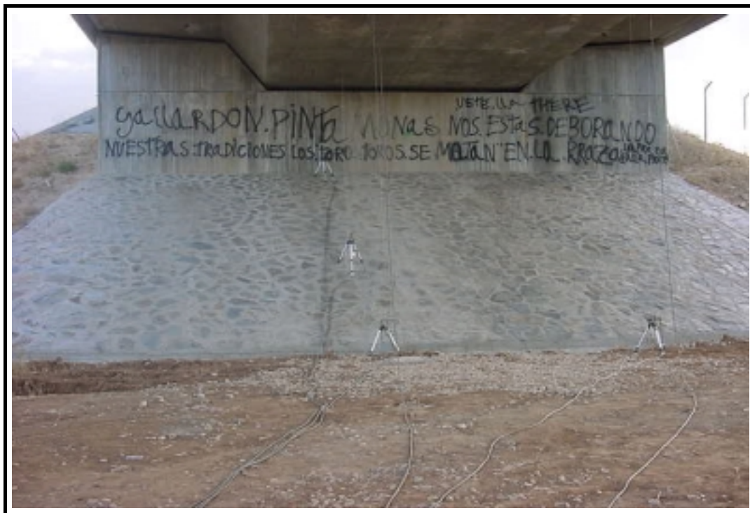
Foto 5: Línea de ménsulas para la medida de desplazamientos
