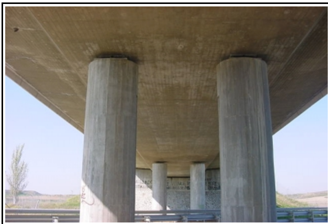
Foto 4: Vista inferior de la estructura
