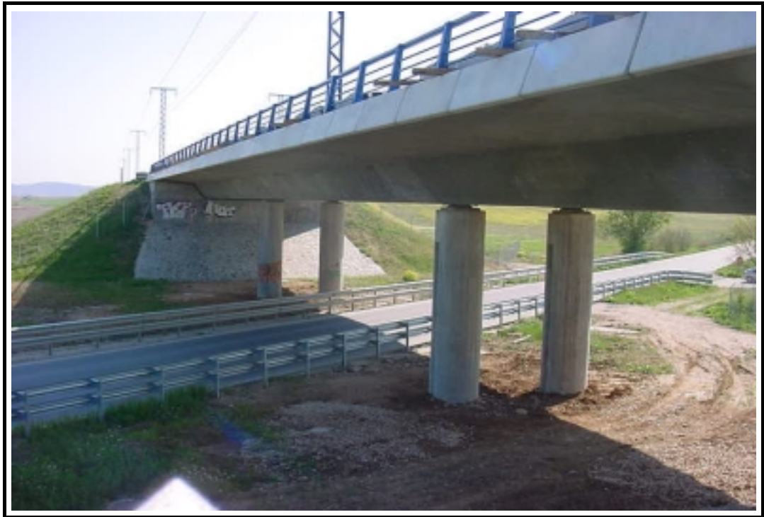
Foto 1: Vista general de la estructura
