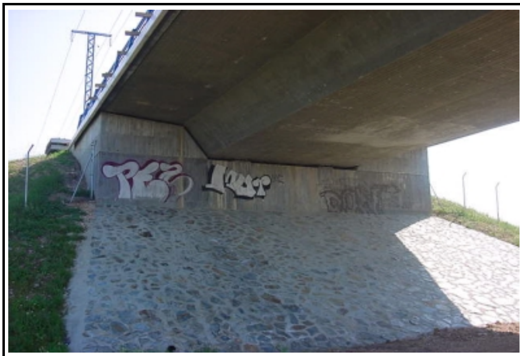
Foto 3: Vista general del estribo de entrada
