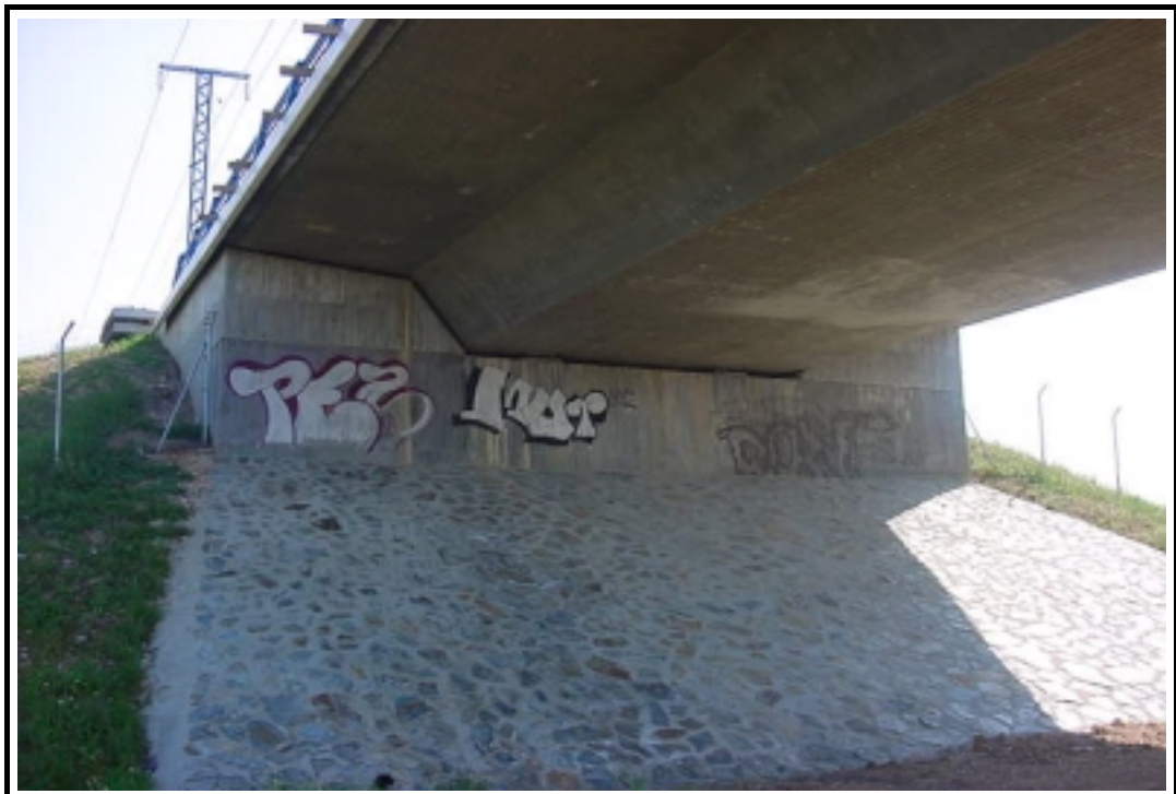
Foto 4: Estribo de salida
