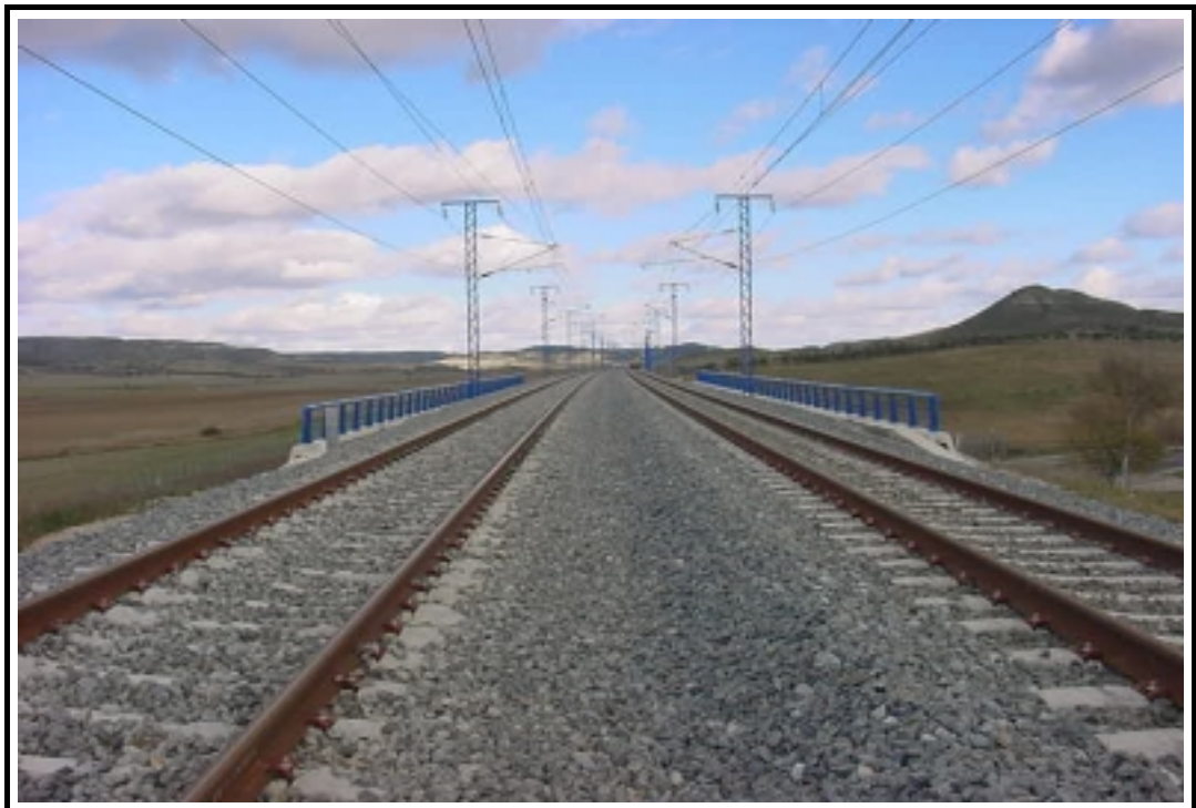
Foto 2: Vista superior de la estructura
