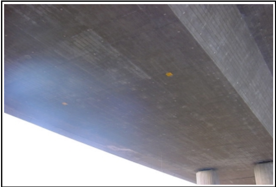
Foto 7: Pegatinas para medida de desplazamientos con dispositivo láser
