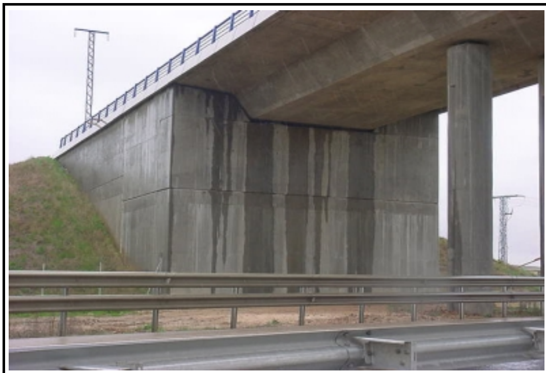
Foto 3: Vista general del estribo de salida
