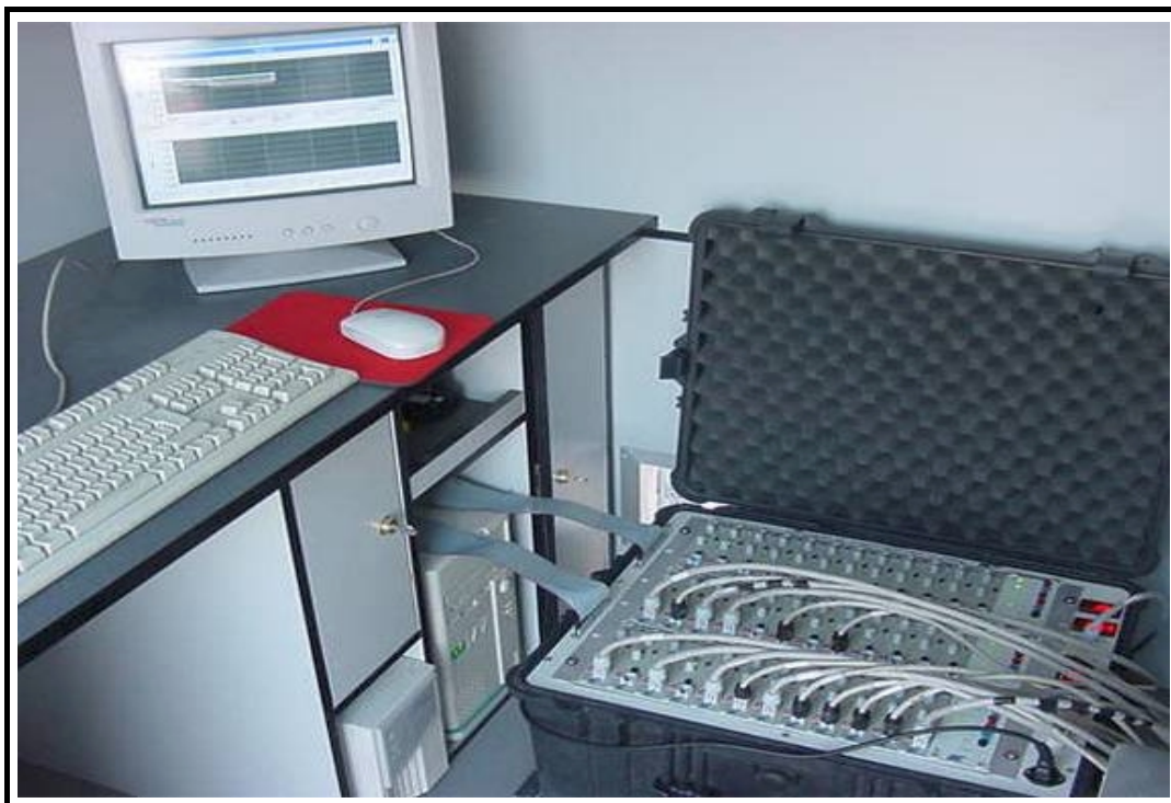
Foto 9: Vista general de acondicionadores de señal y equipo de adquisición
