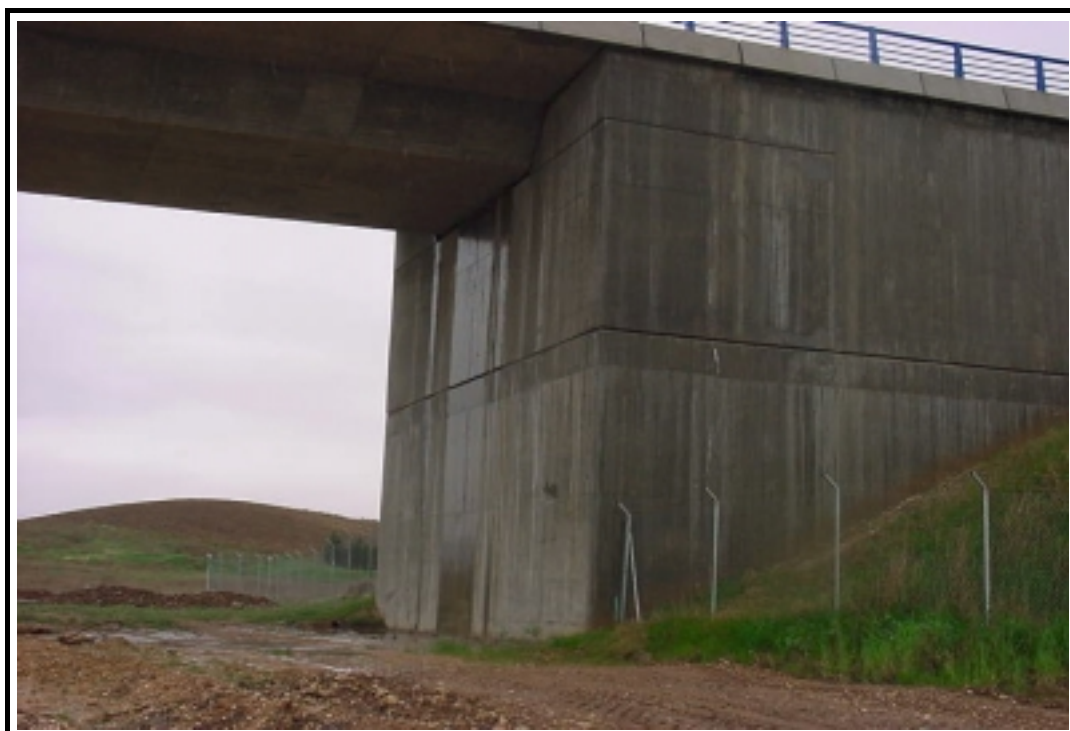
Foto 2: Vista general del estribo de entrada
