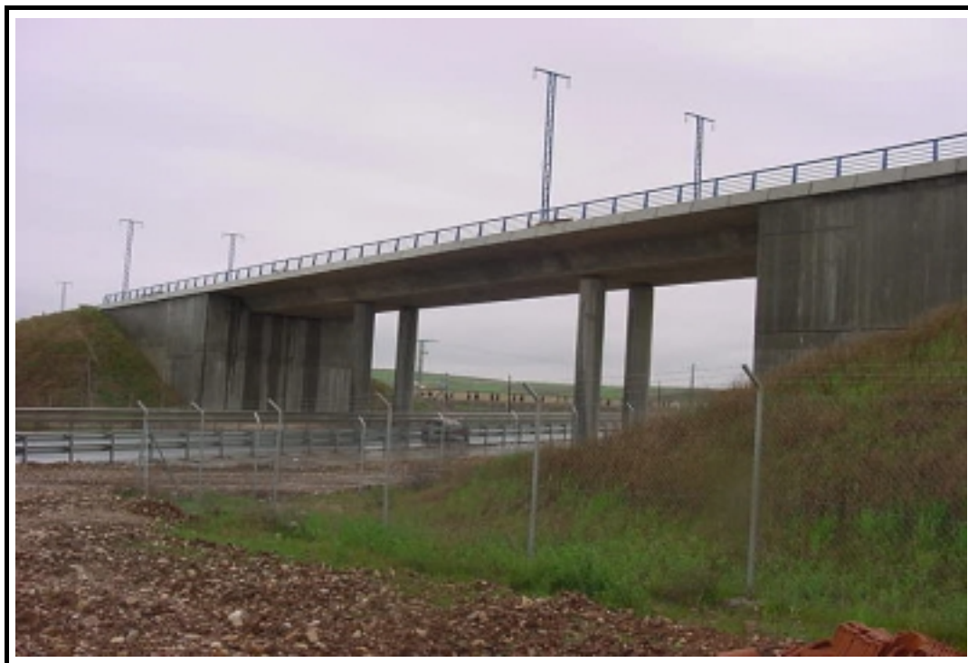
Foto 1: Vista general de la estructura
