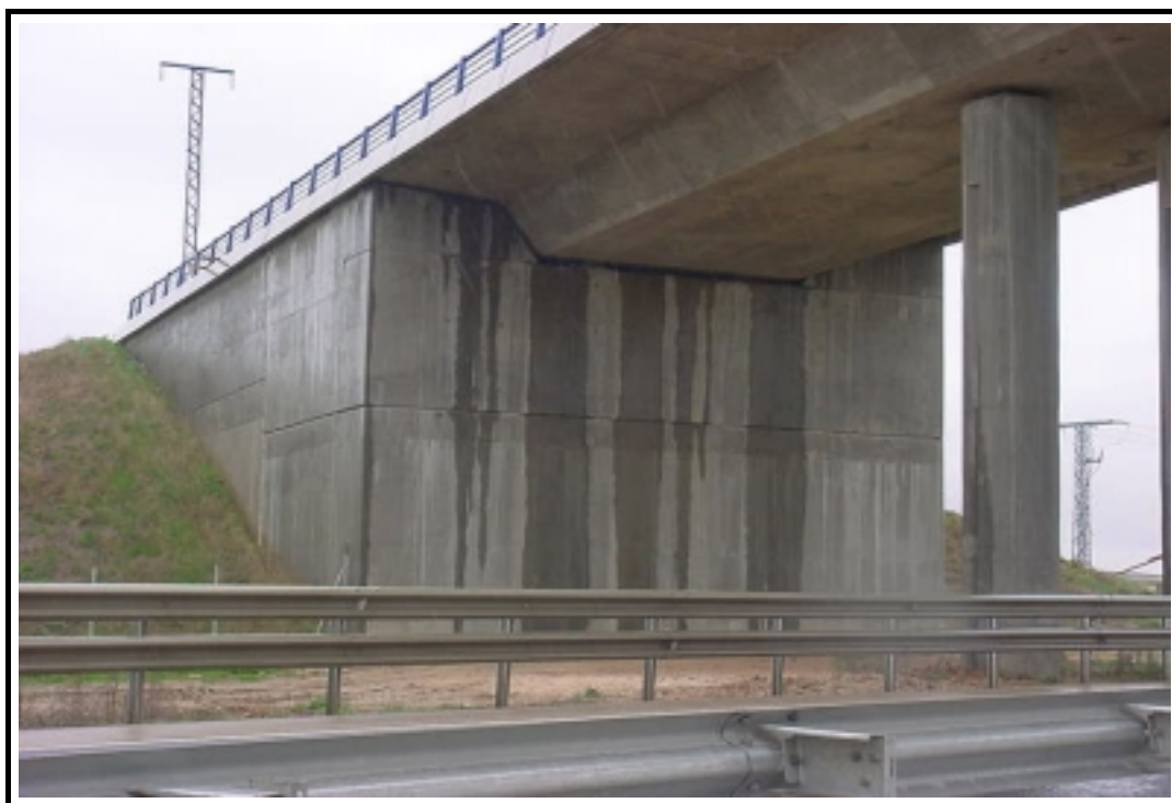
Foto 6: Estribo de salida
