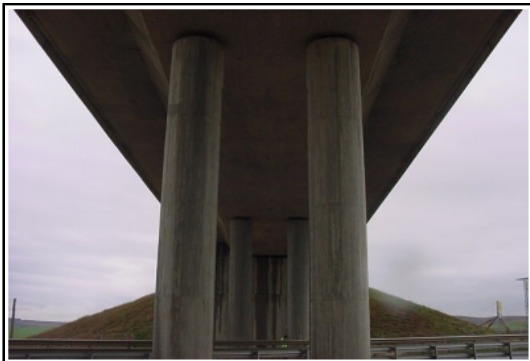
Foto 4: Vista inferior de la estructura
