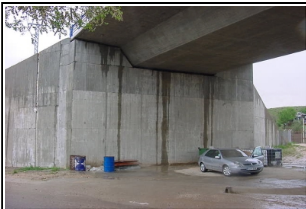
Foto 4: Vista general del estribo de salida
