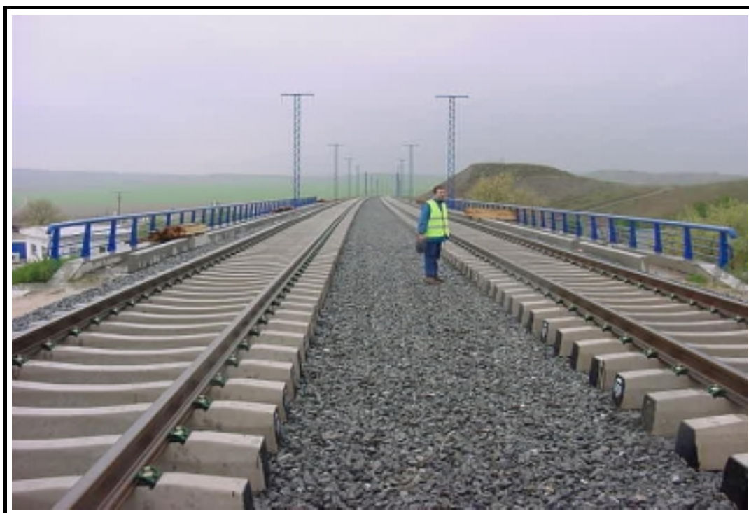
Foto 3: Vista superior desde entrada
