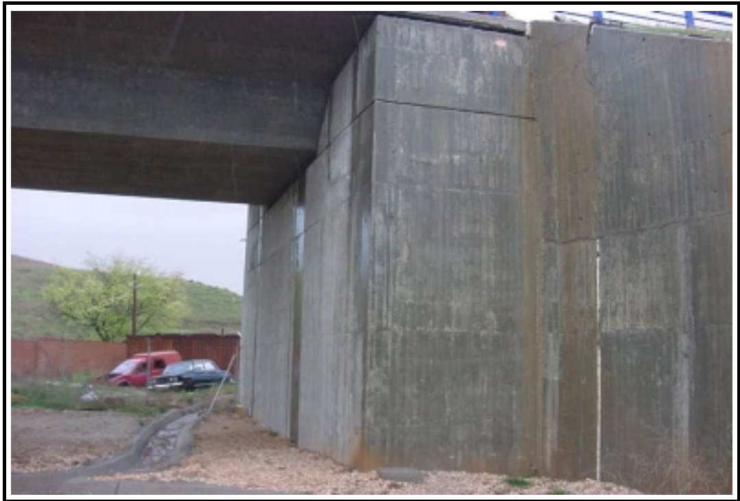
Foto 5: Estribo de entrada
