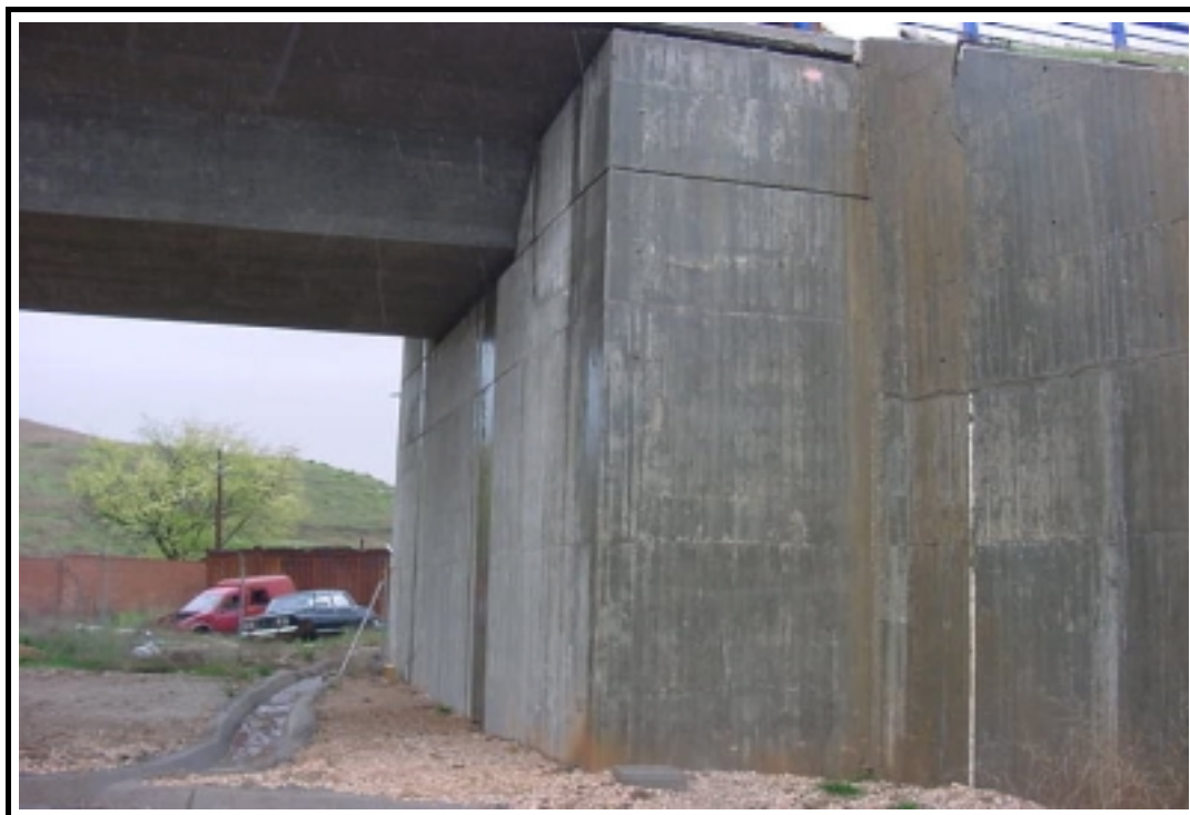
Foto 3: Vista general del estribo de entrada
