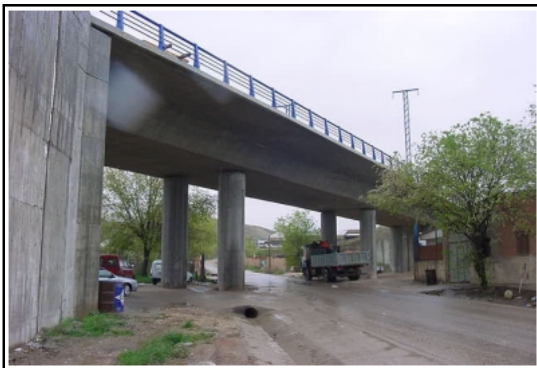
Foto 2: Vista lateral de la estructura
