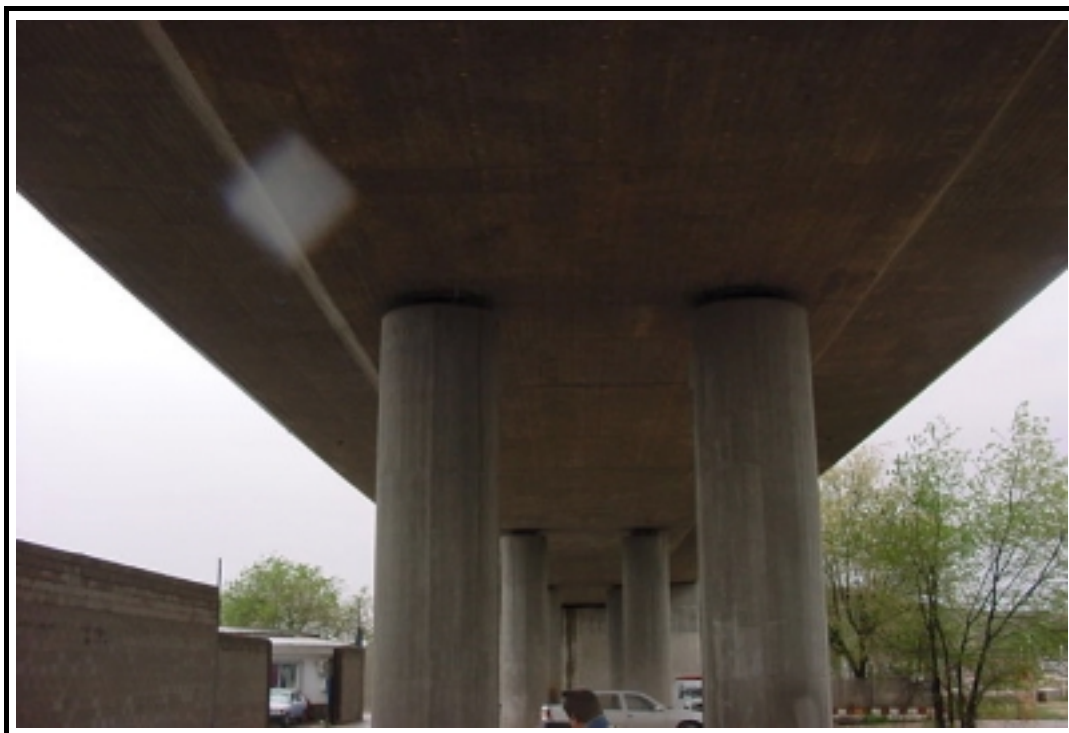
Foto 5: Vista inferior de la estructura
