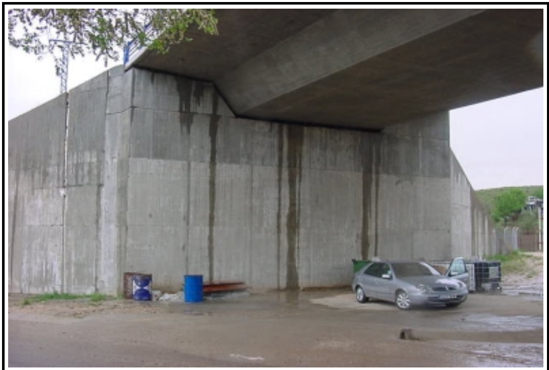
Foto 6: Estribo de salida
