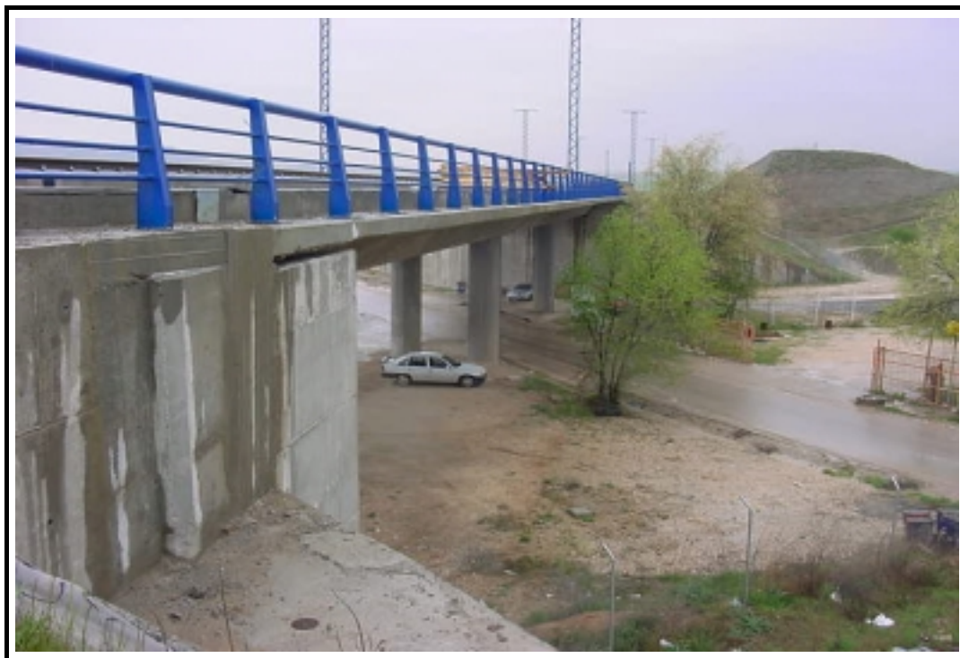
Foto 1: Vista general de la estructura
