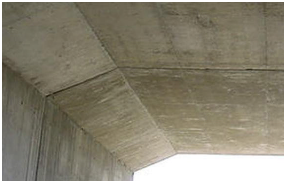
Foto6: Detalle de junta longitudinal
