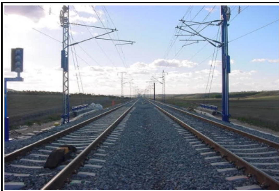
Foto 2: Vista superior de la estructura
