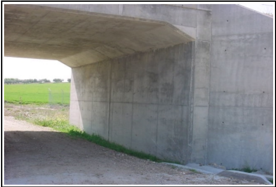
Foto 3: Vista general de estribo de entrada
