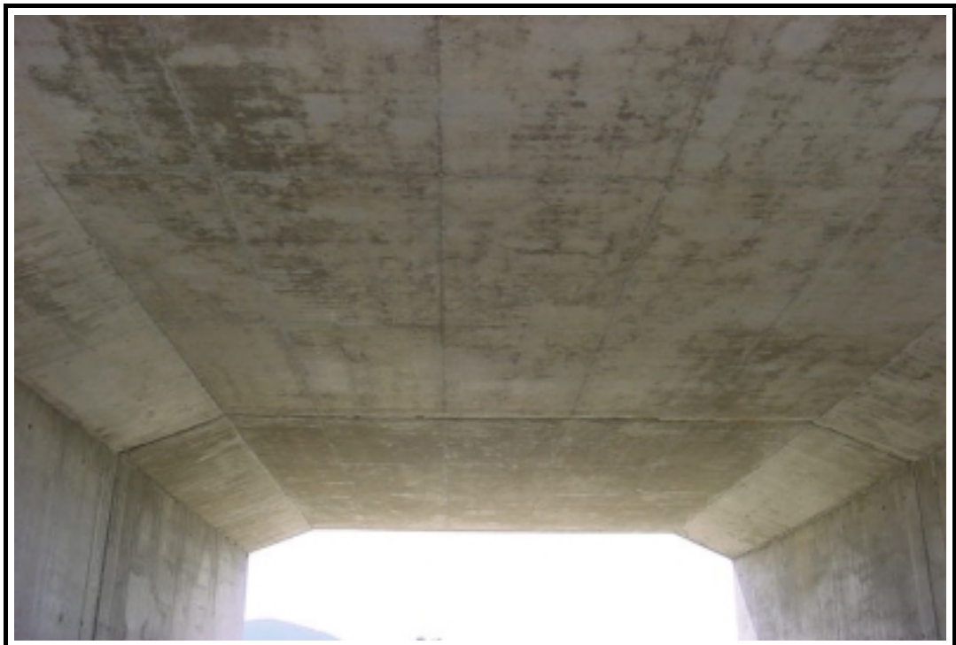
Foto 4: Vista inferior de la estructura
