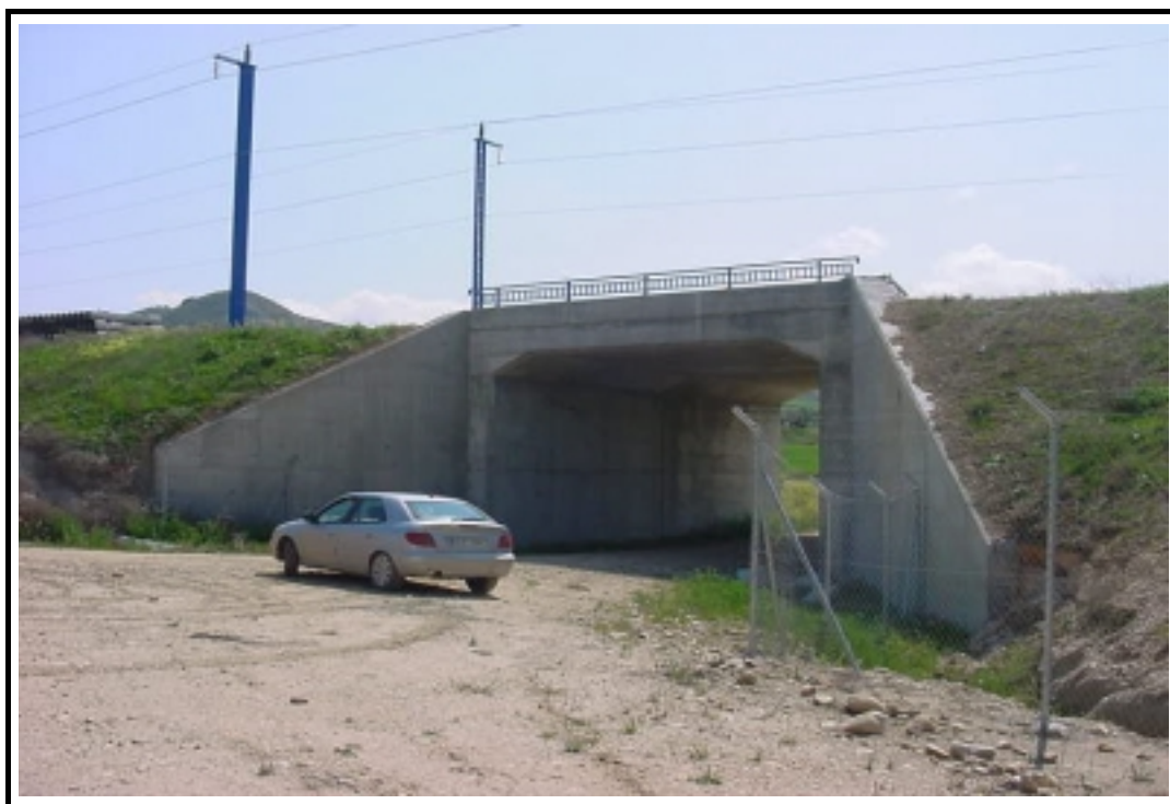
Foto 1: Vista general de la estructura
