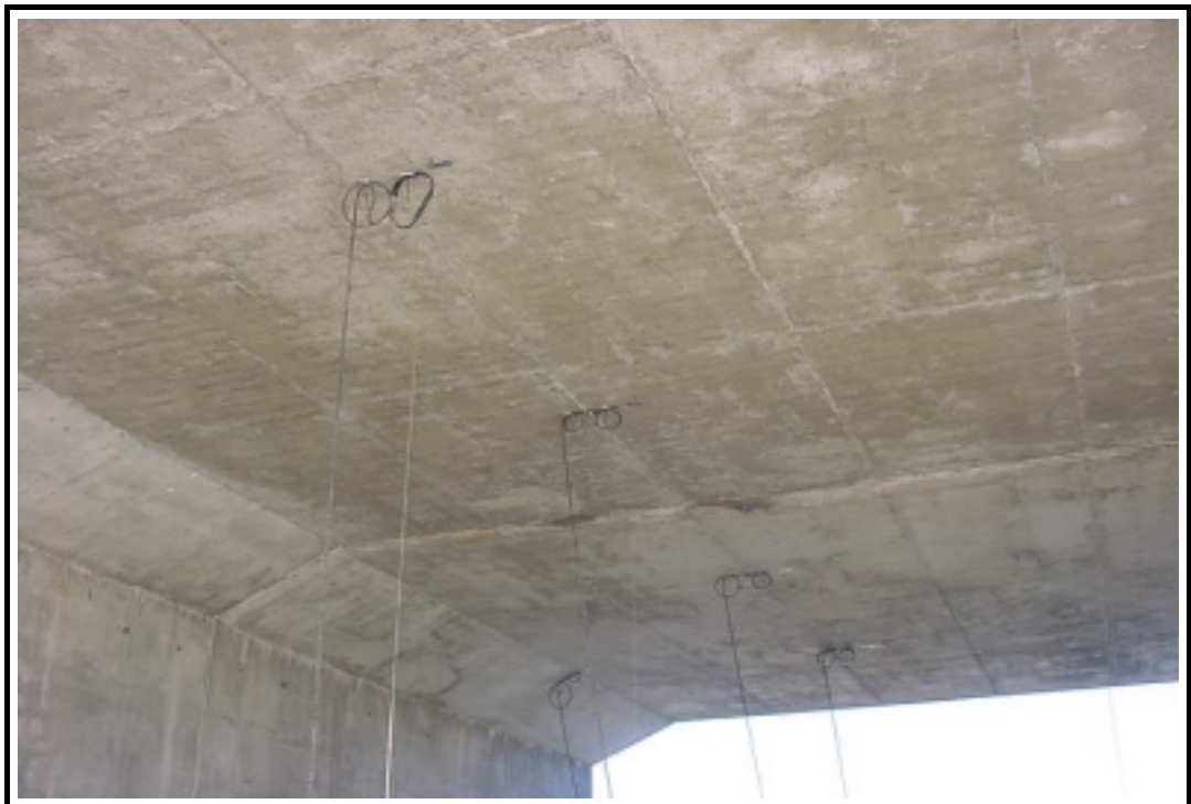
Foto 8: Línea de bandas extensométricas
