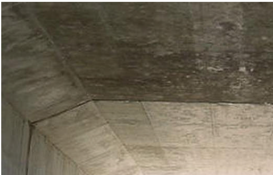
Foto8: Detalle de junta longitudinal
