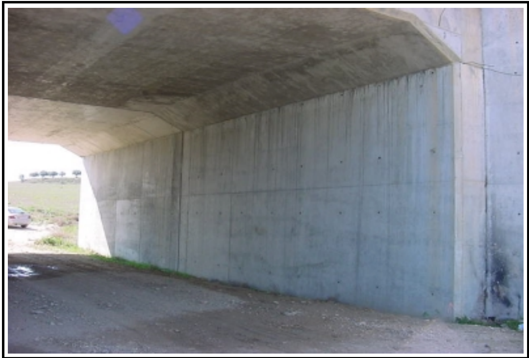
Foto 3: Vista general de estribo de entrada
