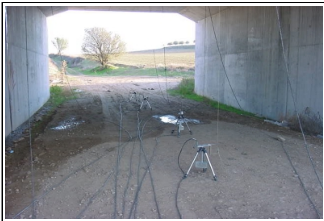
Foto 7: Línea de ménsulas en centro de vano
