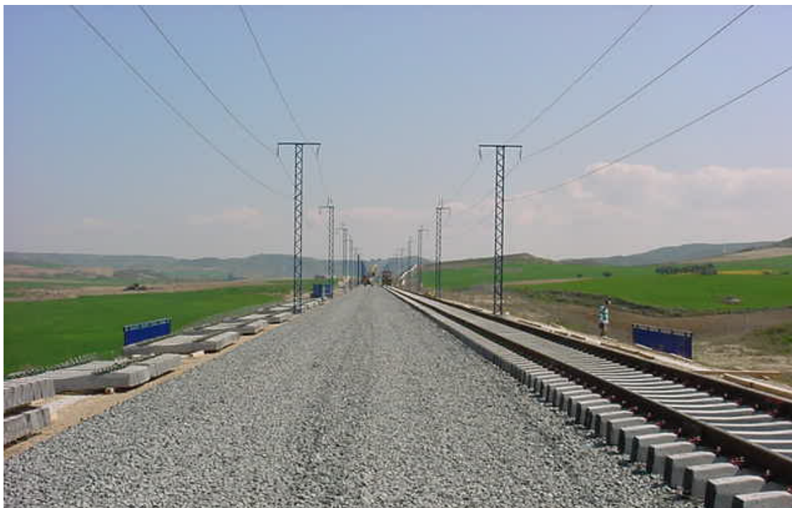
Foto3: Vista superior desde entrada
