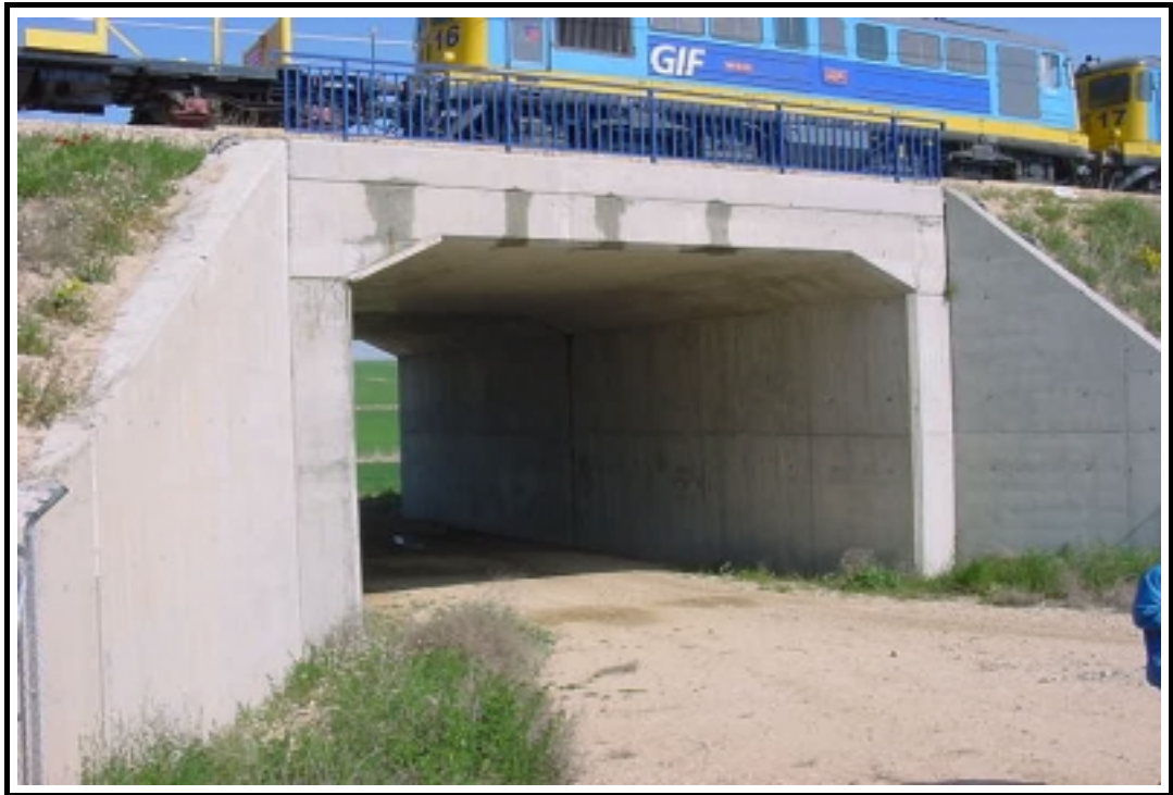
Foto 1: Vista general de la estructura
