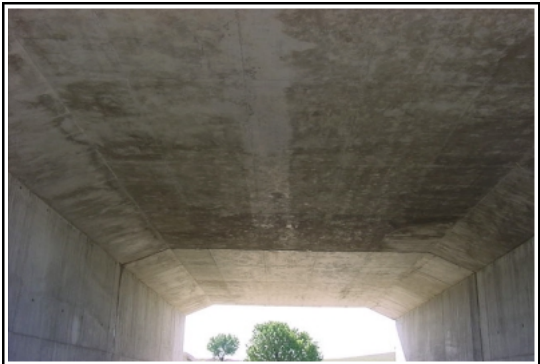
Foto 4: Vista inferior de la estructura
