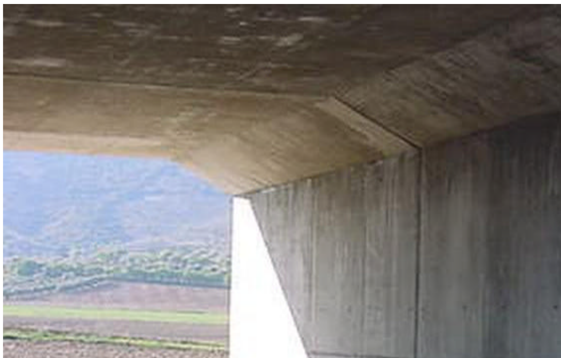
Foto6: Detalle de junta longitudinal
