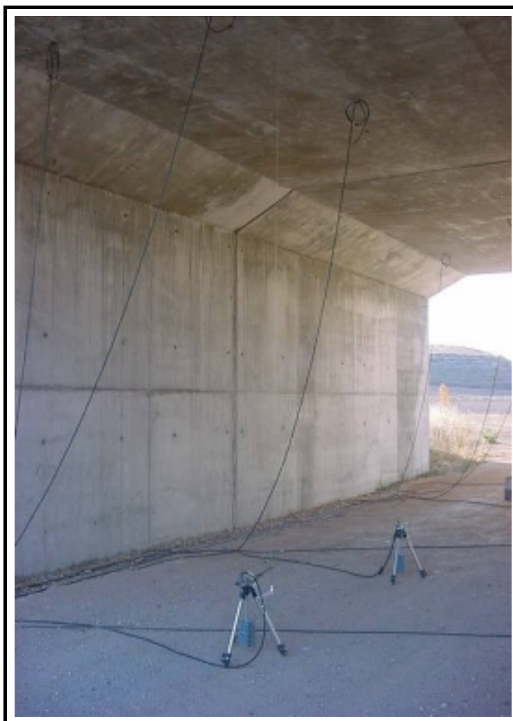
Foto 5: Línea de ménsulas en centro de vano
