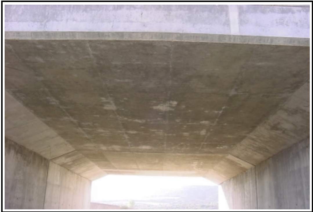
Foto 3: Vista inferior de la estructura
