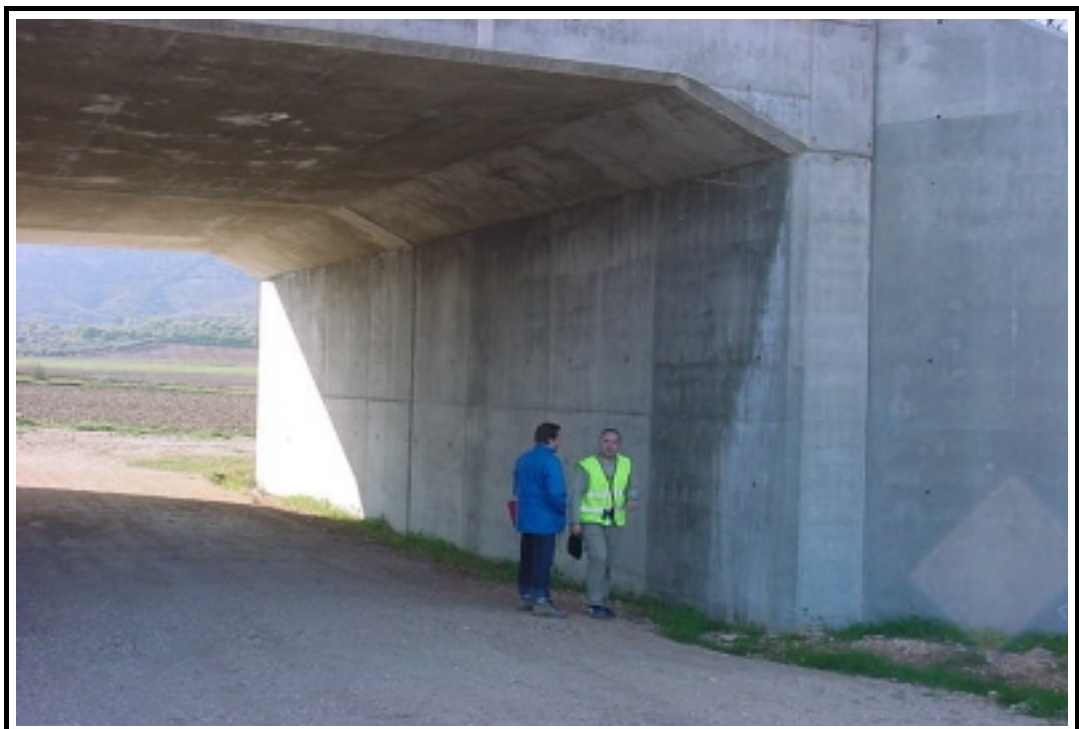
Foto 2: Vista general de estribo de entrada
