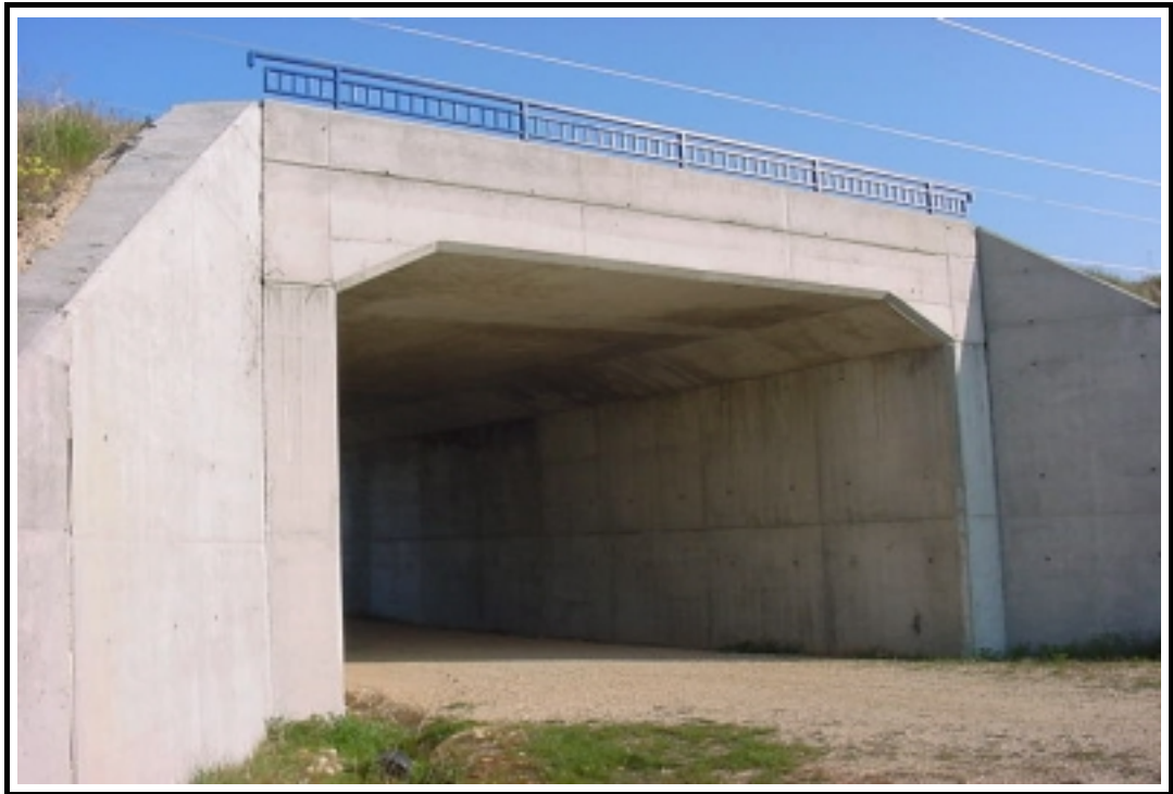
Foto 1: Vista general de la estructura
