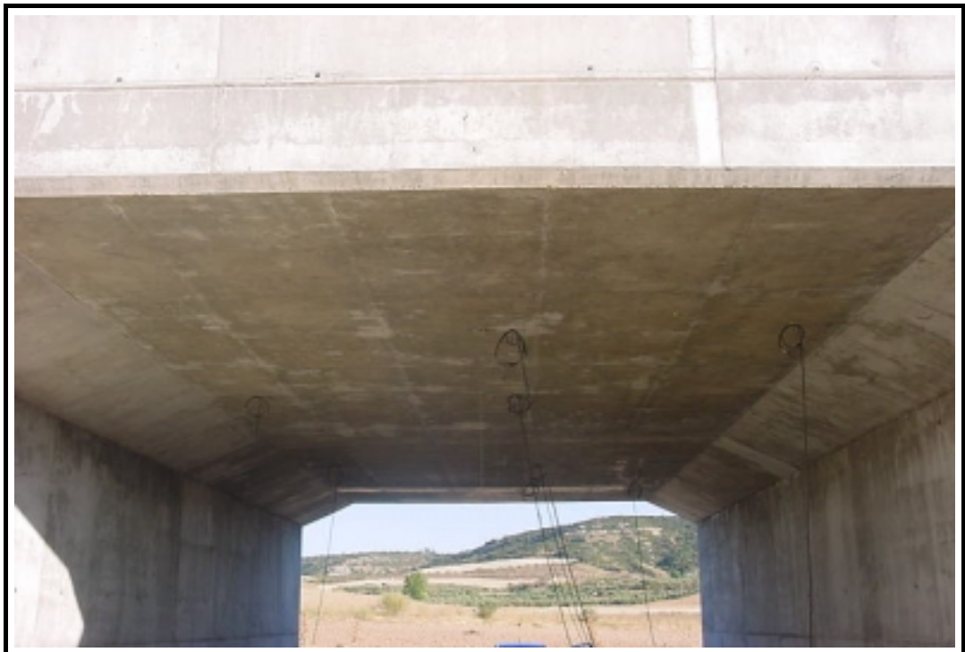
Foto 4: Línea de bandas extensométricas en centro de vano
